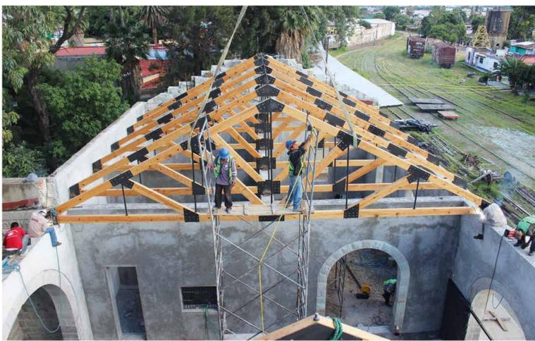
—Integración de armaduras de madera. Vista aérea del proceso de obra.
