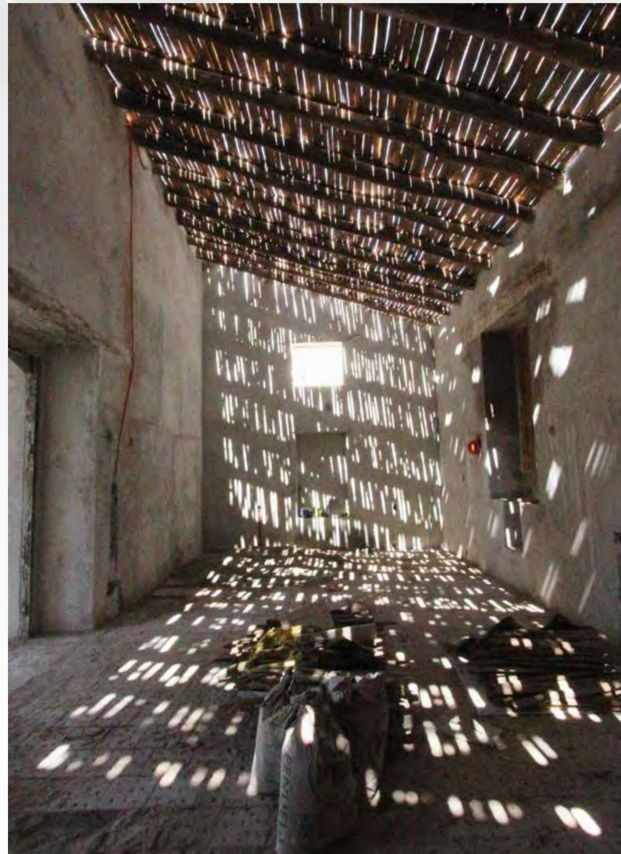
—Sala grande o Yoo Bidó. Disposición de biliguanas sobre el sistema de morillos.
