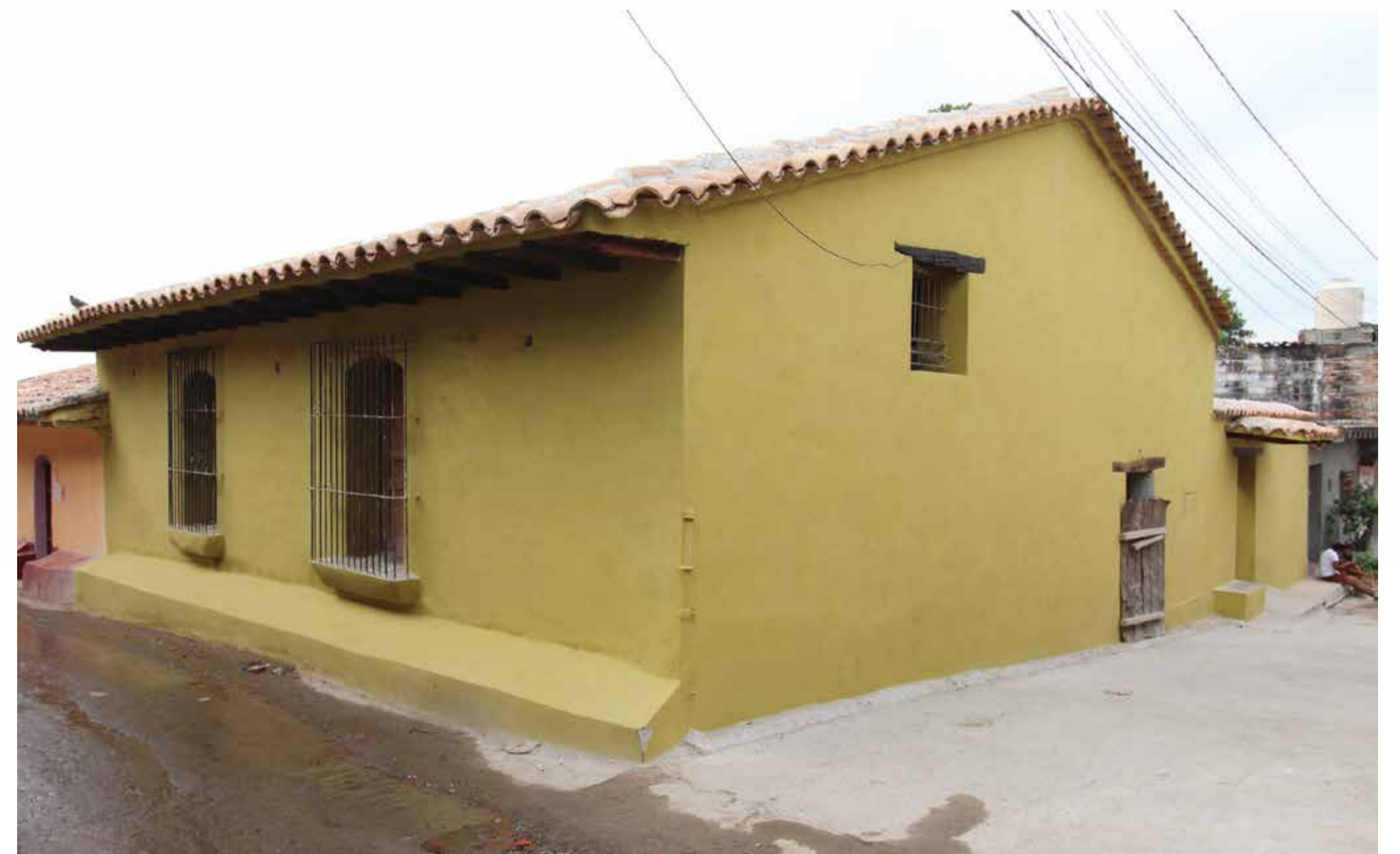
—Una pronunciada cubierta de tejavana, vanos verticales salientes y muros gruesos de adobe, caracterizan a las antiguas casas de Tehuantepec.
