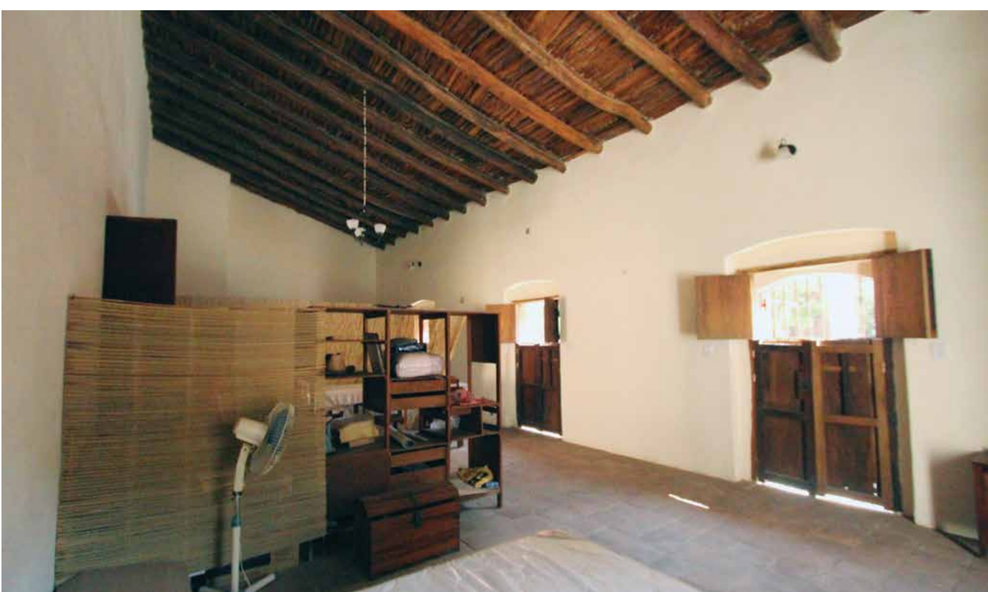
—Un par de hojas superiores e inferiores de las ventanas regulan la ventilación e iluminación del Yoo Bidó o sala grande.
