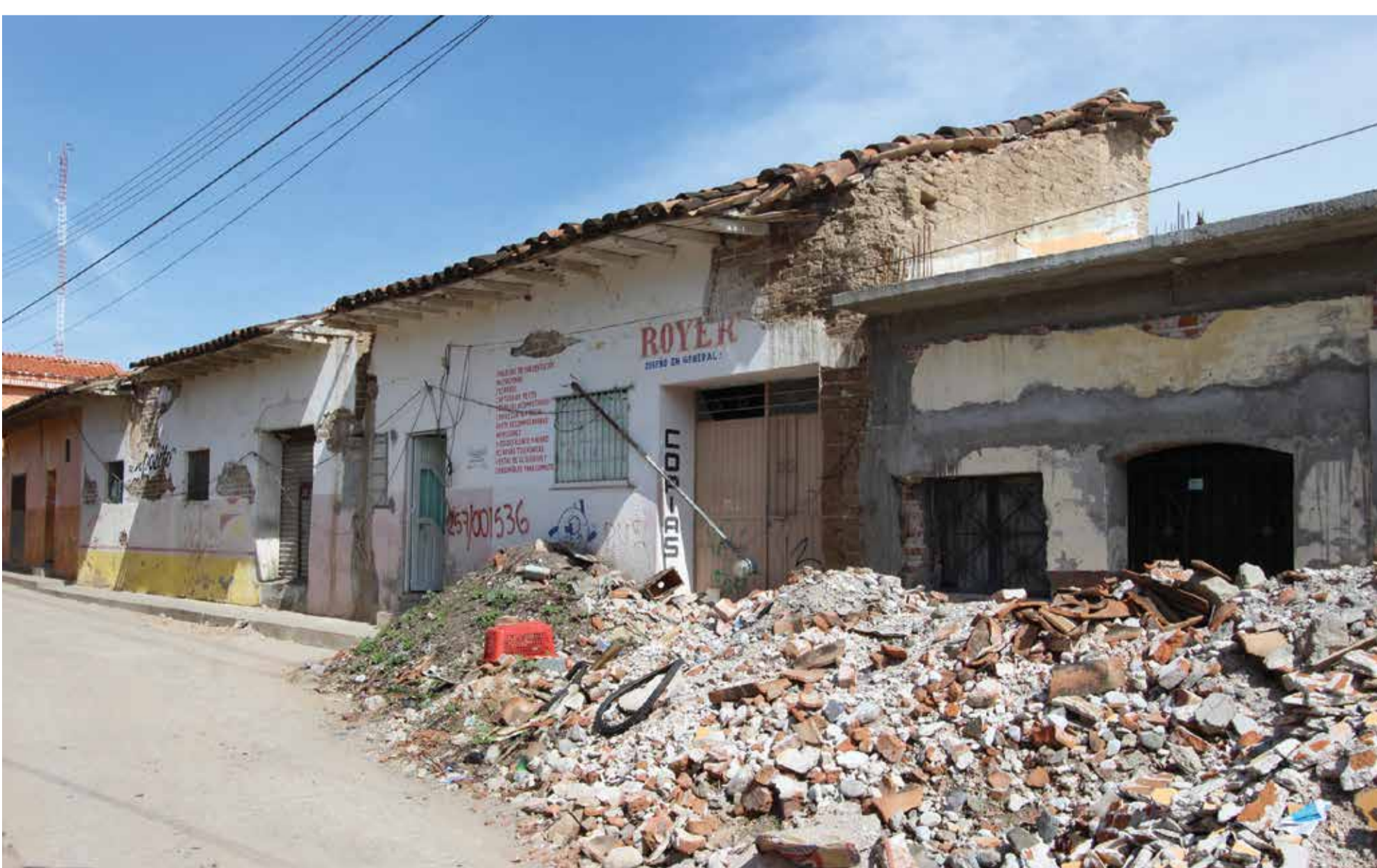
—Daños estructurales en muros provocado por el debilitamiento de vanos agregados y eliminación de dinteles de madera.
