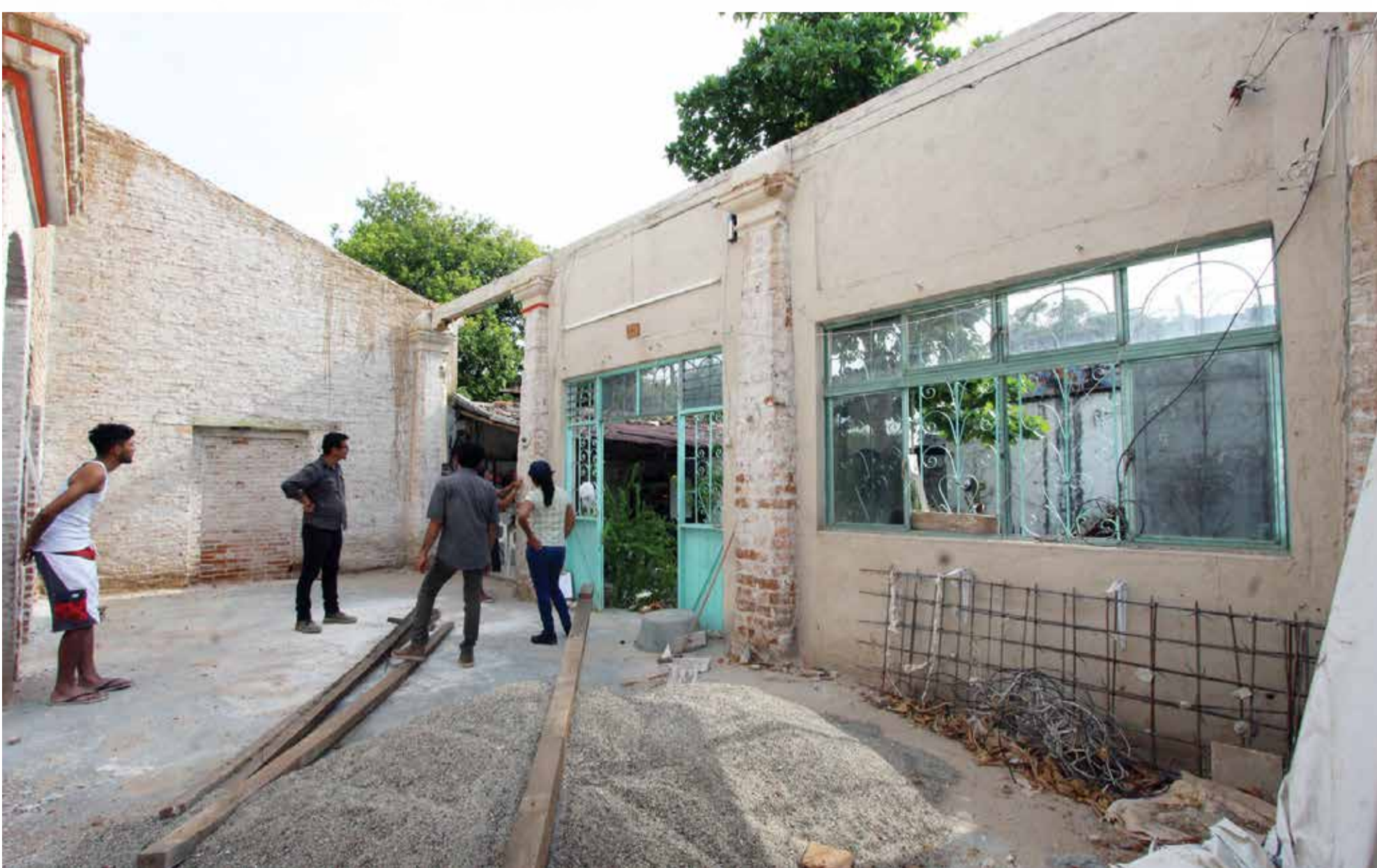
—Pilares embebidos, cadena y muros divisorios afectaron el sistema constructivo de la casa.
