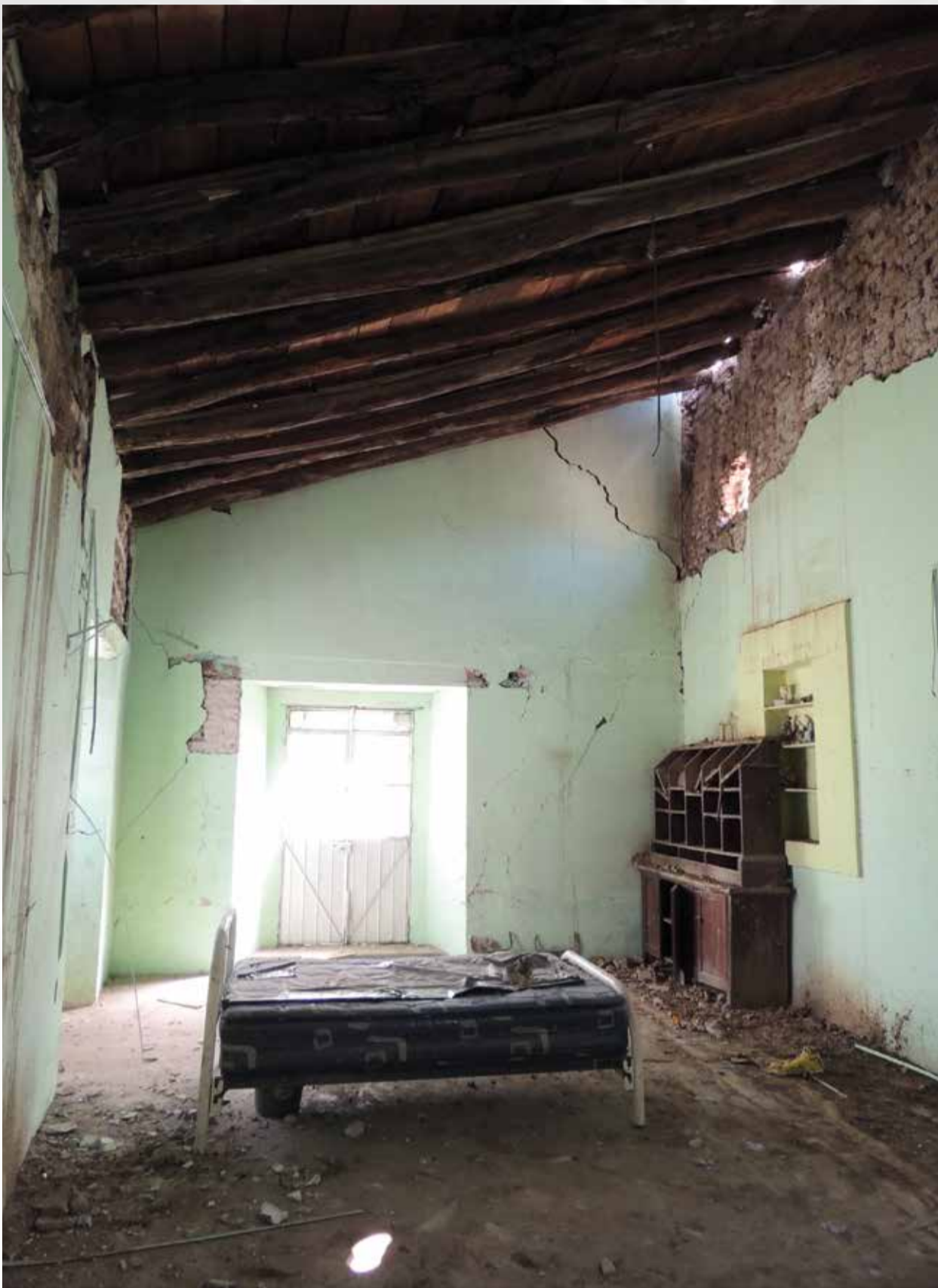
—Debido al desplazamiento de la cubierta y morillos, los muros presentan severos daños.
