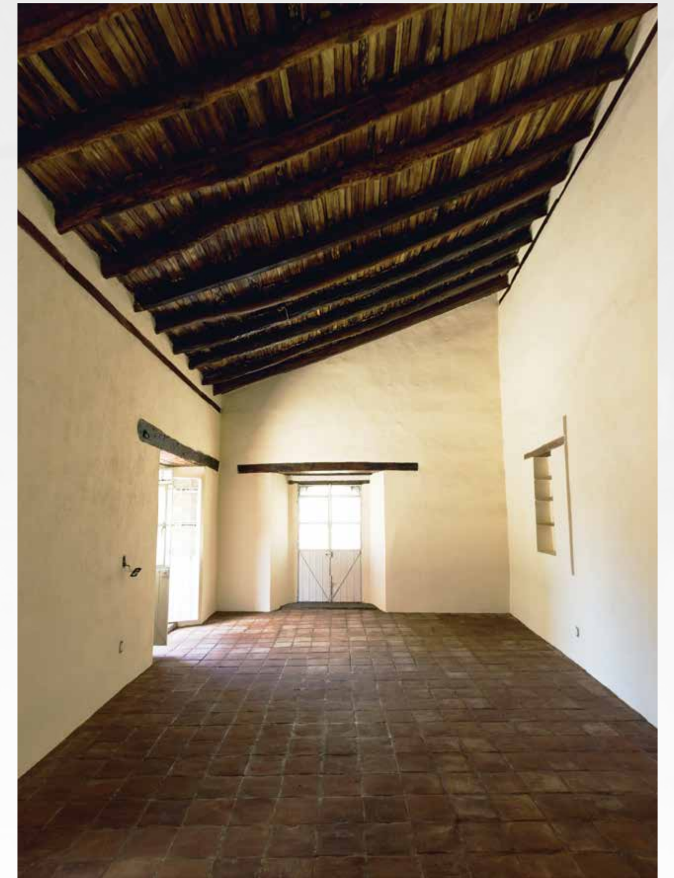
—Integración de vigas de arrastre en cerramiento de muro para mejorar el comportamiento ante sismo.
