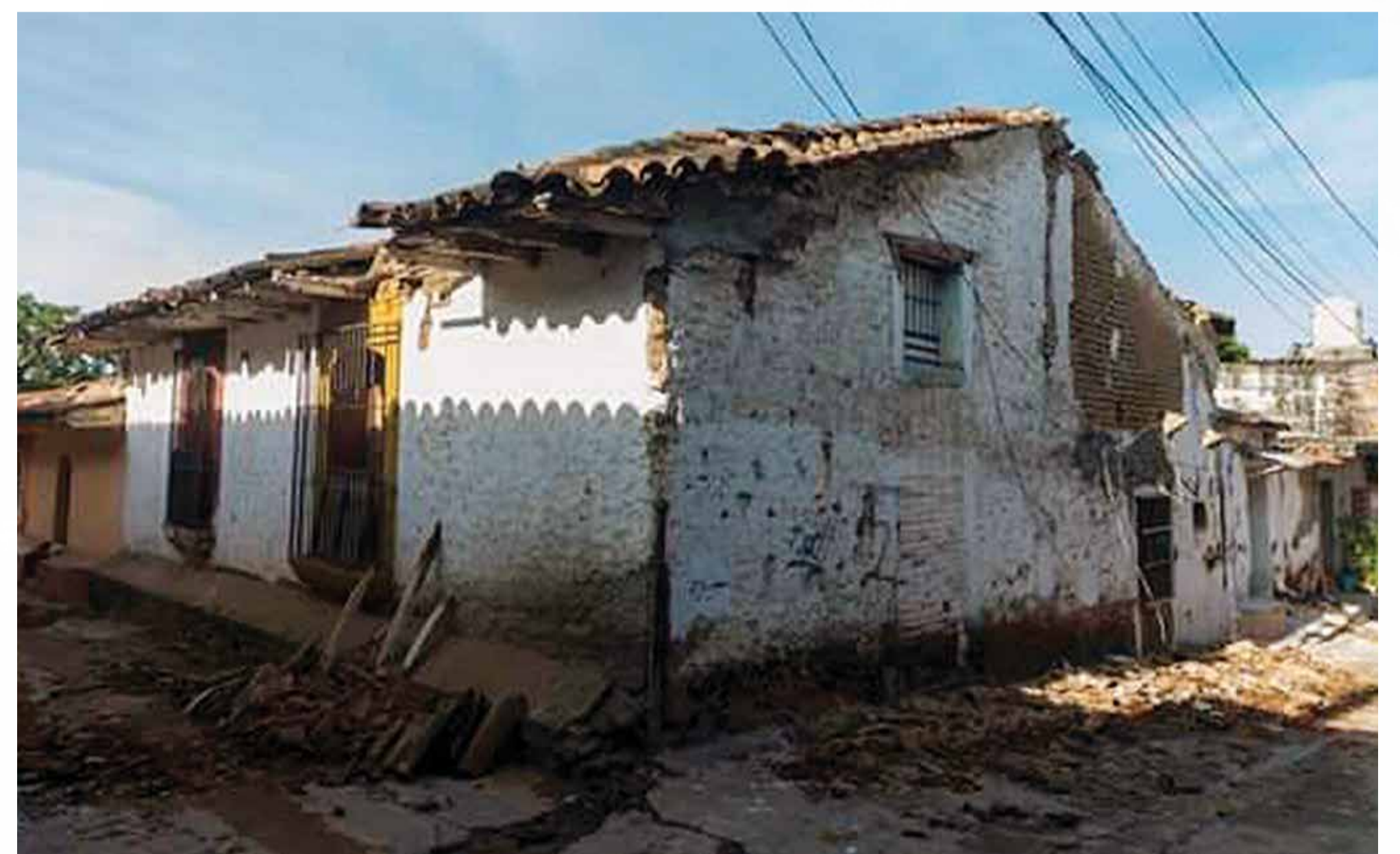
—Colapso parcial de cubierta y fracturas en muros de adobe.
