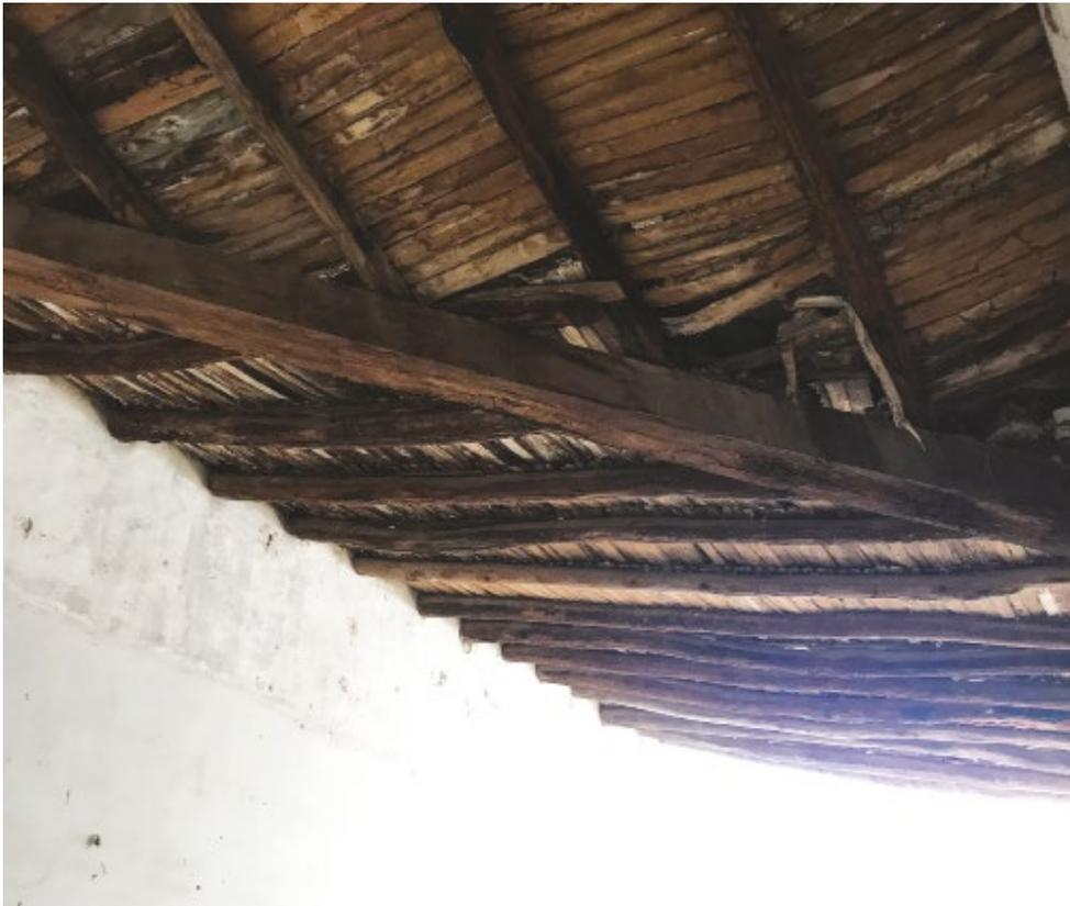
Cubierta de estructura de madera (morillos y biliguanas)
