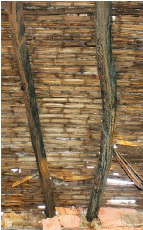
Techo de teja con estructura de madera a base de Oate sobre morillos
