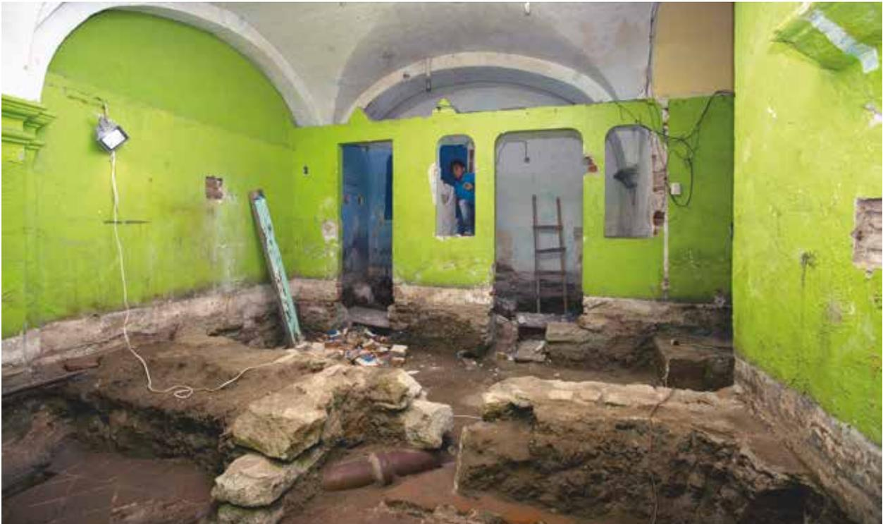
— Los rellenos que cubrían los pisos alcanzaban hasta un metro y medio de espesor.
