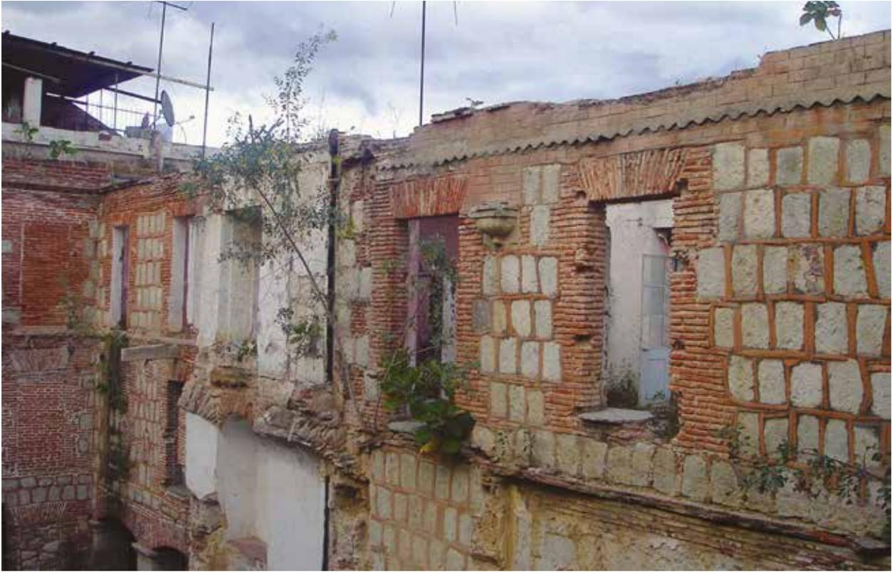
— El inmueble sufrió la mutilación de muros, vanos, arcos y cubiertas, quedando completamente expuesto a la intemperie.
