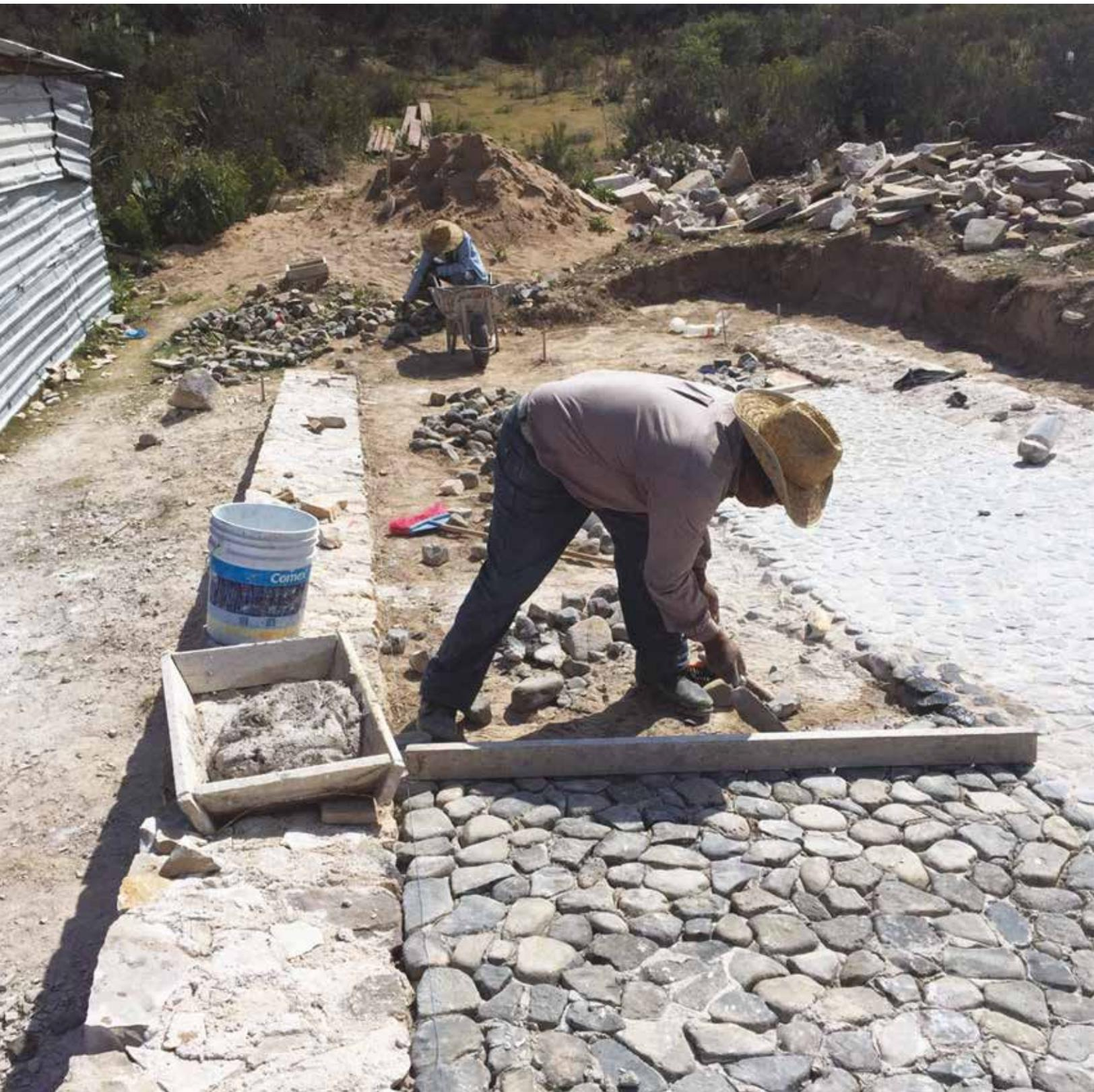
— Recuperación del arroyo del puente con piedra bola para detener su erosión.
