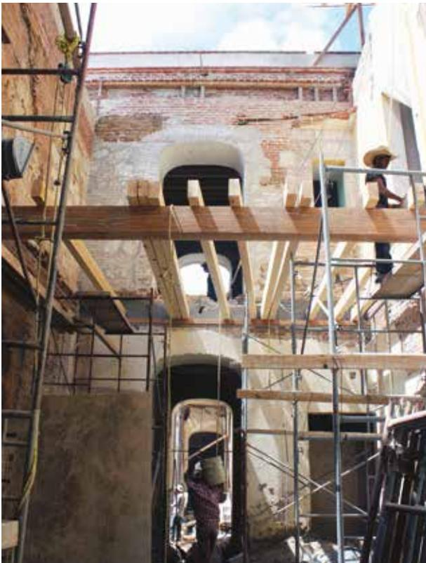
— Las secciones de vigería fueron sustituidas ante la pérdida de capacidad estructural de la madera.
