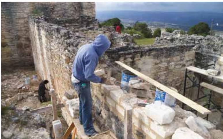
— Recuperación de niveles de muros con piedra endeque para la reconstrucción de la cubierta tradicional.
