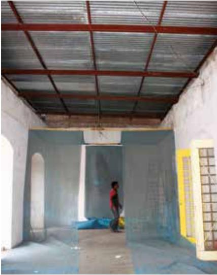
— Una de las crujías mostraba una cubierta de lámina y montén.
