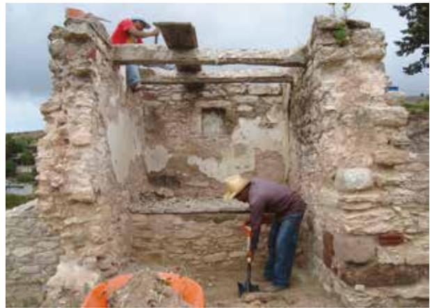
— El agregado de elementos de concreto en las capillas, afectó el comportamiento estructural de los muros de mampostería.
