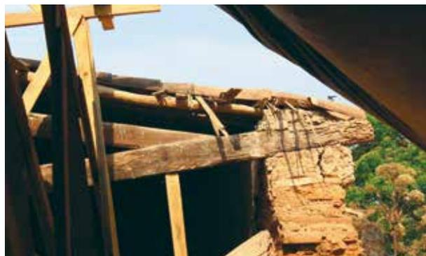
— Sistema tradicional de muros de adobe y cubierta de madera.
