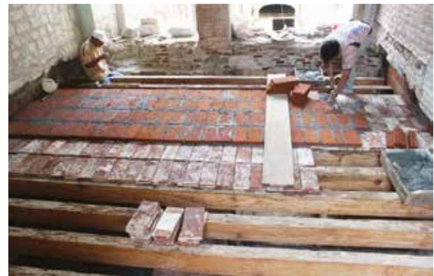
— Sistema tradicional de cubierta de vigas de madera y enladrillado.
