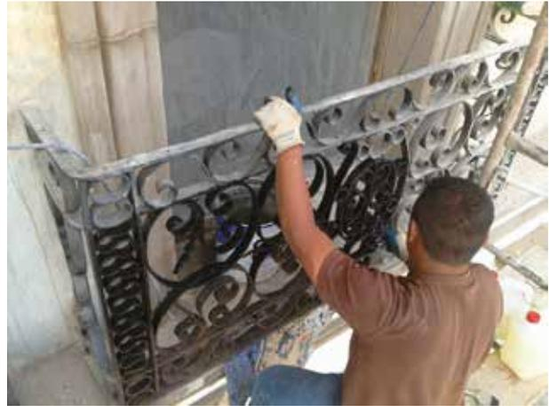
— Además de la limpieza de la herrería se aplicaron técnicas de pasivación de óxidos.
