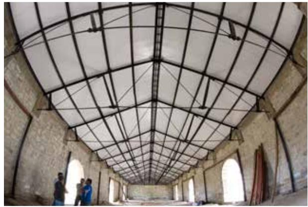
— Se sustituyó la lámina de asbesto por paneles aislantes.
