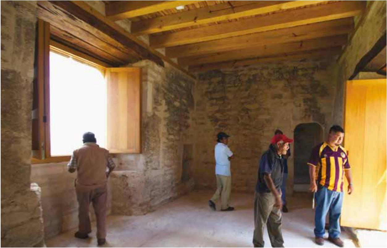
— Los testigos de cal detectados en la parte inferior de los muros, permitieron recuperar los niveles originales con la integración de pisos de cal.
