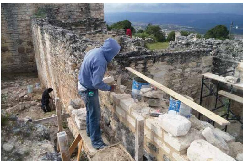
*Recuperación de niveles de muros con piedra endeque para la reconstrucción de la cubierta tradicional.*
