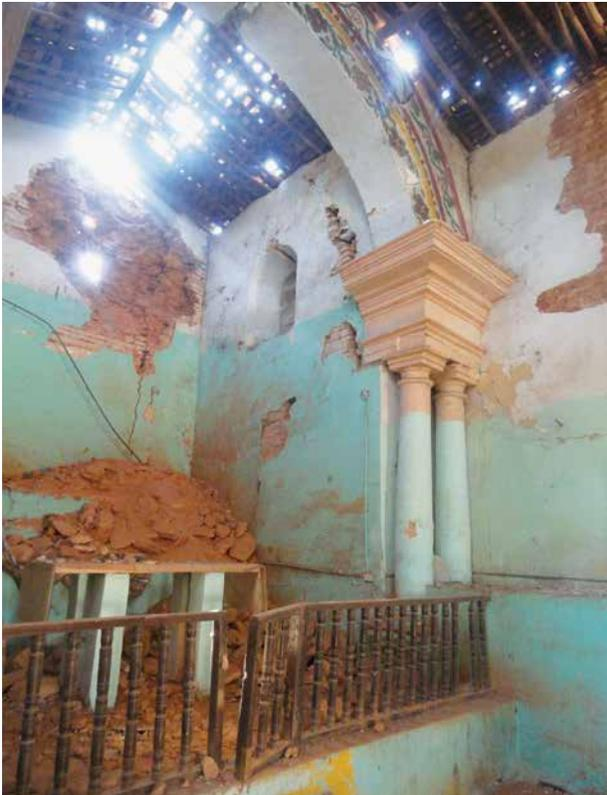
*Colapso del muro testero y cubierta del ábside.*
