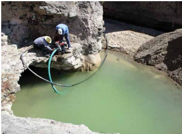
*Desasolve del río para estabilizar la estructura del puente.*
