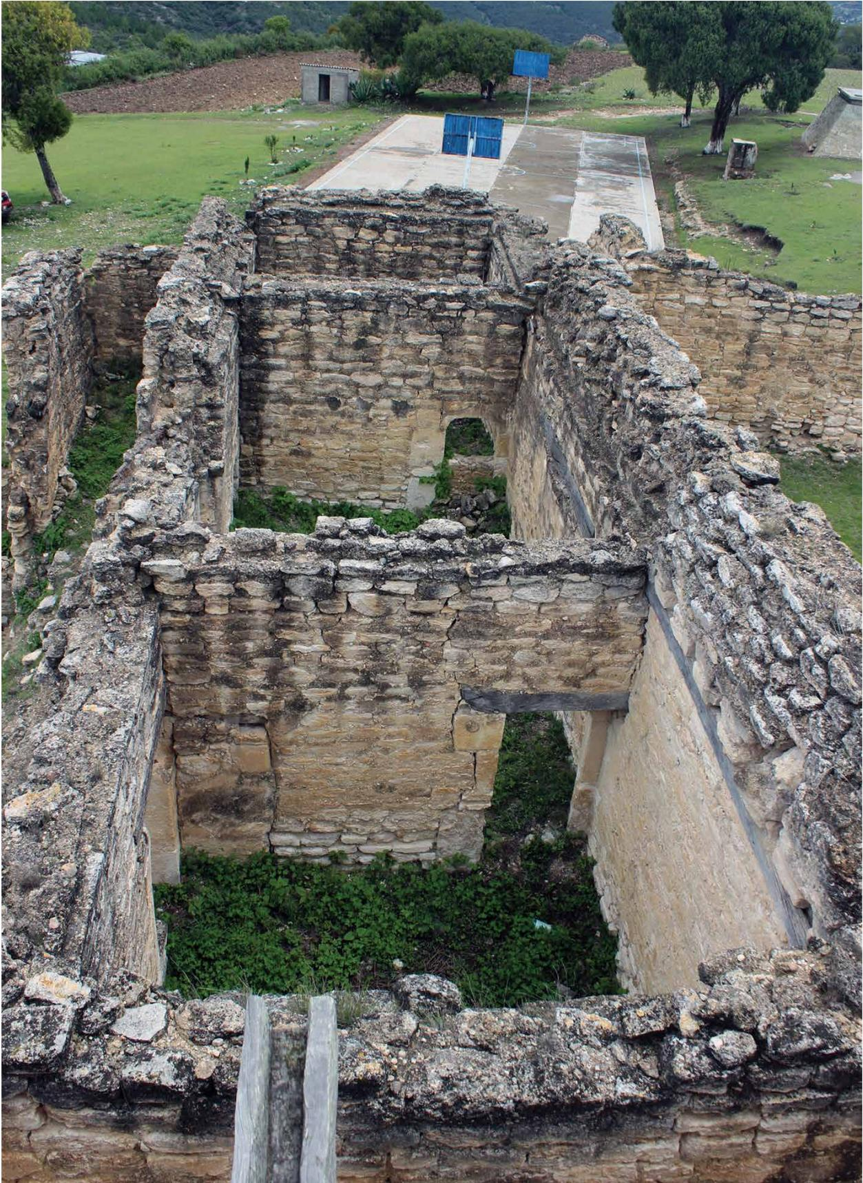
*El espacio sufrió la mutilación de sus vanos, el agregado de elementos y el colapso de su cubierta dejando los muros expuestos a la intemperie y a merced de los sismos.*
