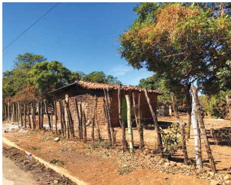
Muros de horcones, varas y barro donde se aprecia parte de la cubierta en tejavana.
