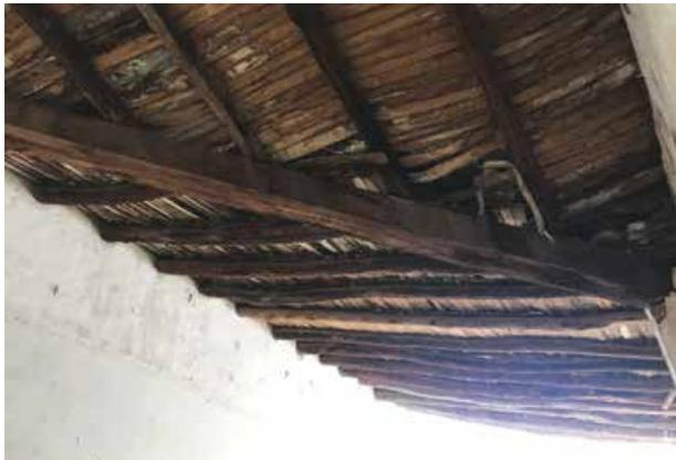
Detalle constructivo de cubierta. Viga de carga soportando morillos y biliguanas.
