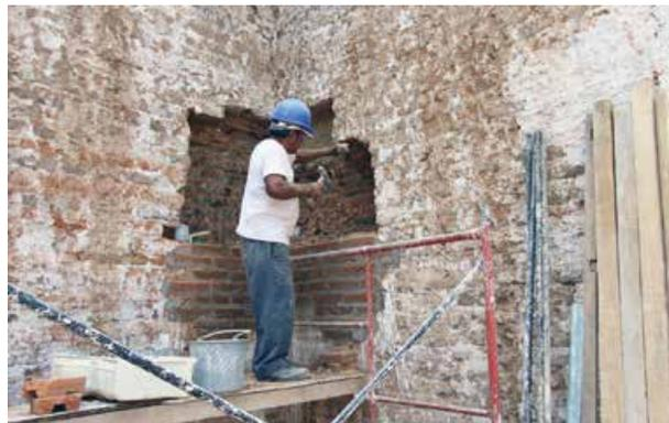
Consolidación de uniones de muros, en el proceso se empleó ladrillo de barro rojo, previa liberación puntual de las piezas fracturadas.
