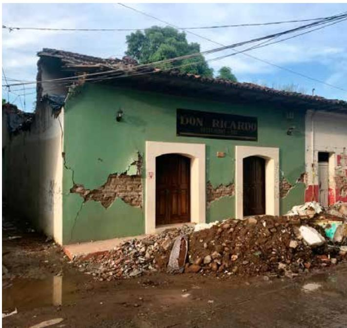
Vista de alzado principal donde se observa la presencia de escombros y pérdida de adobes en el cerramiento del muro.
