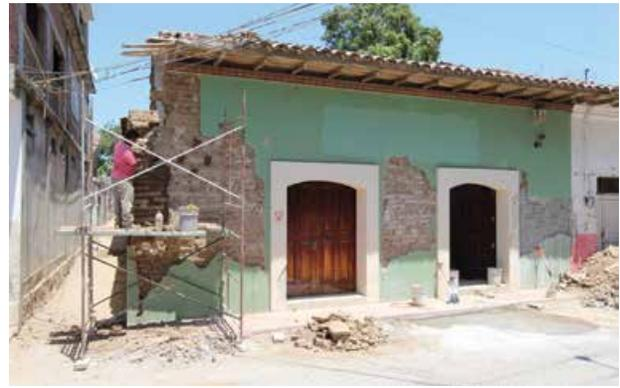
Reconstrucción y reforzamiento de esquina en área colapsada.
