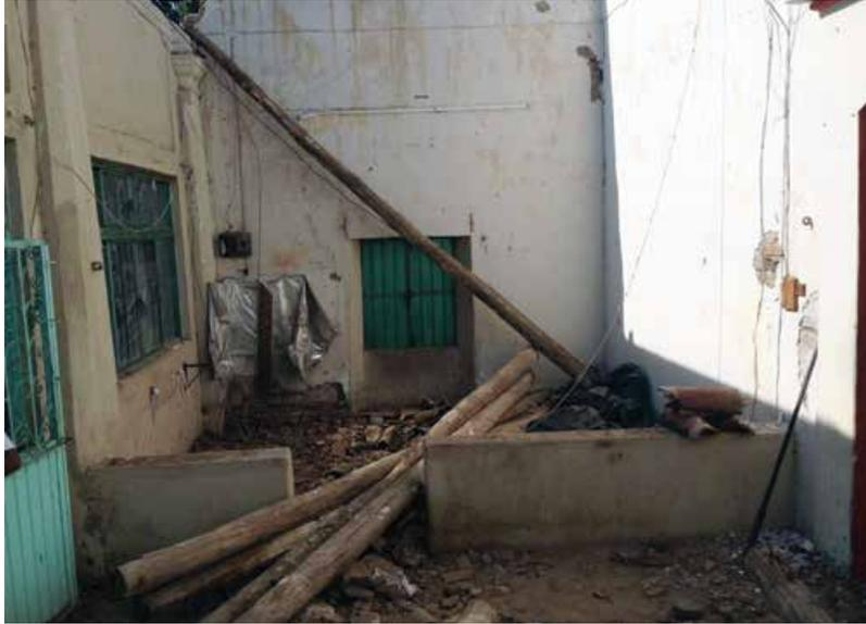
Interior del corredor. Se aprecian los agregados entre columnas y muros divisorios.
