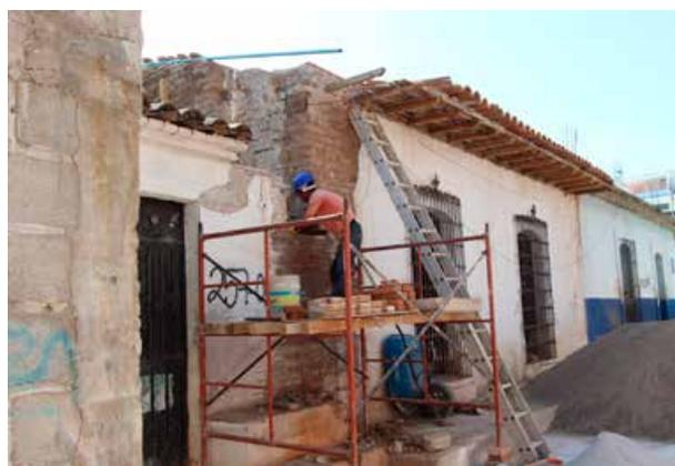
Reforzamiento de uniones de muros, mediante la utilización de ladrillo de barro rojo.
