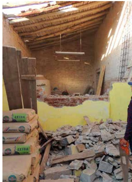
Integración de aplanados en parte superior del muro.
