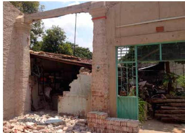
Libерación de muro divisorio en interior, agregado en claro de columnas.
