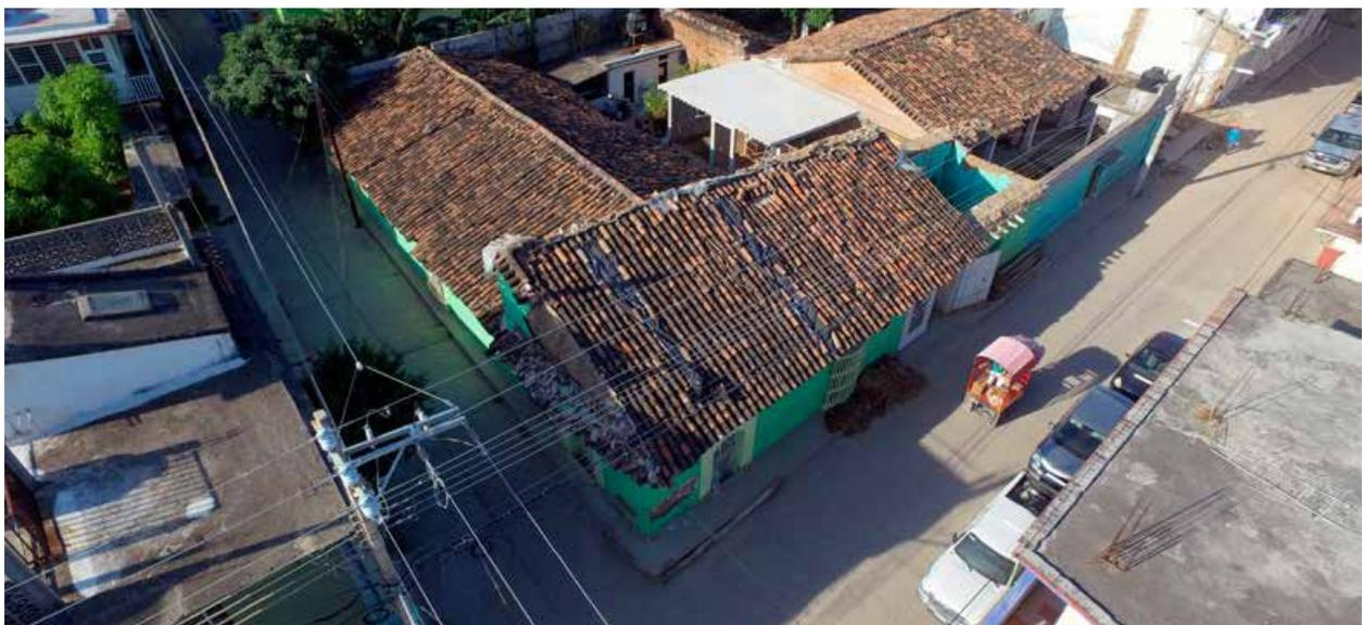
Vista de cubierta a base de teja con colapsos parciales y hundimiento en áreas.
