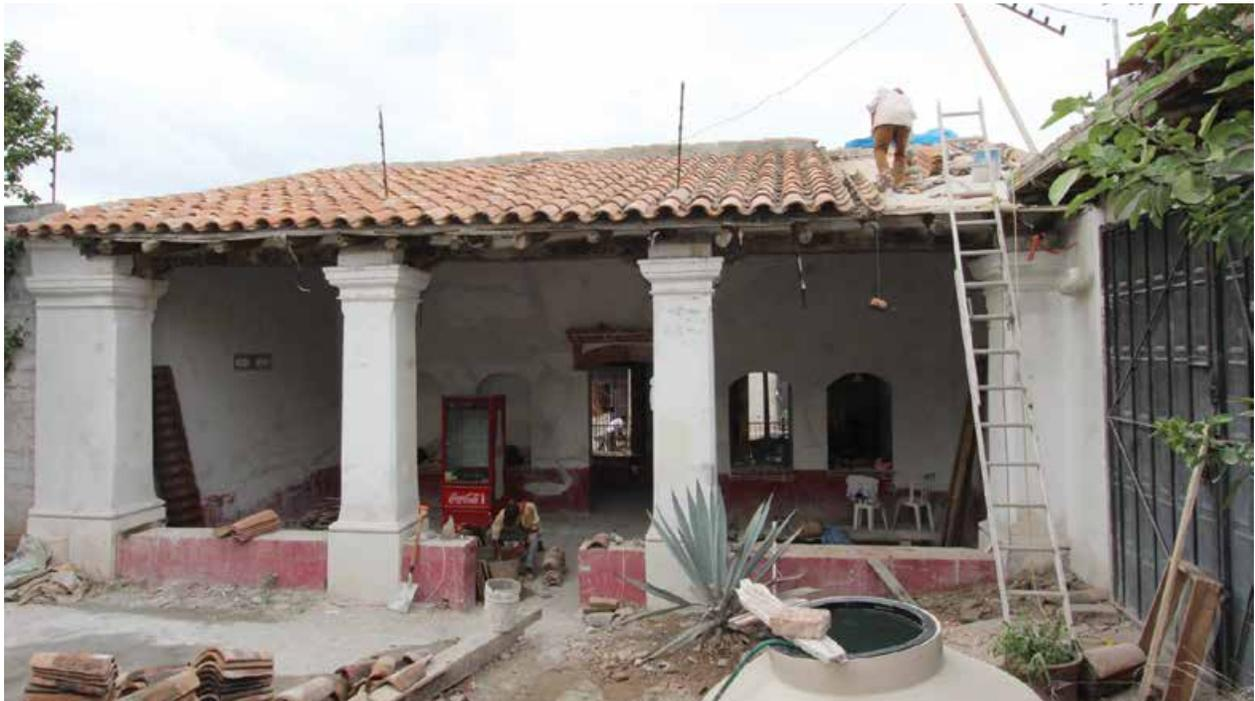
Reintegración de tejas de barro en cubierta.
