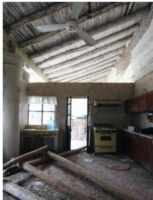
Vista de agregado de muro divisorio del corredor y colpaso de morillos de madera.
