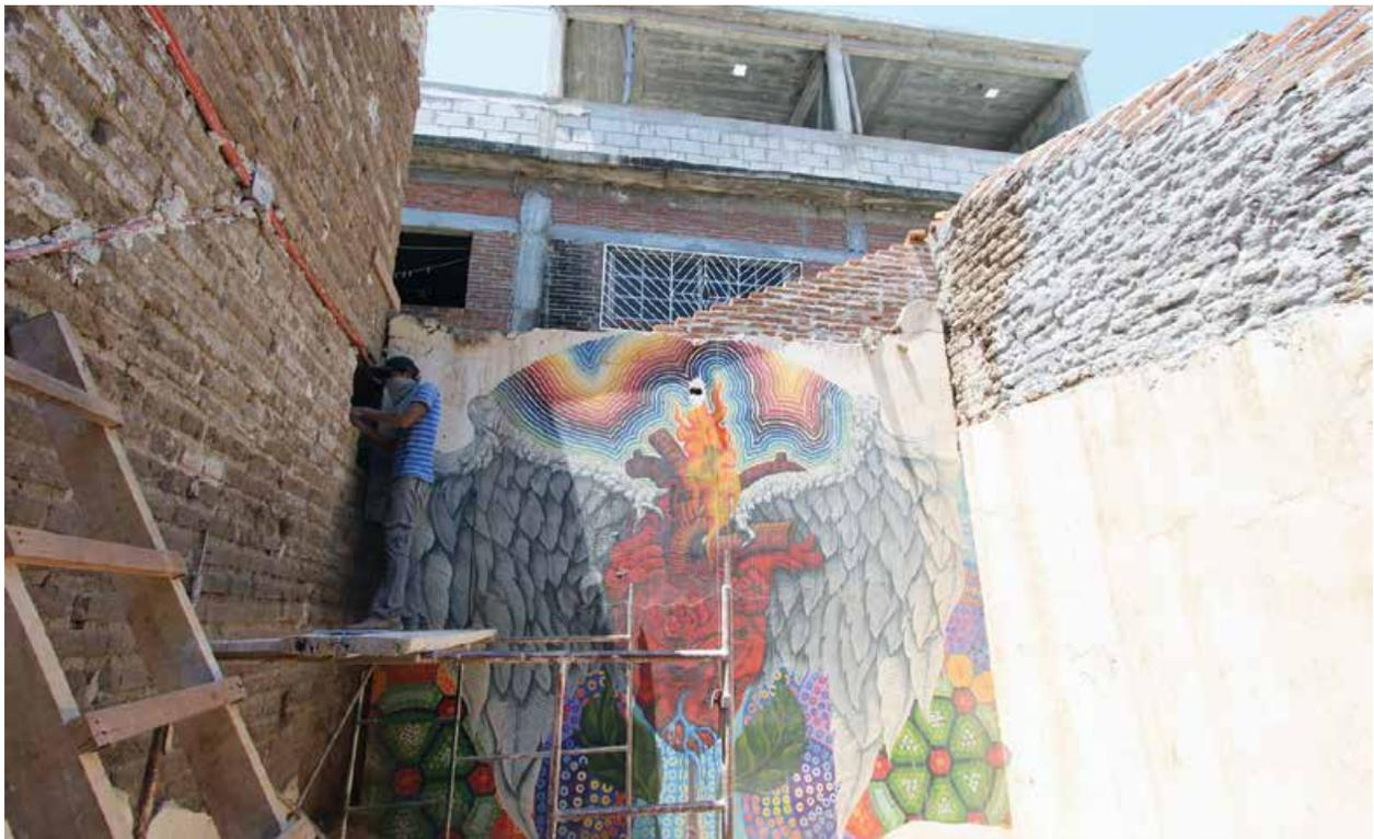
Liberación de juntas disgregadas y piezas fracturadas.
