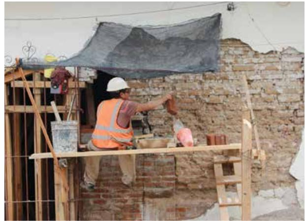
Reforzamiento y reconstrucción de muros, mediante la utilización de ladrillo rojo de barro, respetando la proporción y espesor de los muros.
