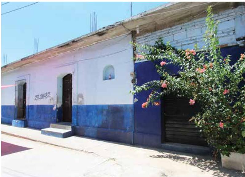
La cubierta tradicional de la casa había sido sustituida por una losa de concreto reforzado. Sin embargo, conserva un nicho, vanos, escalones y protección de herrería propias de la fachada tradicional.
