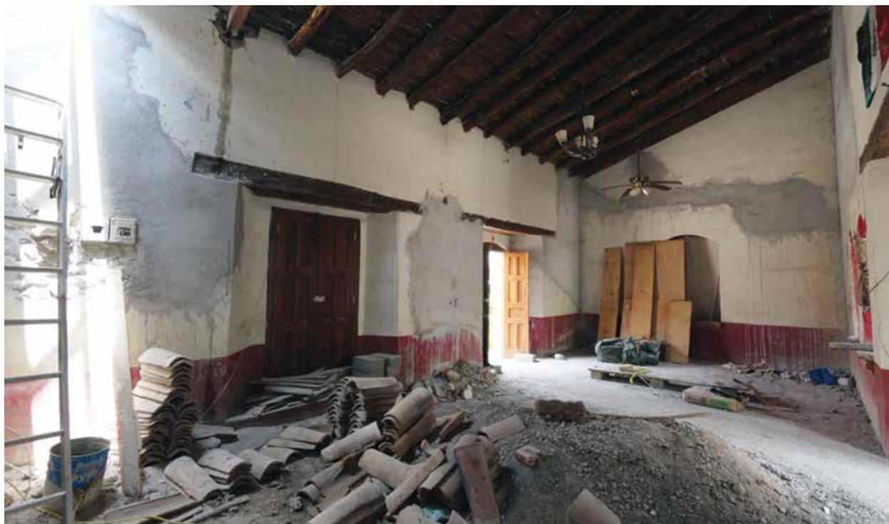
Proceso de recuperación de tejas de barro en área de colapso de cubierta.
