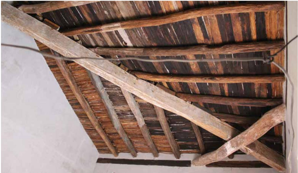
Detalle de cubierta de madera a base de vigas, morillos y biliguanas.
