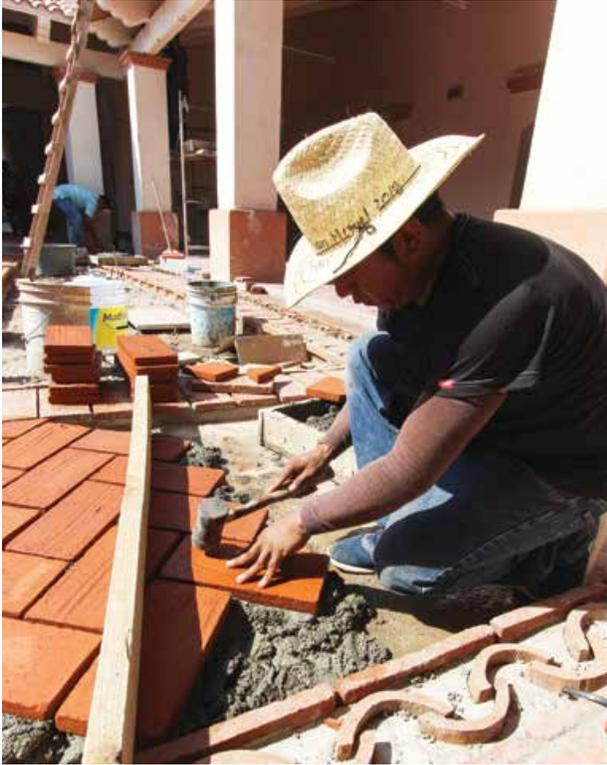
Colocación de pisos de ladrillo de barro cocido.
