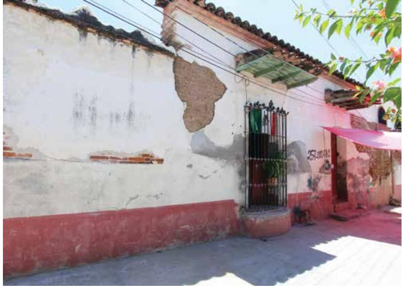
La fachada muestra el sistema tradicional de alero para proteger los vanos y un balcón con protección de herrería.
