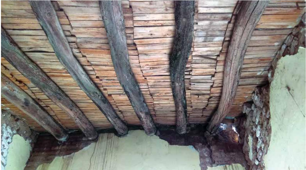
Detalle de cubierta, morillos y biliguanas sobre muro de adobe.
