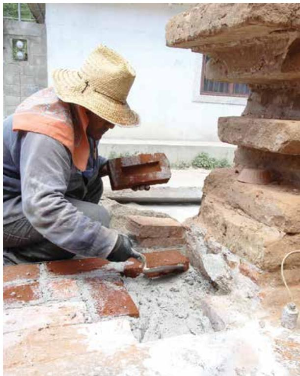
Reconstrucción de muro, de acuerdo al espesor, mediante ladrillo de barro rojo.
