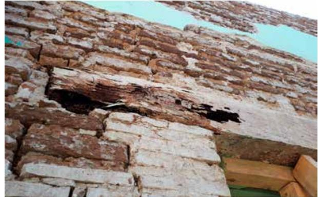
Detalle de reforzamiento con ladrillo de barro en vano sobre muro de adobe y cerramiento de dintel de madera.
