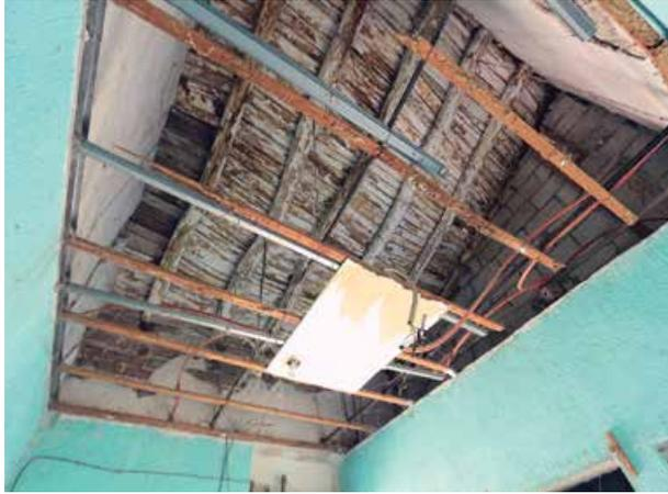
Estructura de falso plafón, el cual ocultaba el estado de conservación de la cubierta.
