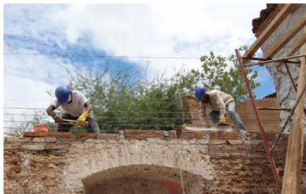
Mejoramiento del sistema estructural mediante la integración de un cerramiento de ladrillo de barro.
