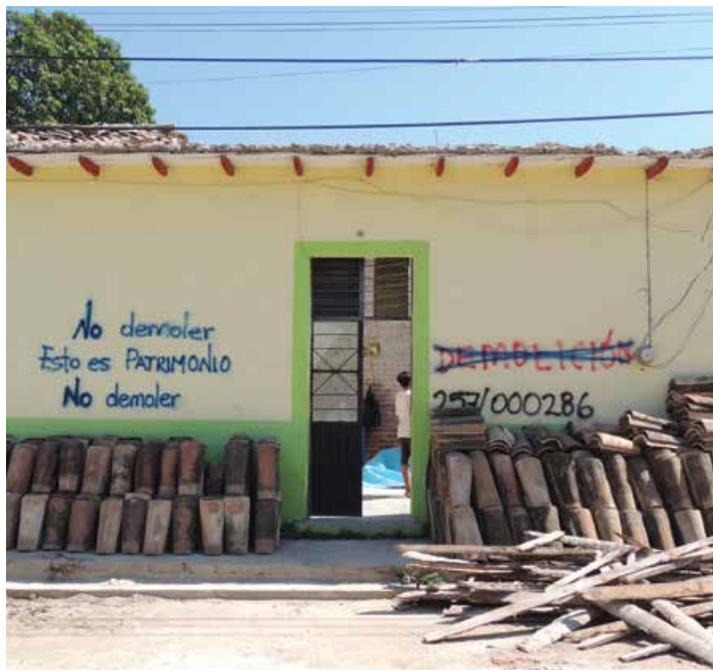
Fachada principal de la casa, al frente se observan tejas y biliguanas recuperadas de la cubierta colapsada.
