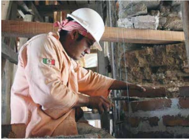
Reforzamiento de muro mediante la integración de materiales similares de carga y comportamiento.
