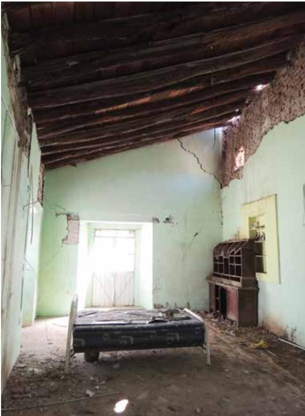
Sala principal. En la parte superior de los muros se aprecia la viga de arrastre como parte del mejoramiento del sistema constructivo.
