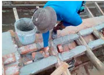
Colocación de morillos sobre cerramiento de muro ladrillo de barro rojo, mejorando así el comportamiento de desplazamiento de los elementos.
