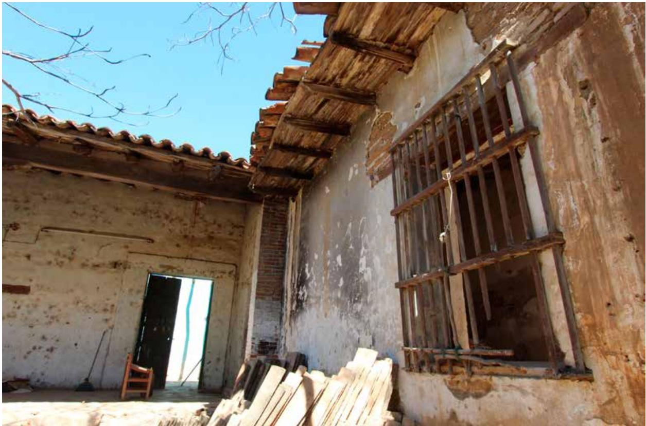
Vista interior de casa tradicional, en ella se observan muros de adobe, protecciones de madera en ventanas, aleros y cubiertas soportadas por viga madre, morillos, biliguanas y tejas de barro.
