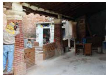
Liberación de capas de pintura sobrepuesta en ladrillos de las columnas del corredor.
