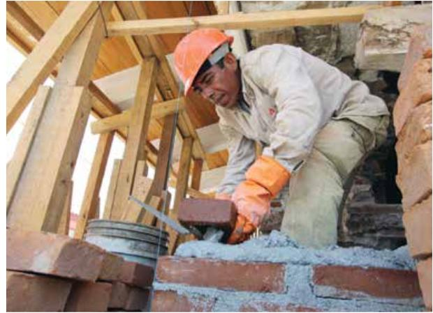
Reforzamiento de esquina de casa mediante integración de ladrillos de barro en unión de muros de adobe.
