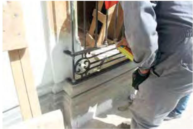
— Eliminación y pasivación de óxidos en las protecciones de herrería.
