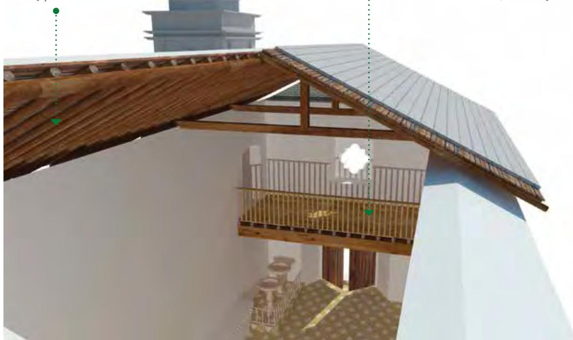
Construcción del coro con vigas de carga y arrastres de madera de enebro, entablado y balastrés.
