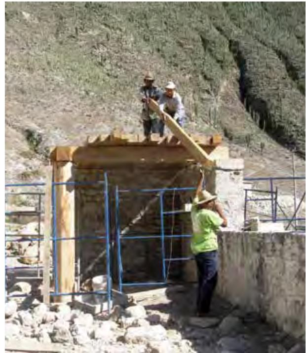
— Las capillas posas son de cubierta inclinada, vigería de madera y ladrillo de barro rojo.
