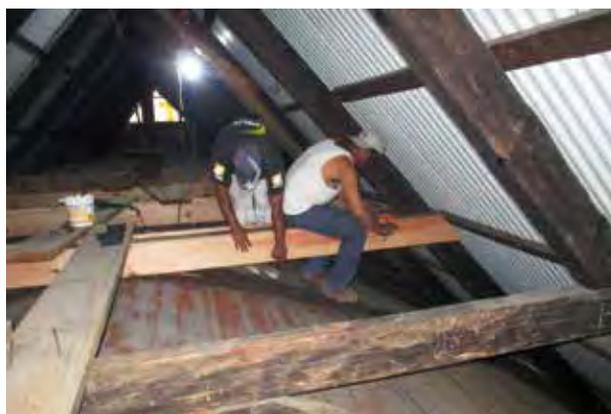
— Reforzamiento de los jabalcones y tirantes mediante cachetes de madera y abrazaderas metálicas.
