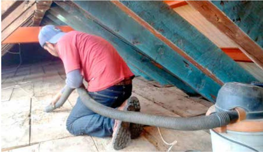
— Para limpiar la armadura, se utilizó una aspiradora con una presión controlada.
