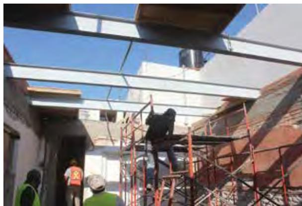
— Construcción de cubierta de bóvedas catalanas de ladrillo con vigas de metálicas, por analogía a la cubierta lateral.
