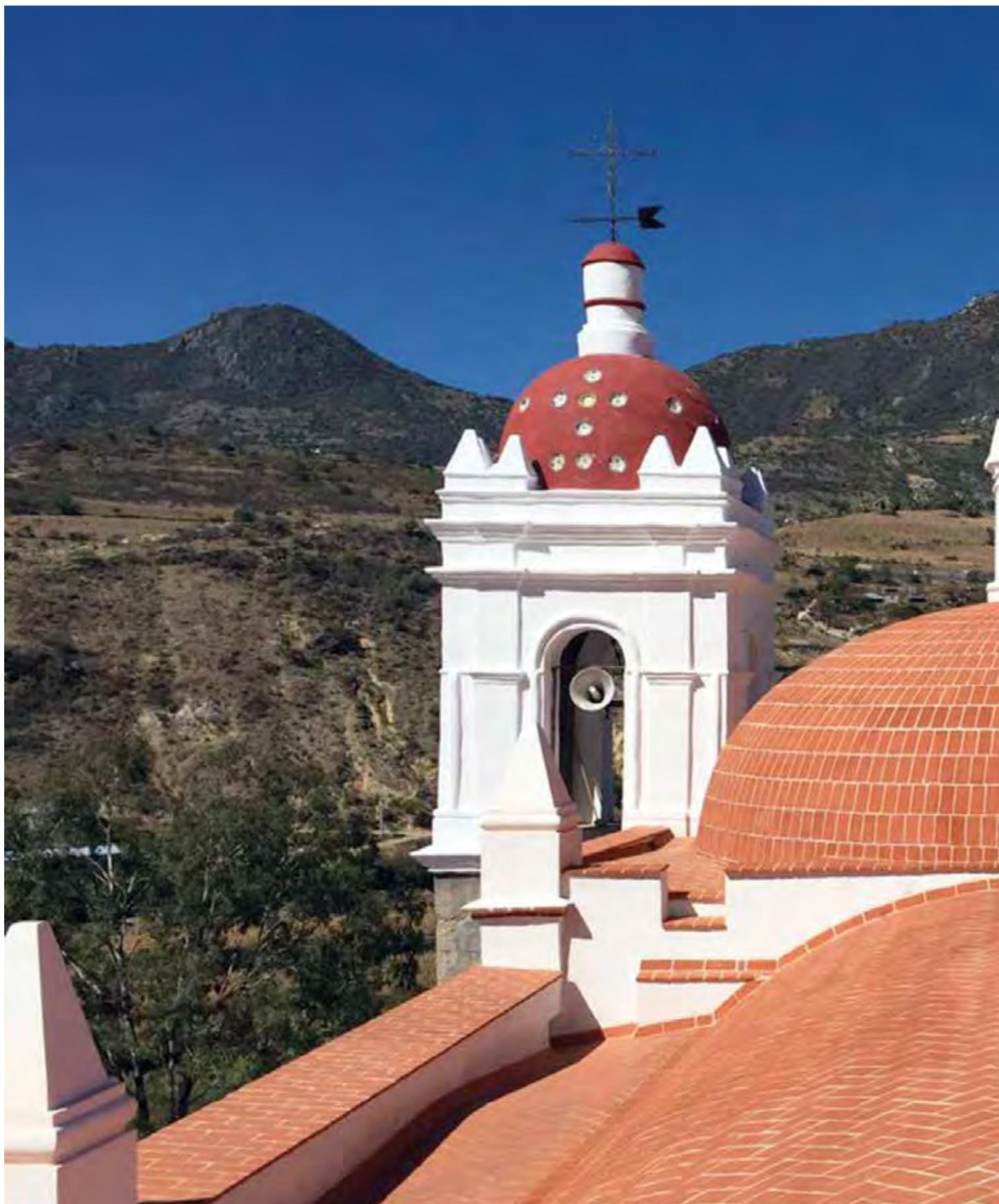
— Cubierta restaurada mediante la utilización de ladrillo de barro rojo y pintura a base de cal.
