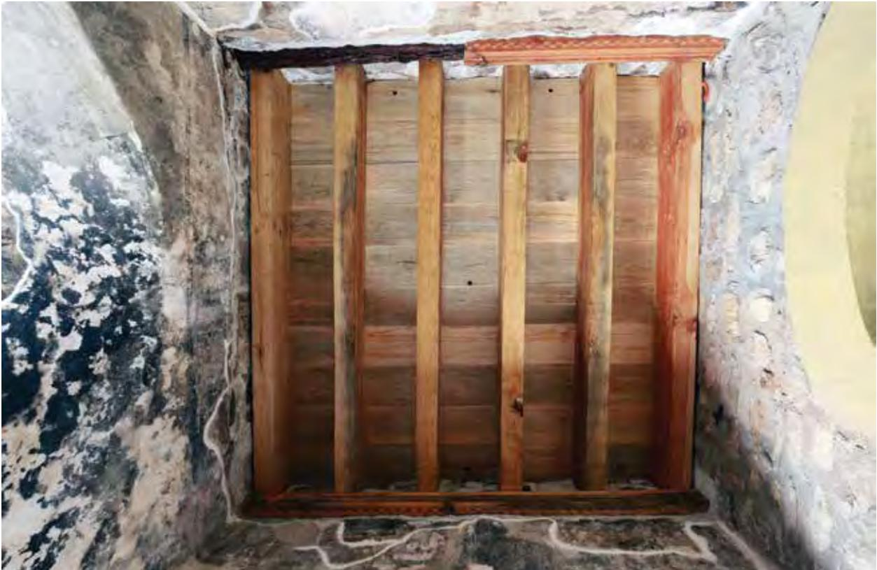
— Área de la cubierta donde se quedó expuesto el vestigio de la viga, en la parte posterior se encuentra la viga que cumple con la función estructural.
