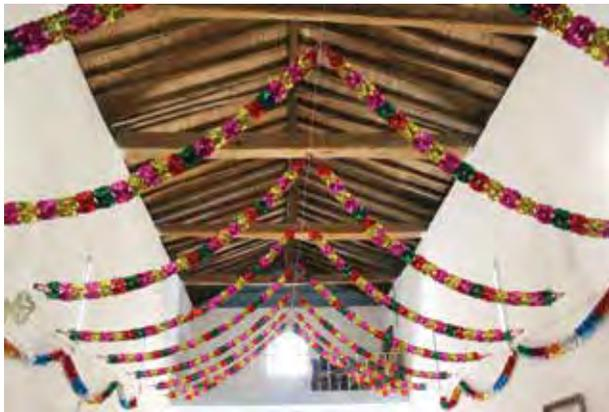
— Cubierta de madera de vigas tirante, pendolón, morillos y tejamanil.
