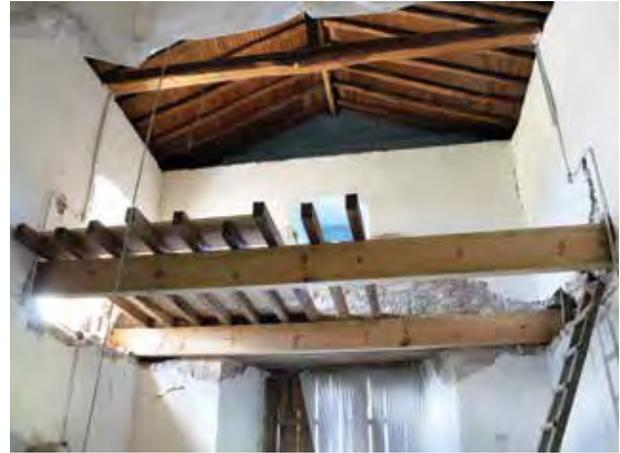
— Integración del coro con vigería de madera, material retomado con base en las características de la cubierta.
