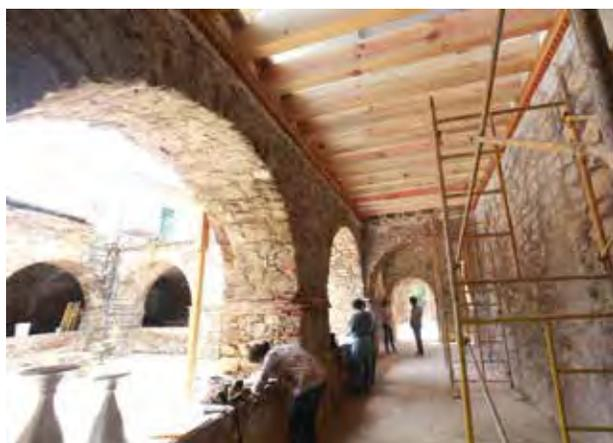
— Para la reconstrucción de la cubierta se utilizaron vigas y entablados de madera de pino.
