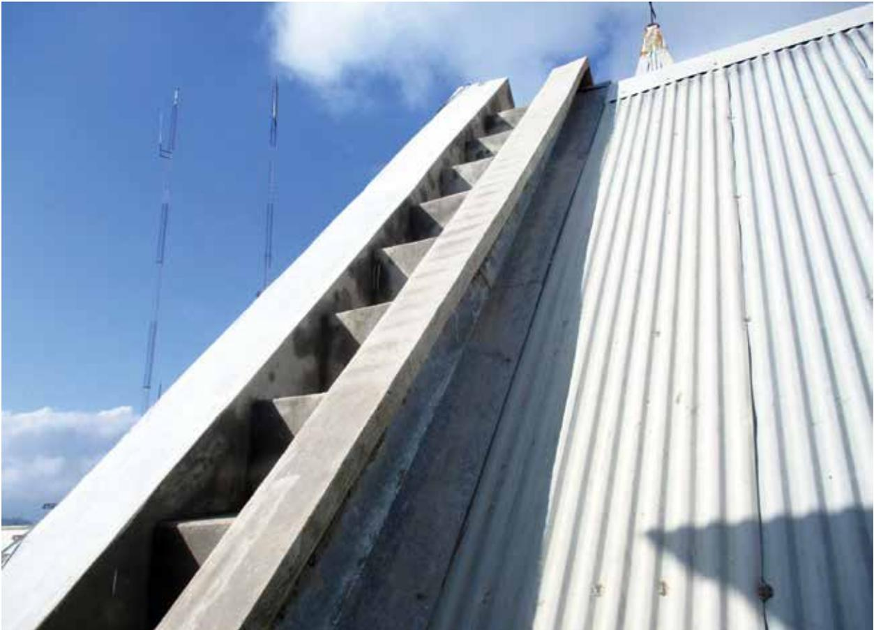
— Se colocó un gotero de lámina para evitar filtraciones de agua. Detalle del imafrente y gotero de lámina en el faldón.
