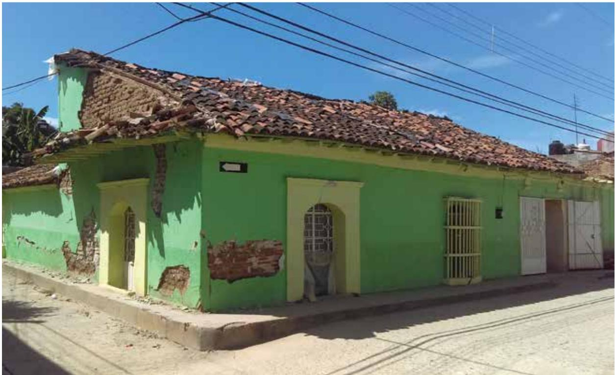
— A causa del sismo, los gruesos muros de adobe resultaron con grietas, además del desprendimiento de la cubierta de morillos y biliguana.
