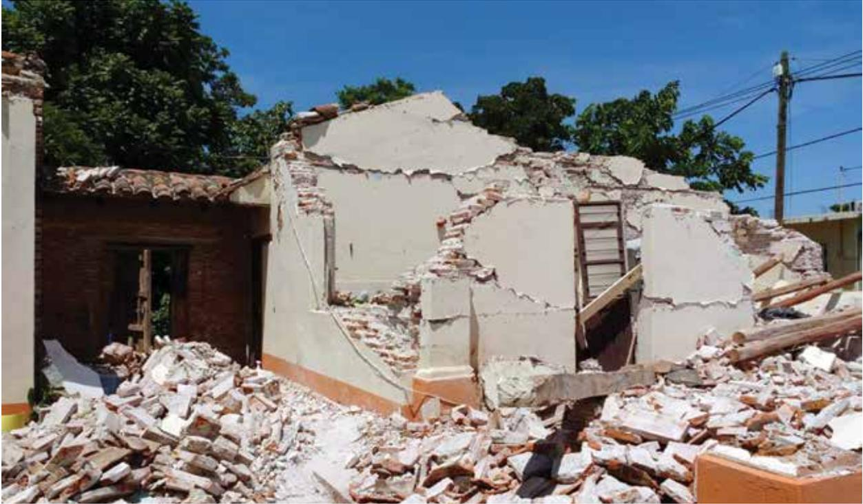
— Colapso de muros y cubierta.
