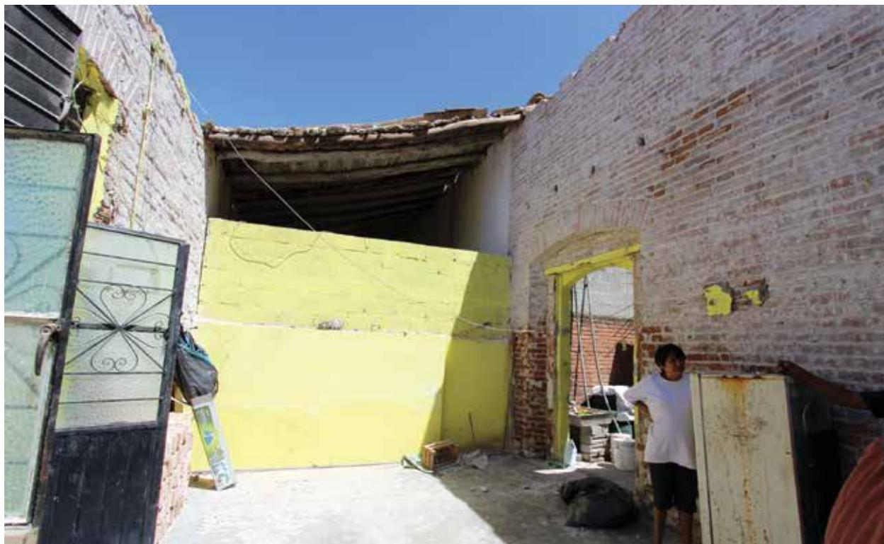
— Se desmontó la sección existente de la cubierta para valorar y tratar la madera y teja que sería recuperada.
