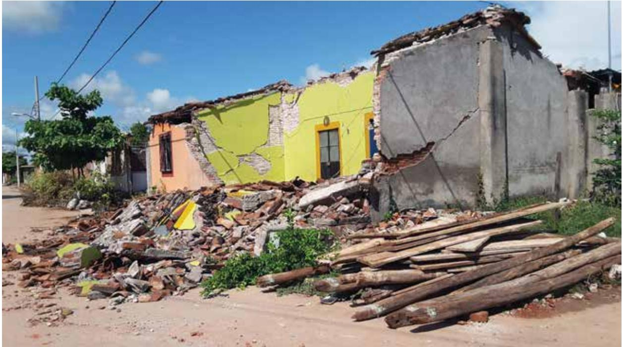
— La casa perdió la totalidad de su cubierta y fachada, los muros que quedaron en pie se hallaban fracturados y en peligro de colapso.
