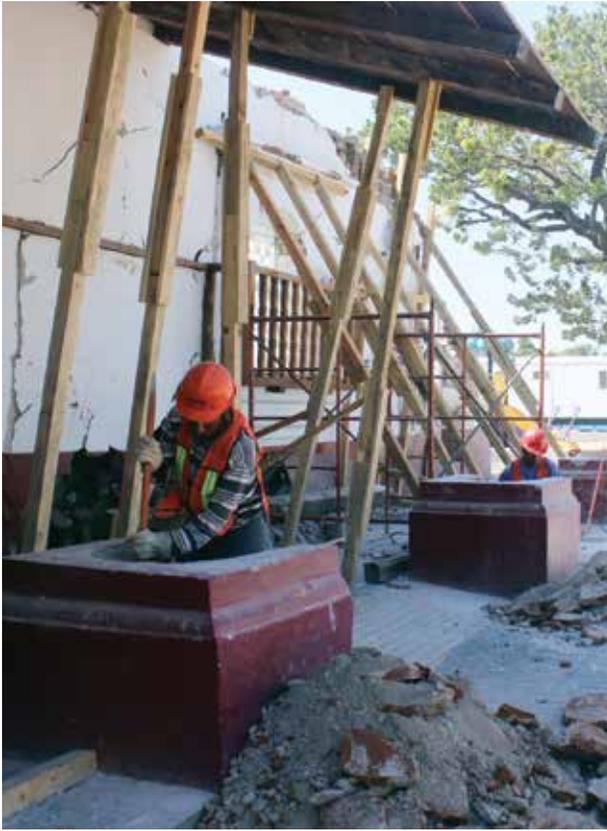
— Preparación de las bases para levantar las nuevas columnas.
