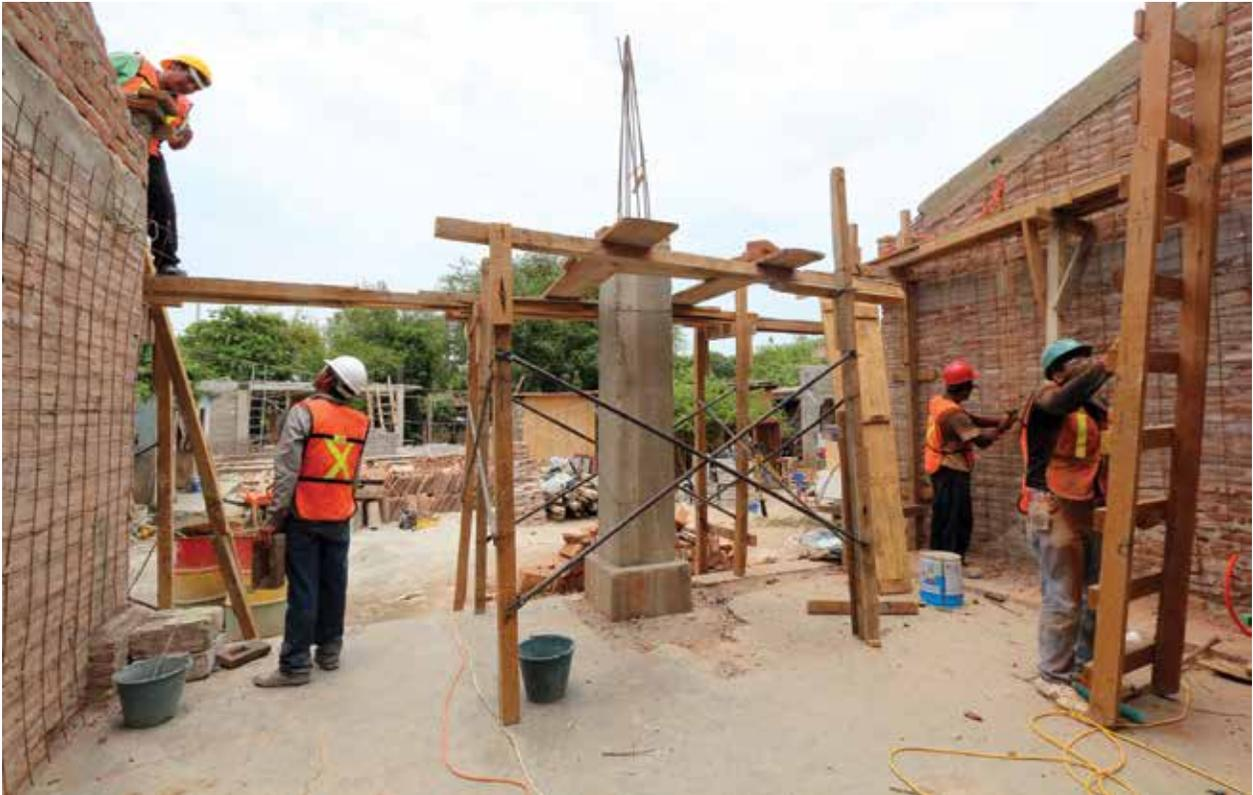
— Confinamiento de muros con malla de acero (corredor).
