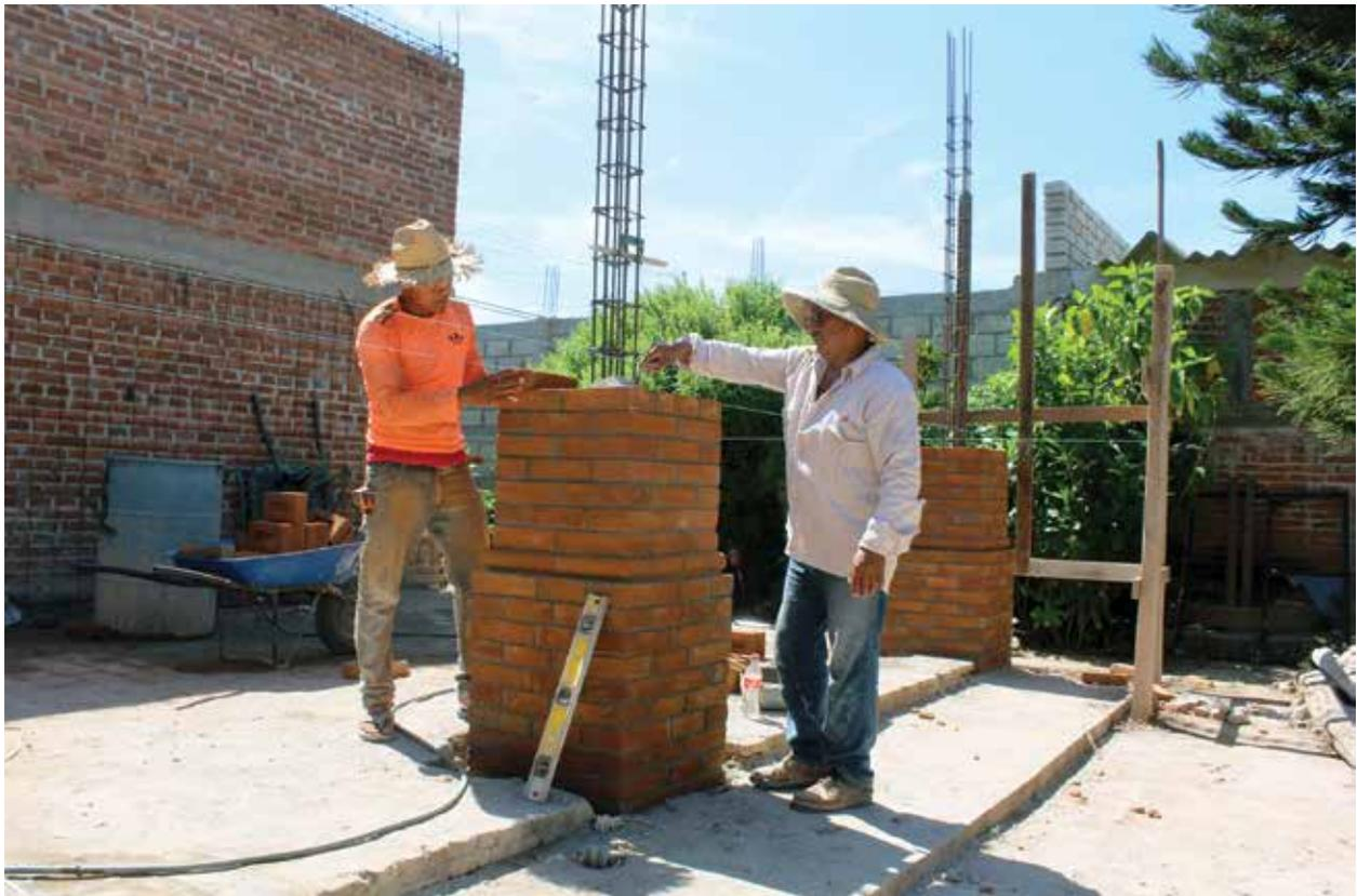
— Construcción y reforzamiento de columnas recuperando las características del corredor anterior.
