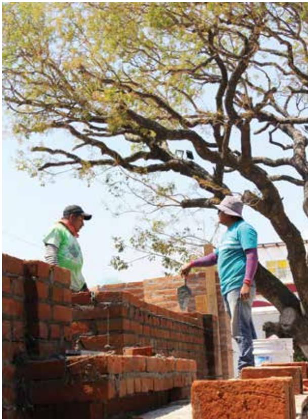
— Reconstrucción de muros confinados con malla en sentido horizontal.
