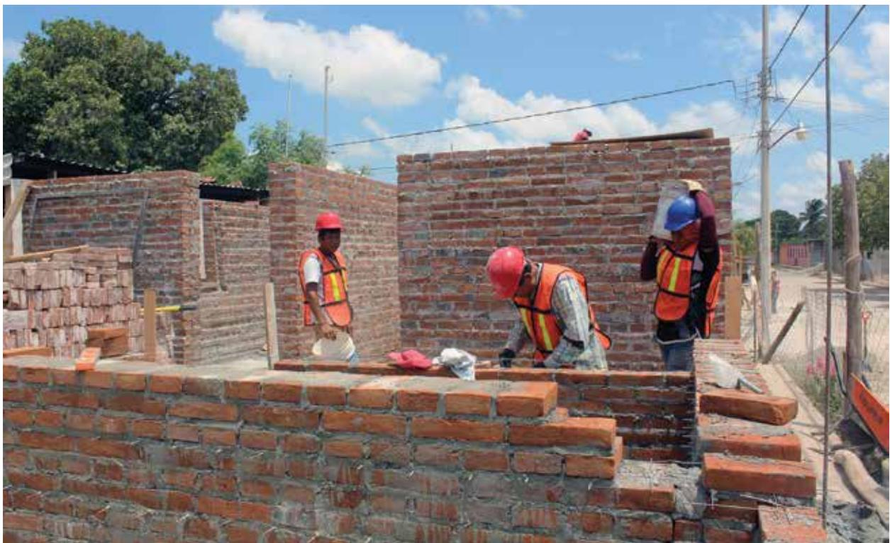
— En la construcción de los muros se usó el ladrillo de la localidad, el cual tiene un hueco en una de sus caras para lograr una mejor adherencia.
