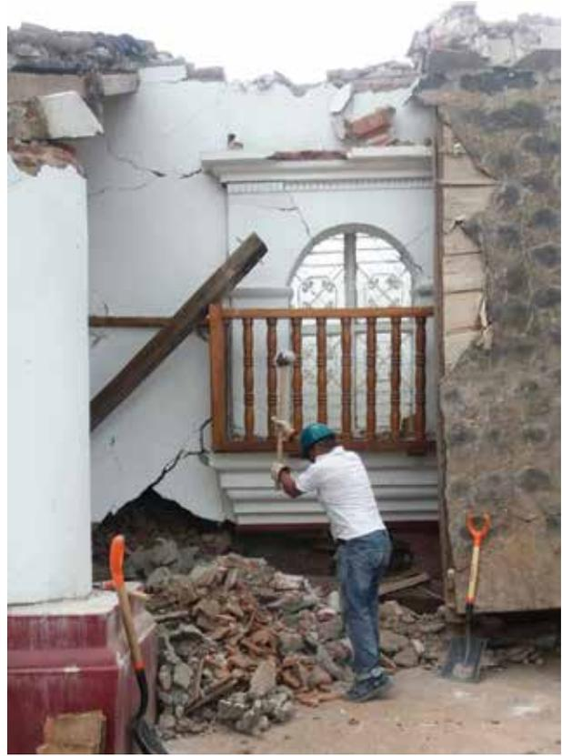
— Oquedad en la parte inferior del muro de adobe por asentamiento y desfase del balcón.
