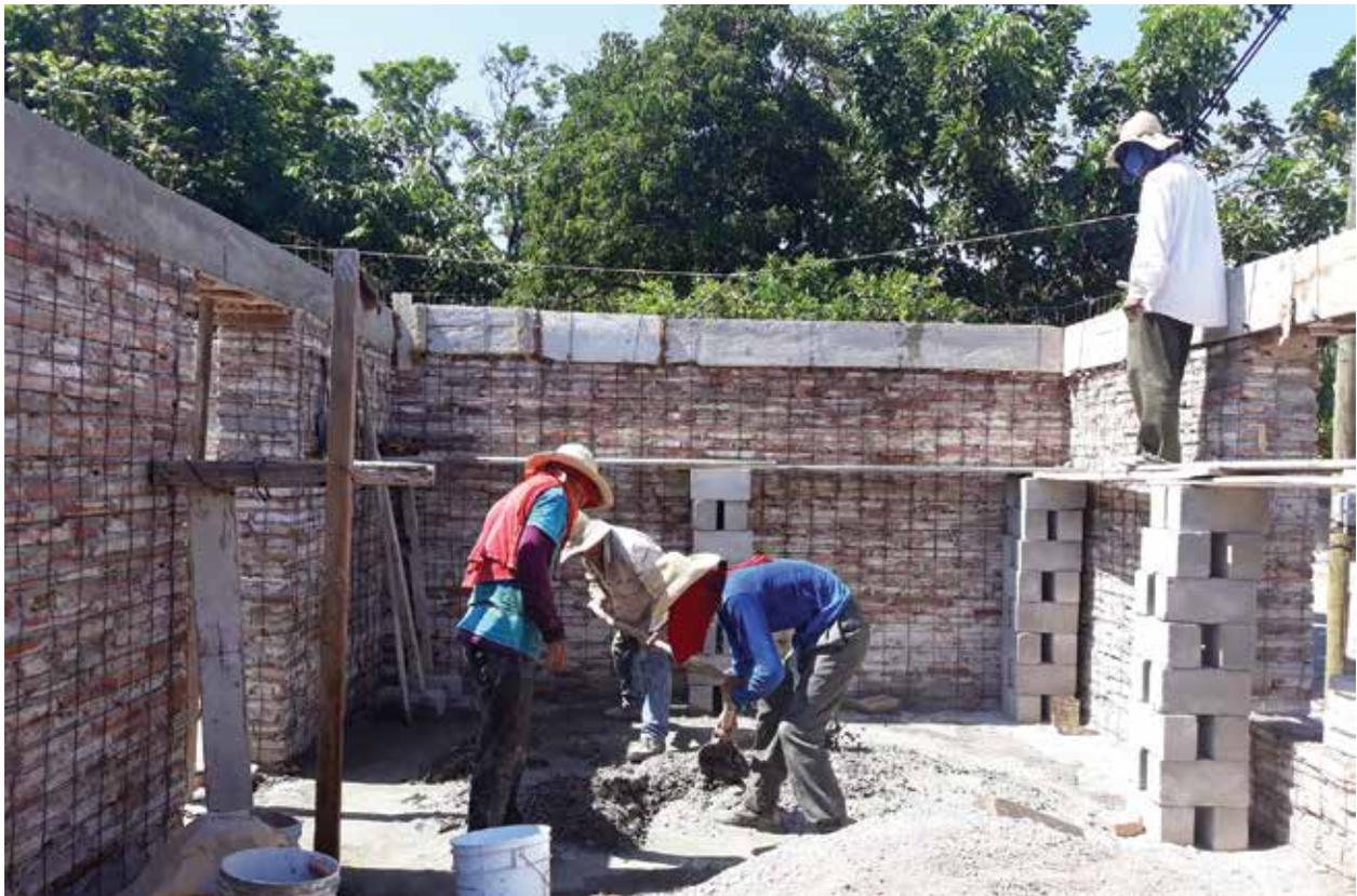
— Confinamiento de los muros de ladrillo mediante malla de acero.
