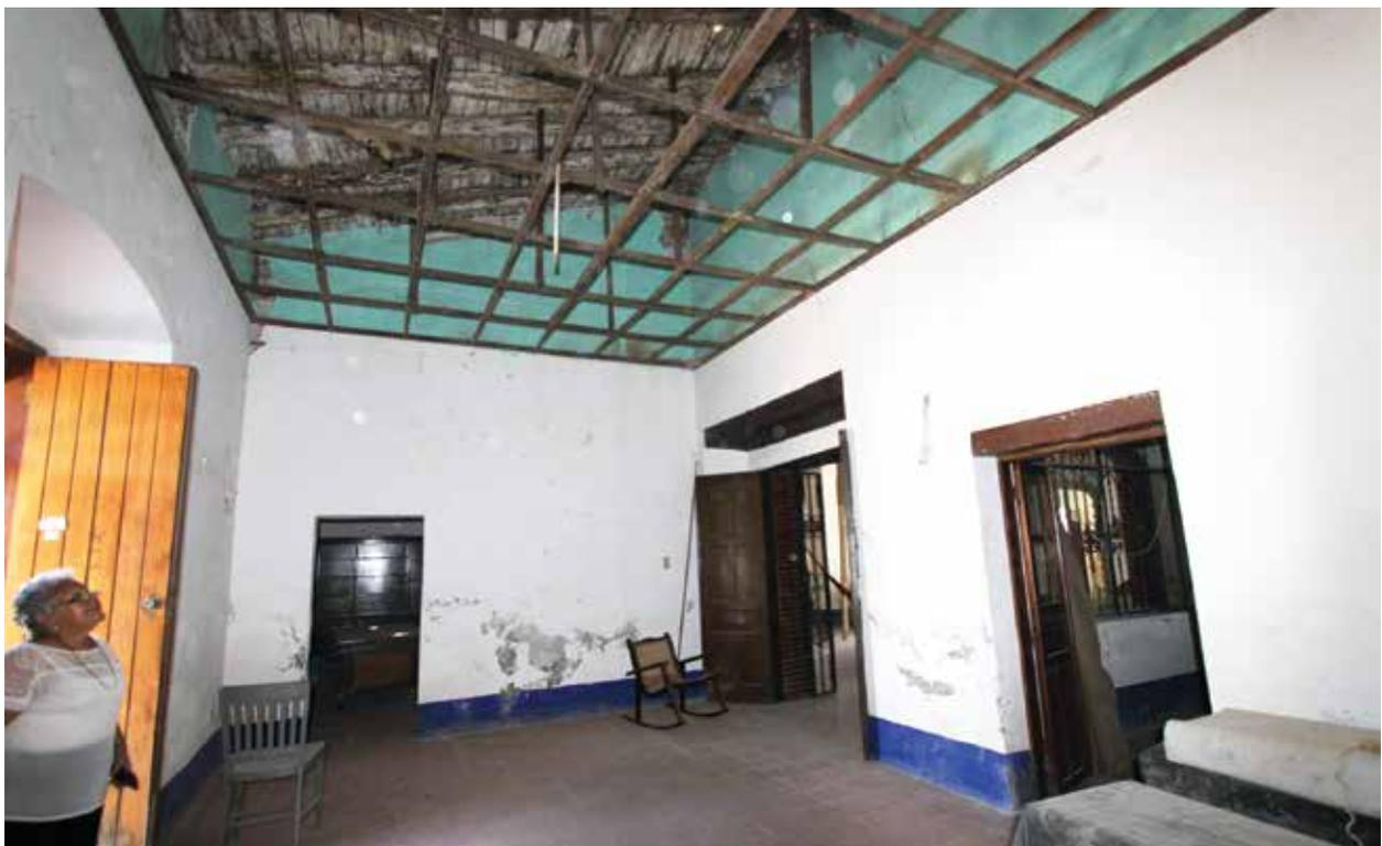
— Con el colapso del falso plafón, se observó el desplazamiento de los materiales locales de la cubierta, grietas y desprendimiento de aplanados en los muros.
