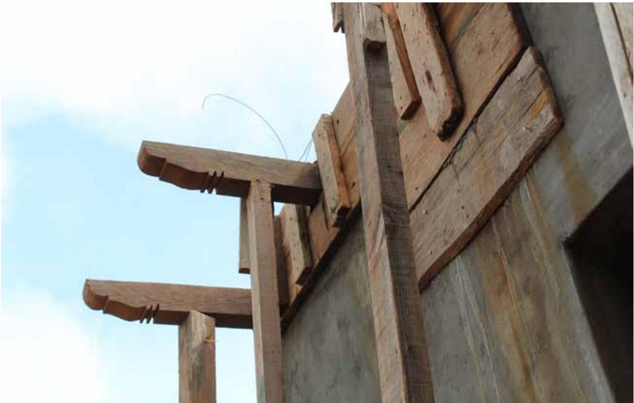
— Detalle de colocación de canchillo; un elemento importante en la arquitectura local.
