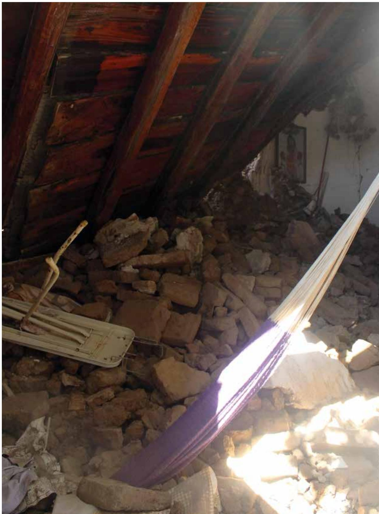
— La cubierta de morillos con entablado y sus gruesos muros de adobe de una de las habitaciones, colapsó.
