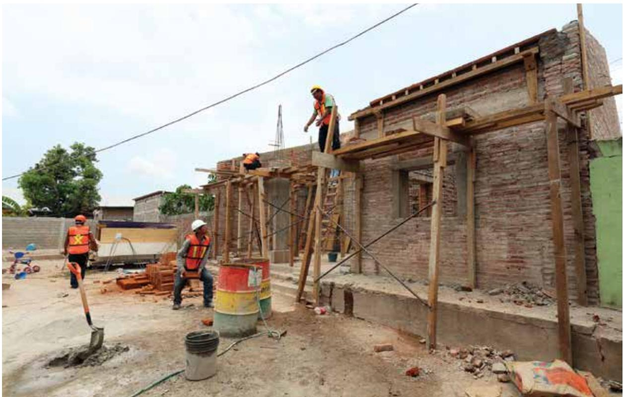
— Reconstrucción de muros del corredor y cocina con ladrillo local de barro.
