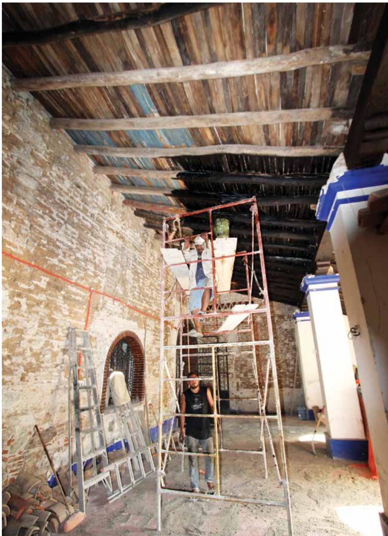
— Liberación del aplanado para exploración y consolidación de los muros. El aplanado integrado fue a base de cal para mejorar la adherencia con el muro de adobe.
