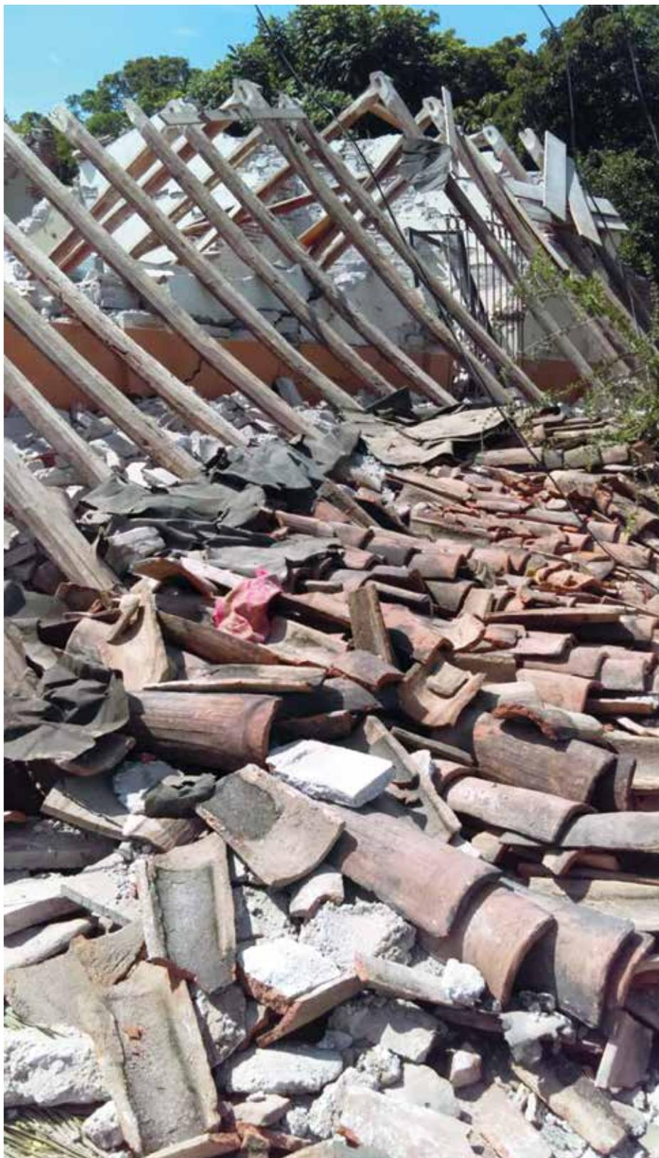
— La armadura de morillos colapsó en un sólo bloque.
