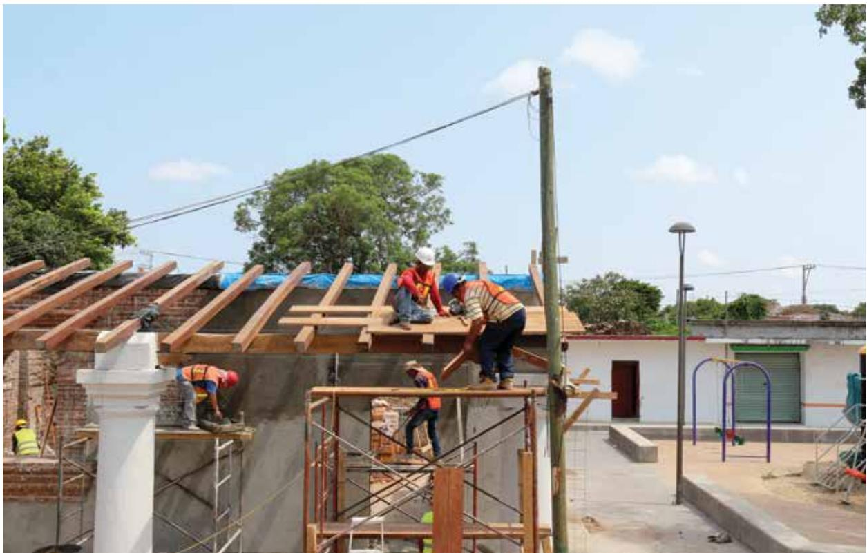
— Colocación del entablado sobre viguería y travesaños. Todo el material de la cubierta fue recuperado.
