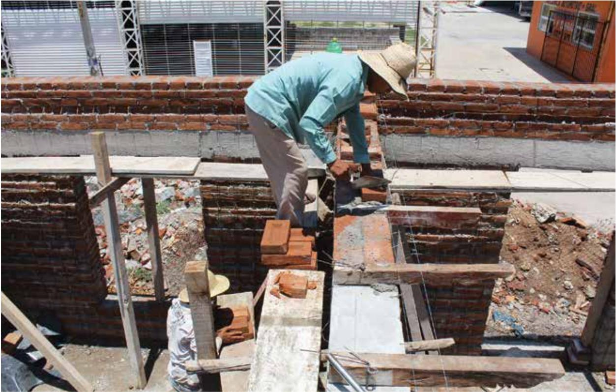
— Reconstrucción de los muros con ladrillo de barro rojo de la región.
