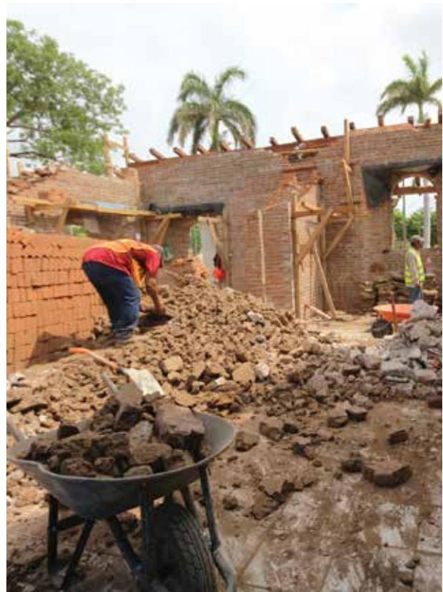
— Recuperación de material de adobe. Al fondo, avances en la reconstrucción de los muros de la fachada.
