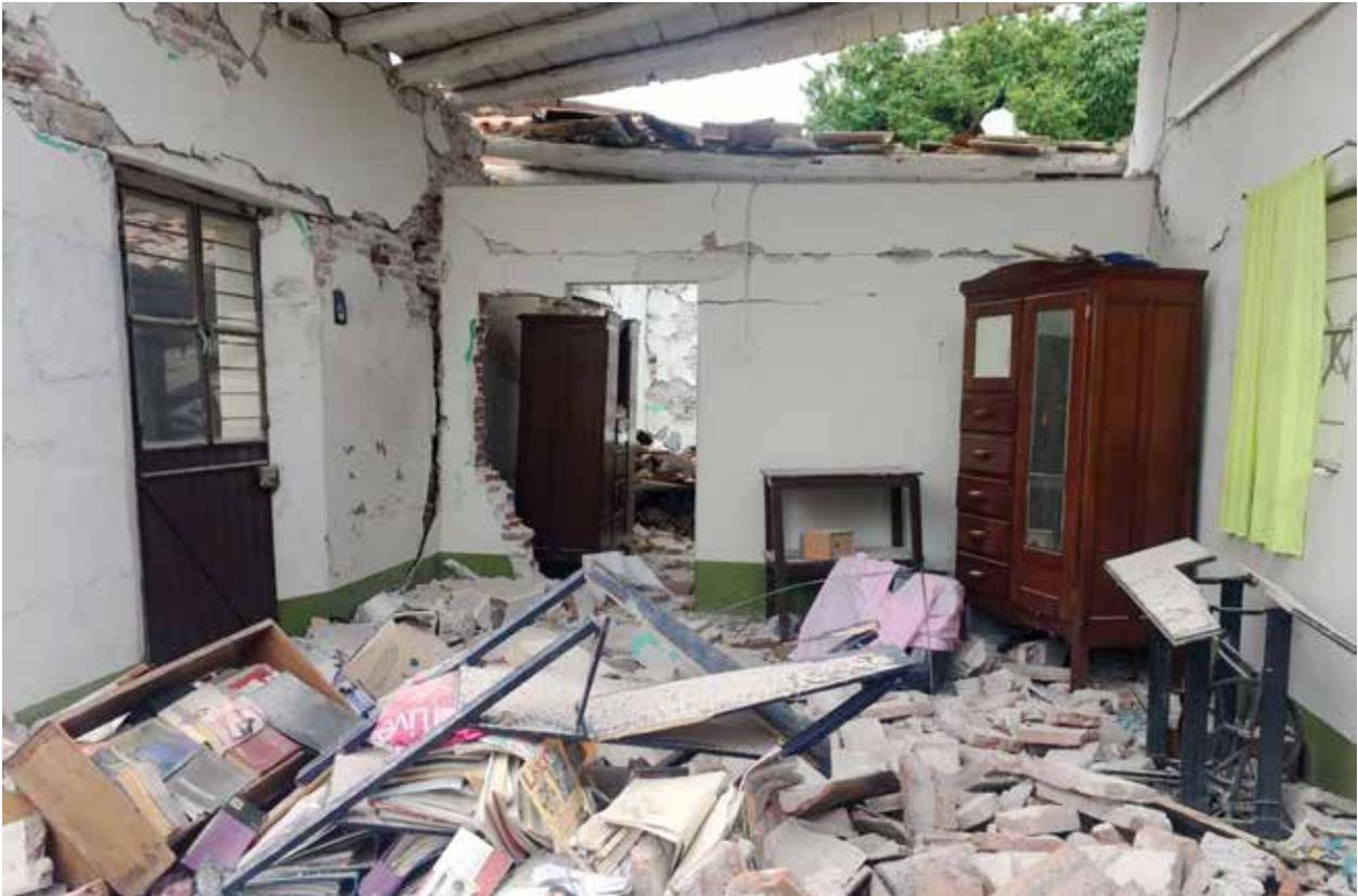
— En el interior de la habitación se observa que las esquinas se separaron, inclinándose al exterior provocando que la cubierta colapsara en un solo bloque.
