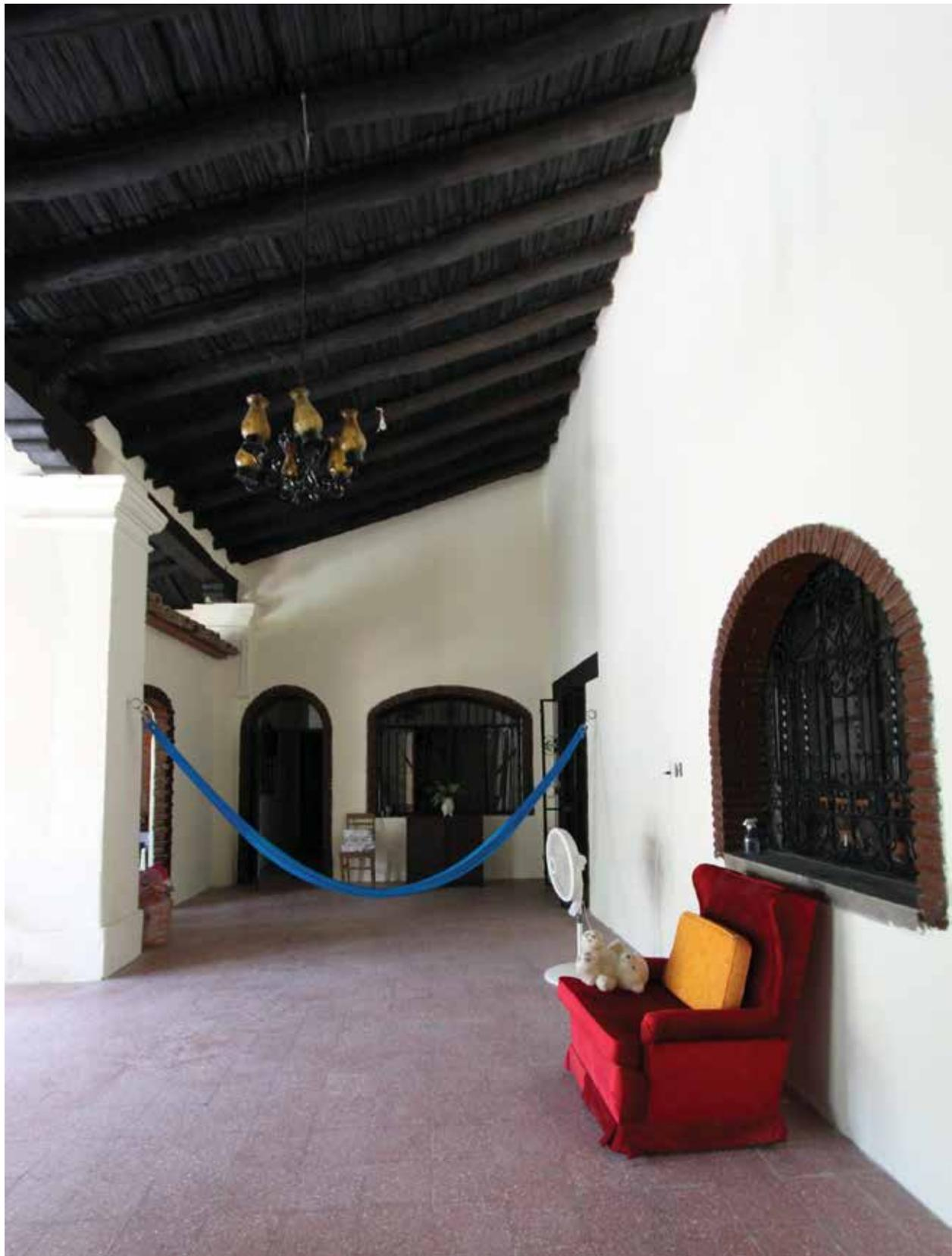
— Corredor de la casa. La integración de aplanados a base de cal y arcilla que se realizó sobre los muros de adobe originales, mejorará las condiciones de liberación y absorción de humedad de los materiales.
