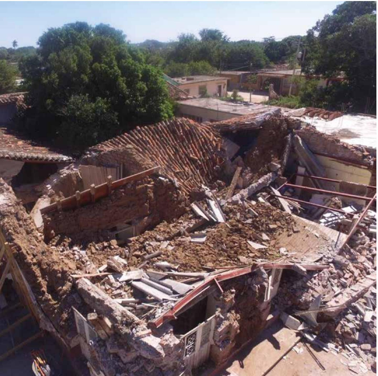
— En la imagen se observan los diferentes materiales de los elementos de carga de las cubiertas.
