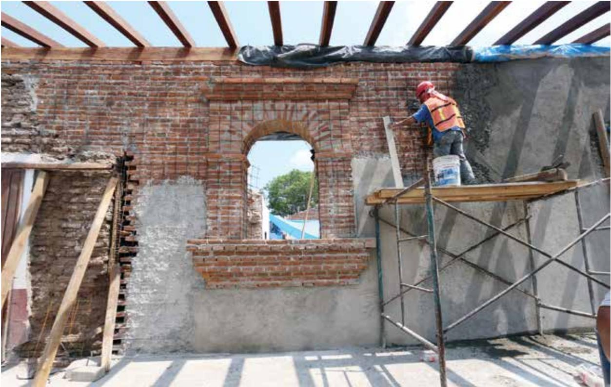
— Vano reconstruido con ladrillo rojo y unión del muro mediante el entretejo con los sillares de adobe.
