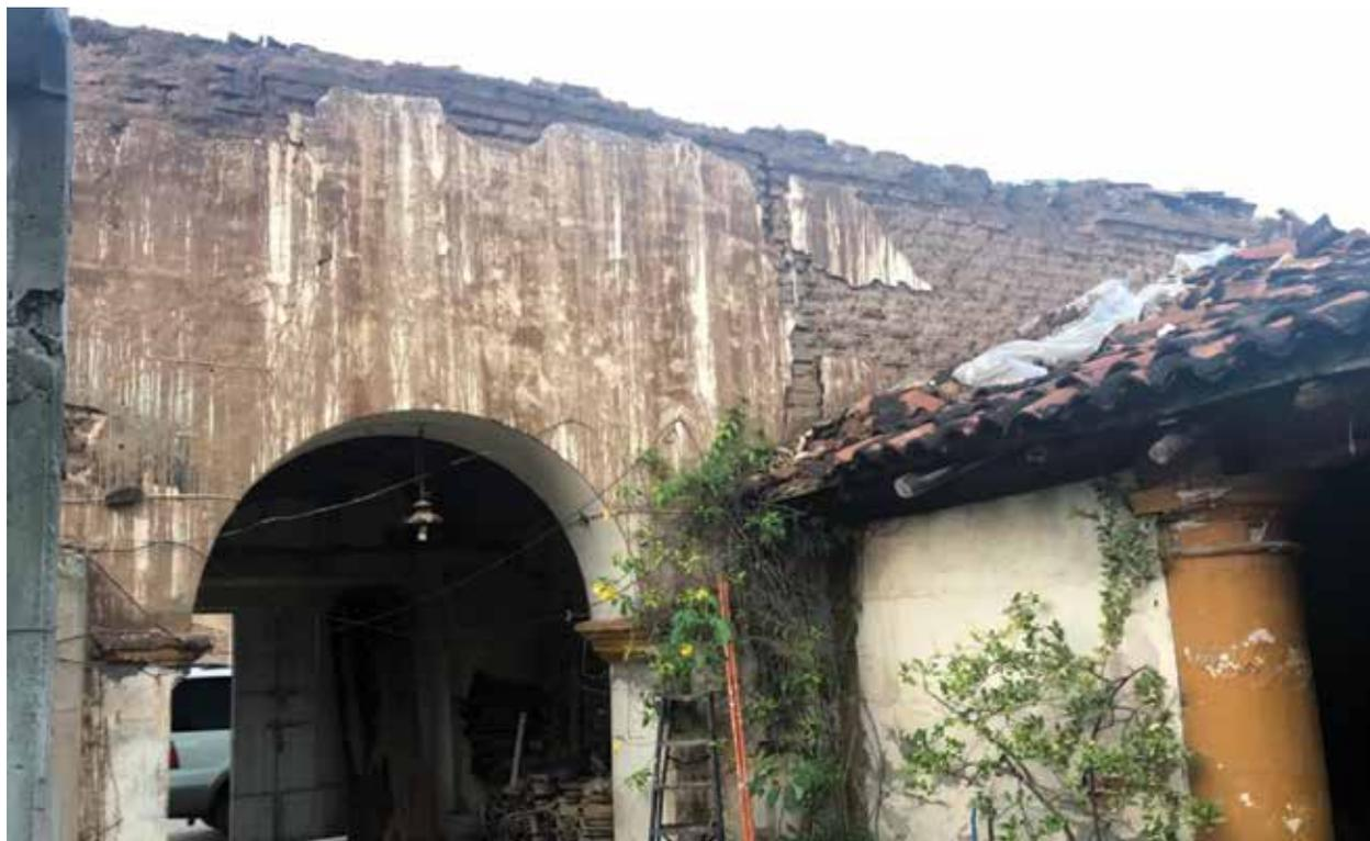
— Deslave de muros de adobe y desprendimiento de aplanados por lluvias y faltante parcial de cubierta.
