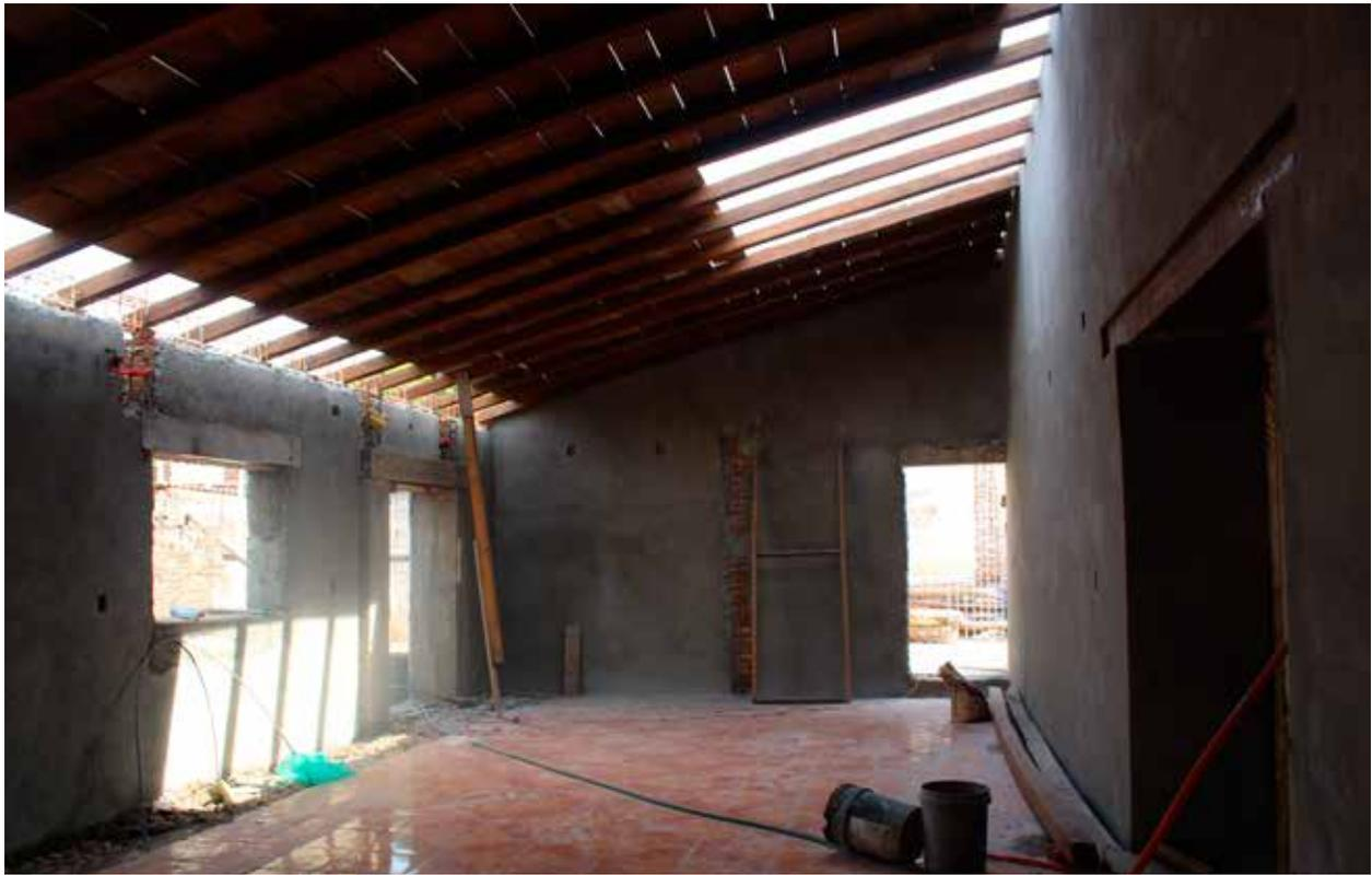
— Avances en la colocación de la cubierta a base de vigas, entablado y teja.
