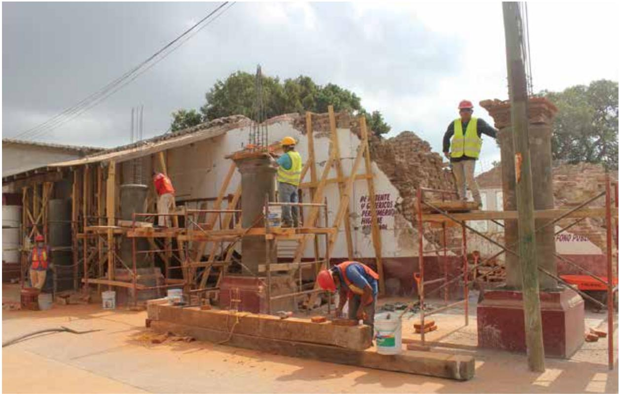
— Reconstrucción de las columnas con reforzamiento de acero.
