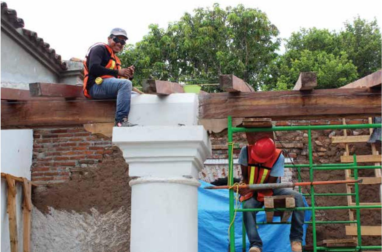
— Recuperación del capitel de la columna, de las vigas zapata y travesaños de la cubierta. Al fondo, muro de adobe consolidado.
