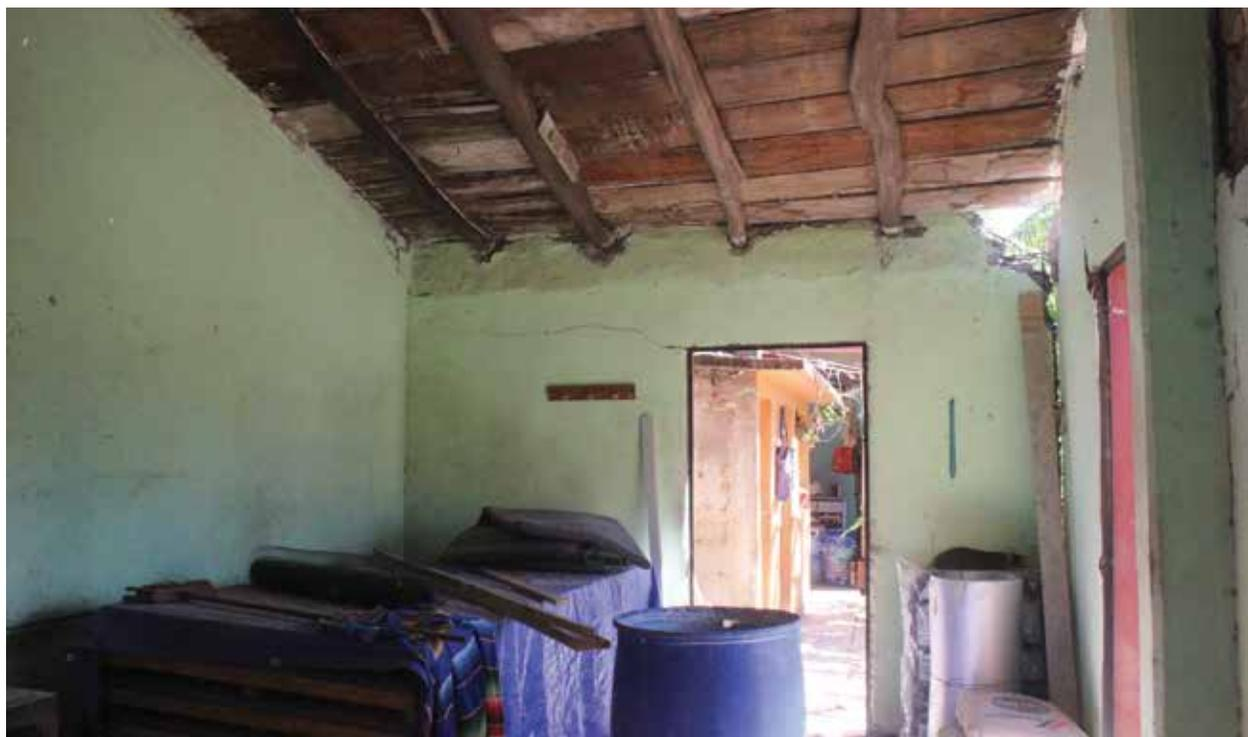
— La cubierta de la casa era de morillos con entablado y teja, en sus muros mostraba elementos verticales de carga de concreto reforzado.
