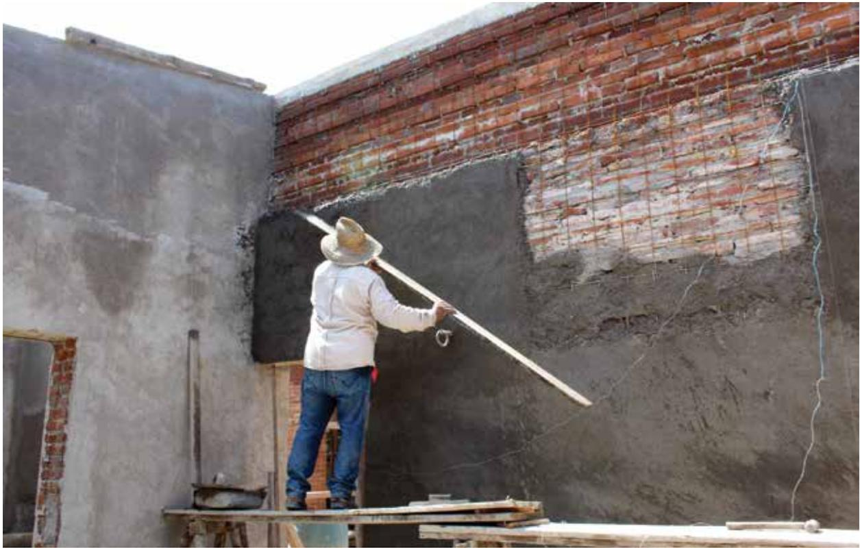
— Como parte del reforzamiento estructural, se colocó una malla electrosoldada y posteriormente los aplanados.
