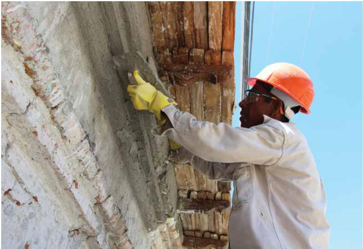
— Recuperación de elementos formales de la fachada; alero de canchillos de madera, biliguana y moldura en que descansan.
