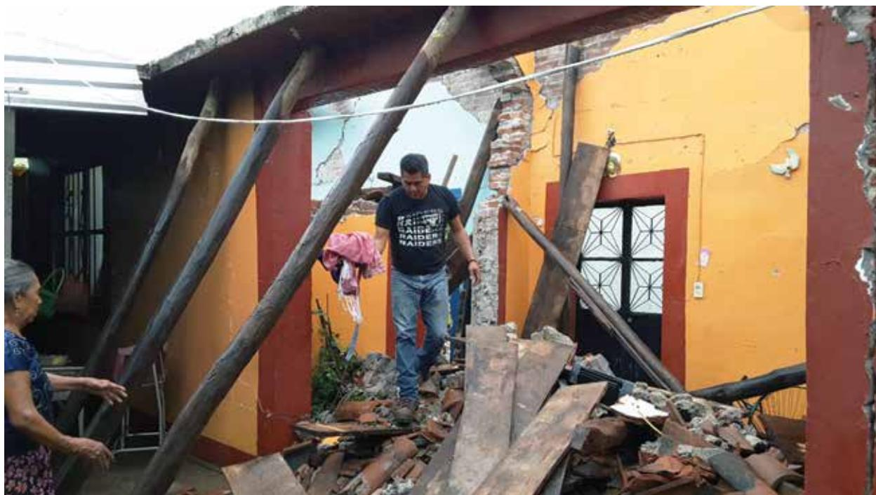
— El agregado de elementos de concreto reforzado es uno de los factores que afectan a las casas tradicionales, esto debido al comportamiento de sus materiales.
