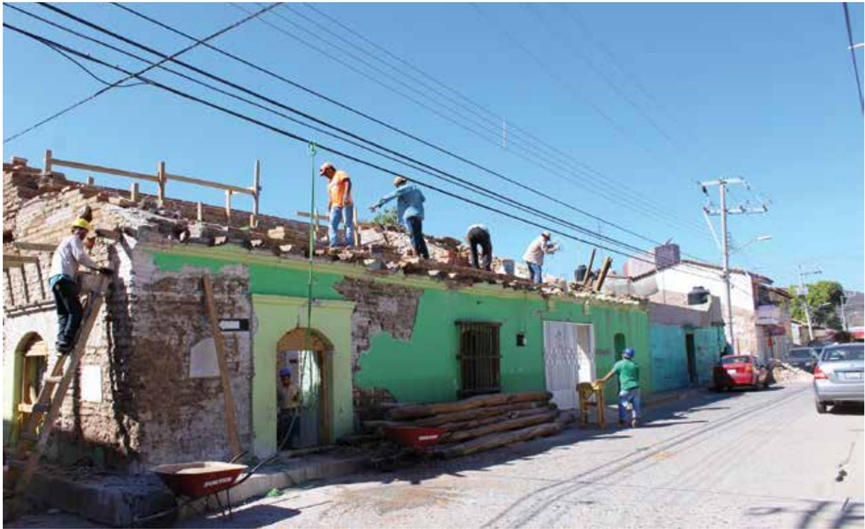
— Morillos, tejas y biliguanas fueron recuperados para armar nuevamente la cubierta.
