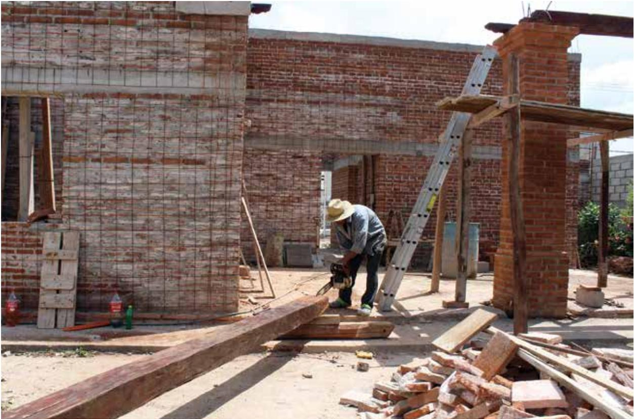
— Corte del perfil del ensamble en una de las vigas de la cubierta.
