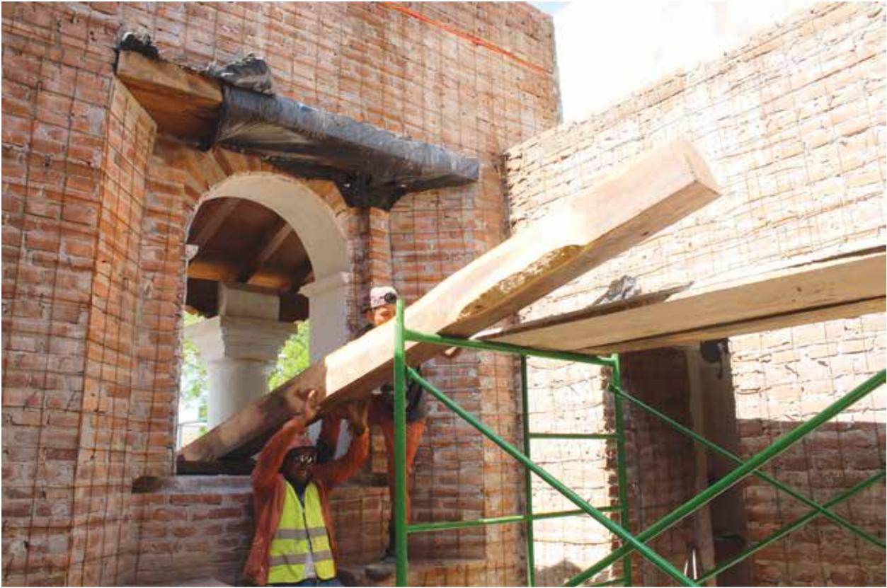
— Debido al tamaño de las vigas, se optó por introducirlas a través de uno de los balcones para el armado de la cubierta del interior.
