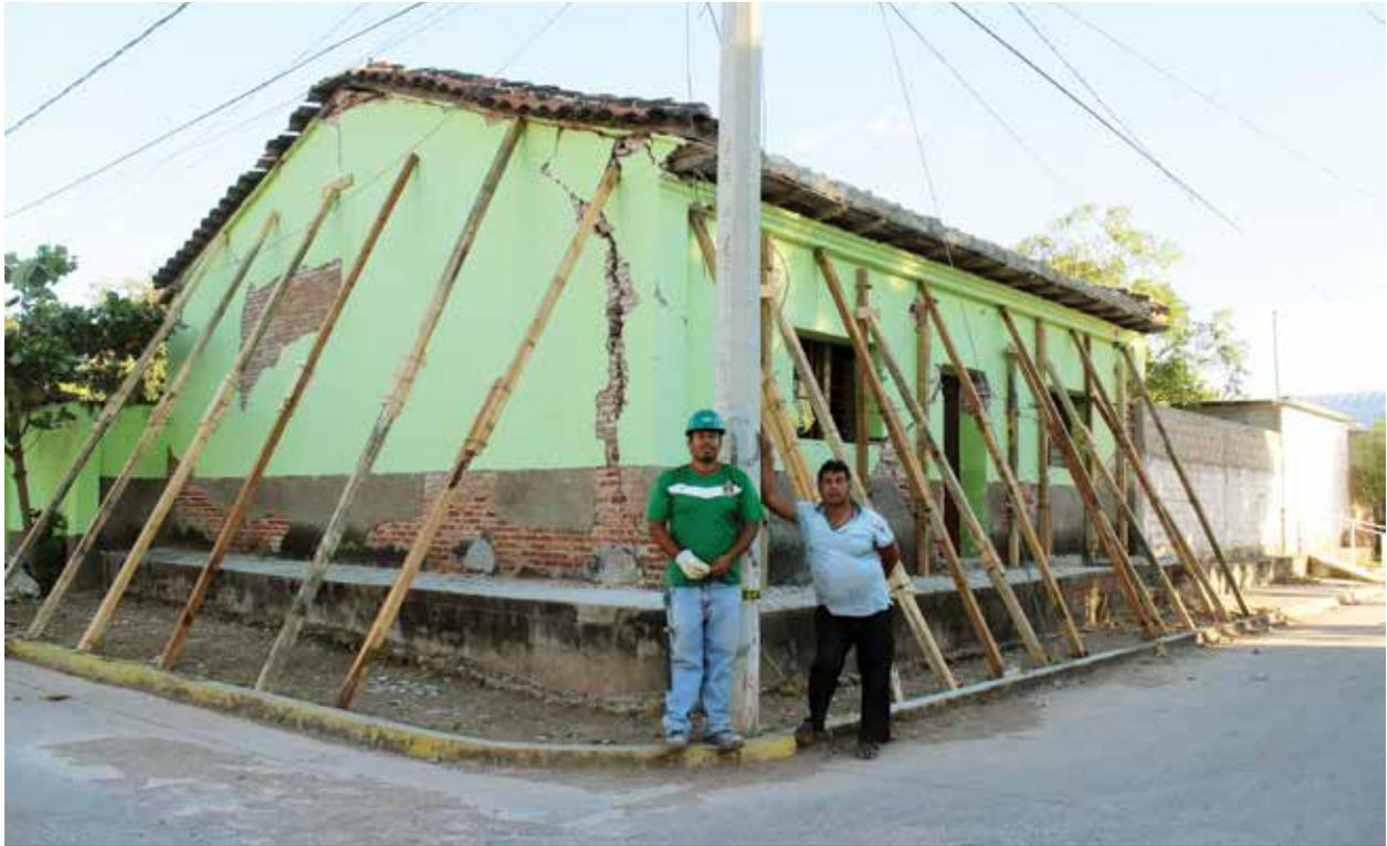
— Debido al desplome y grietas en los muros, se realizó un apuntalamiento para liberar la cubierta.
