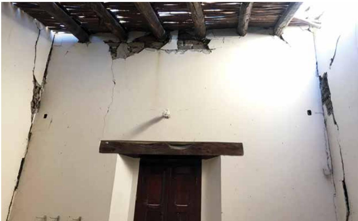
— La antigua casa mostraba grietas en las esquinas de los muros de adobe y en el área de carga de los morillos, debido al desplazamiento de la cubierta.
