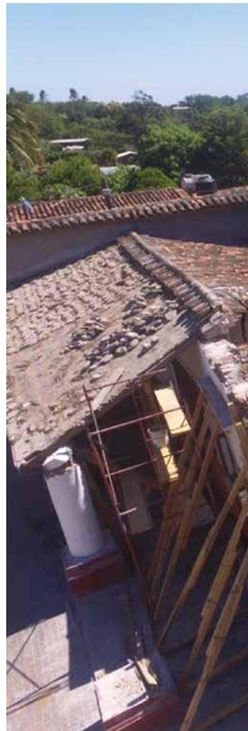
— La combinación de elementos de carga como montenes, cadenas de concreto y perfiles de metal con la cubierta de materiales locales, propiciaron el derrumbe de la cubierta y muros.
