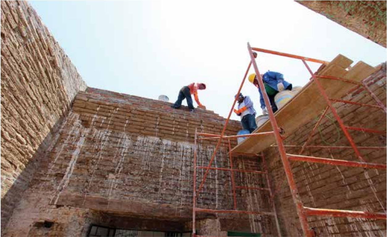
— La parte superior de los muros fue reforzada con ladrillo de barro de la localidad, el cual tiene un hueco en una de sus caras para mejorar la adherencia.
