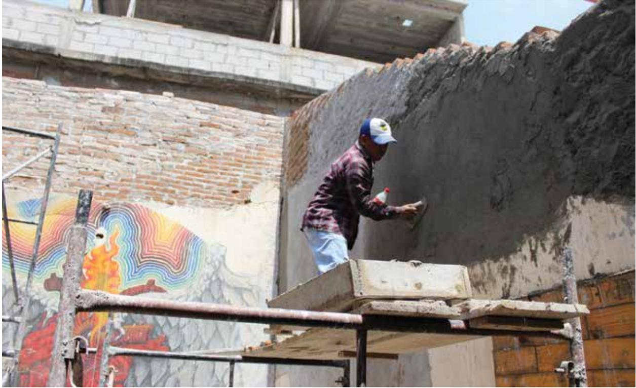
— Los muros reconstruidos a base de ladrillo de barro rojo, fueron enrazados y aplanados a base de cal.
