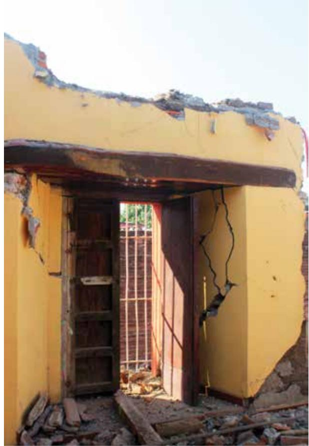
— El balcón de la casa mostraba una protección saliente de herrería, puertas y dintel de madera, donde sus muros de adobe resultaron fracturados.
