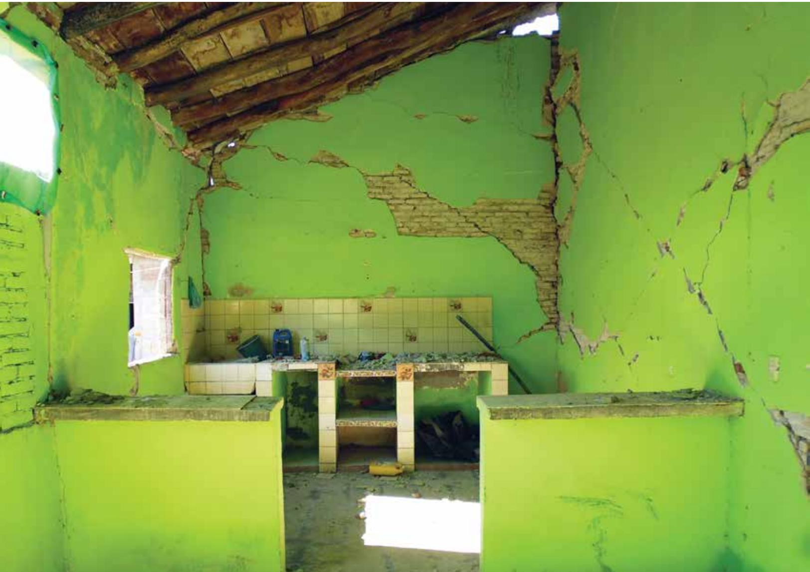
— Las grietas e inclinación en las esquinas de la cocina provocaron la separación del muro central y la cubierta se encontraba sobrepuesta y vulnerable a caer.
