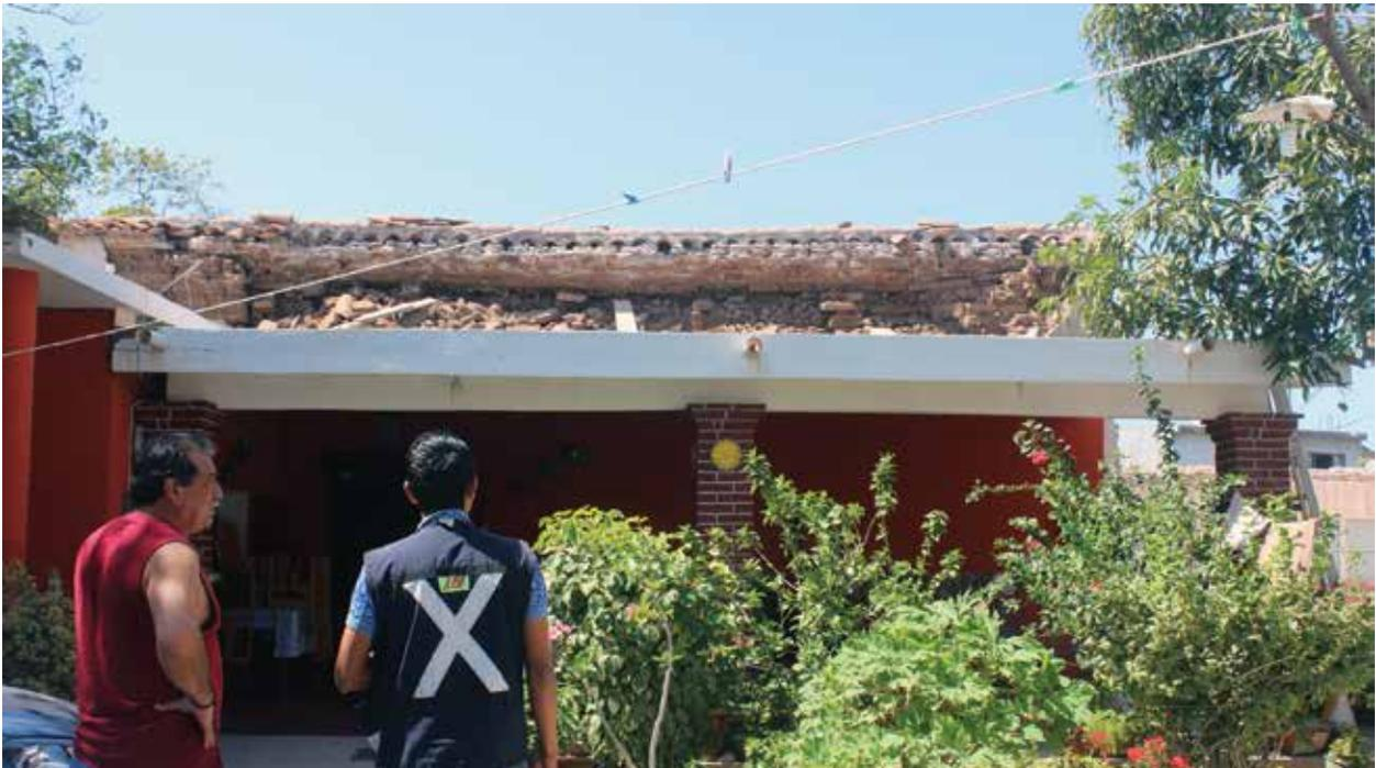
— Colapso de la cubierta. En parte posterior se observa el tejado de la cubierta tradicional sobre una losa de concreto reforzado del corredor.
