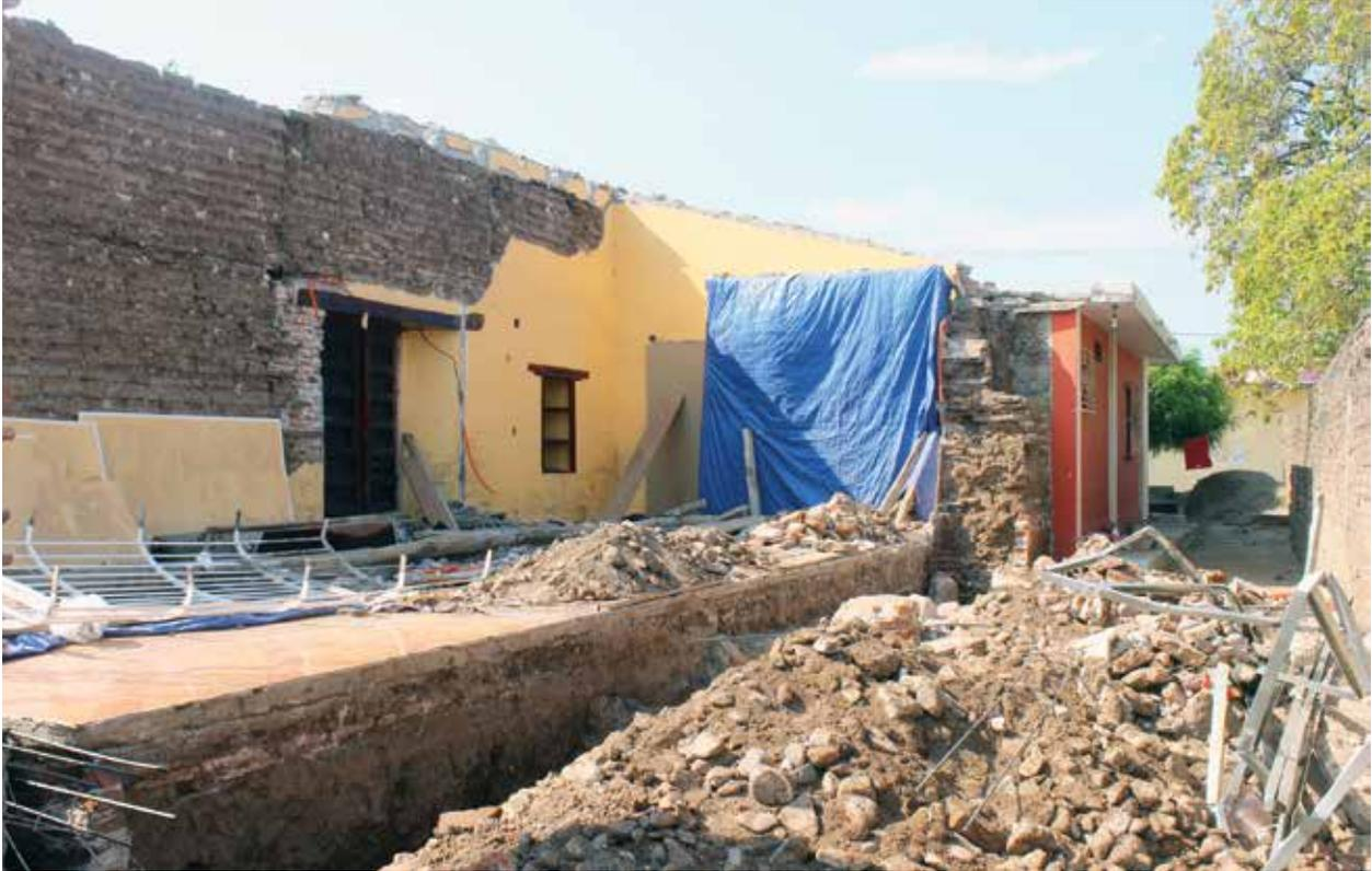
— Al bajar la cubierta de morillos y entablado se observó que sobre los muros descansaba una cadena de concreto.
