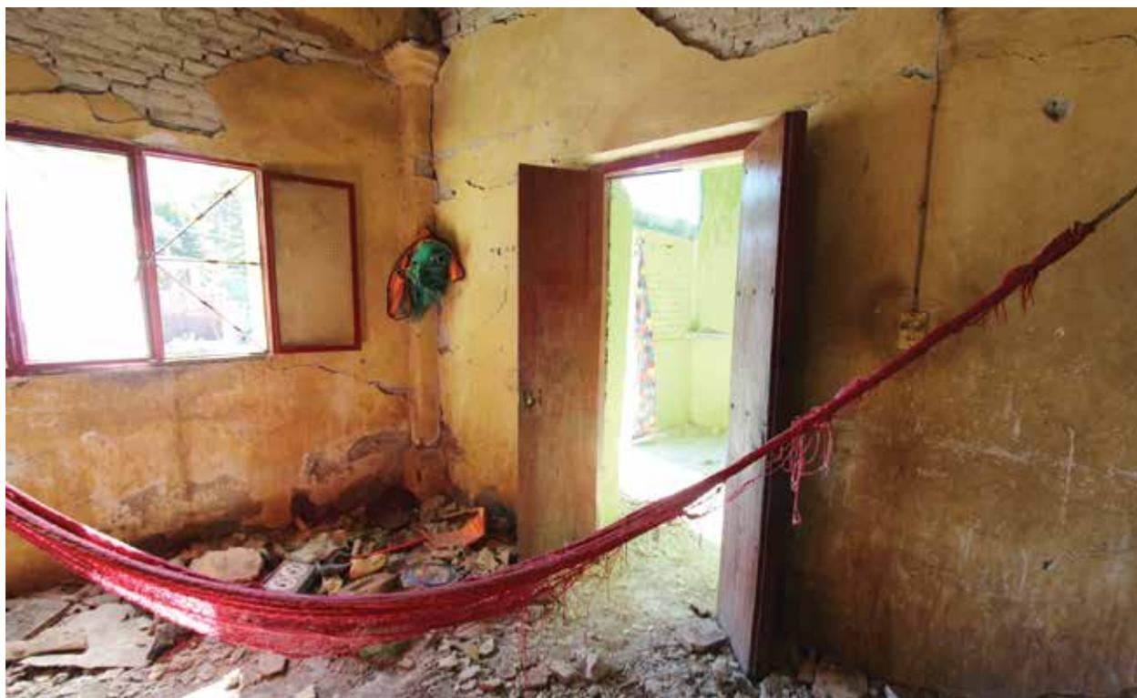
— Desprendimiento de aplanados en zona de grietas longitudinales del muro y esquina de los vanos.
