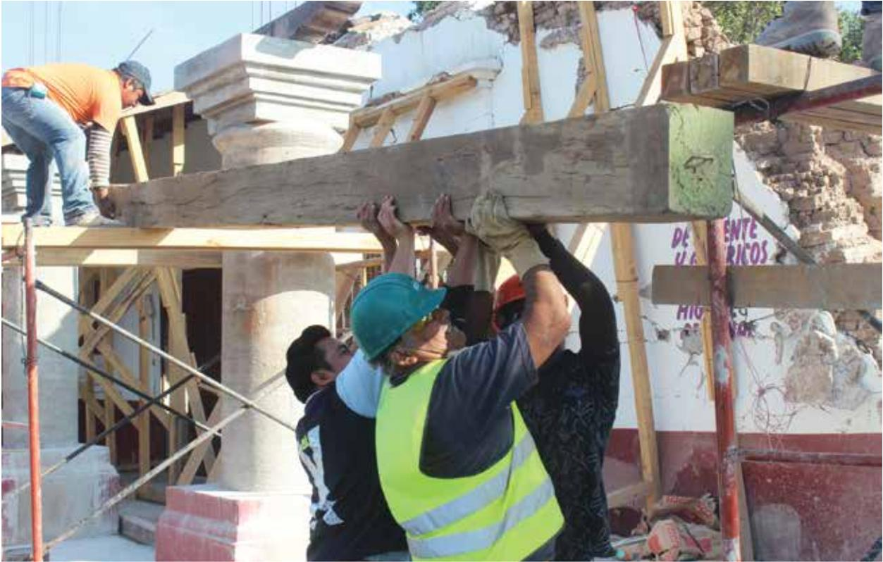
— Desmontaje de travesaño para su tratamiento, limpieza y reintegración.
