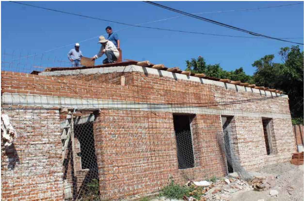
— En la cubierta de la casa se continúa avanzando en la colocación del entablado.
