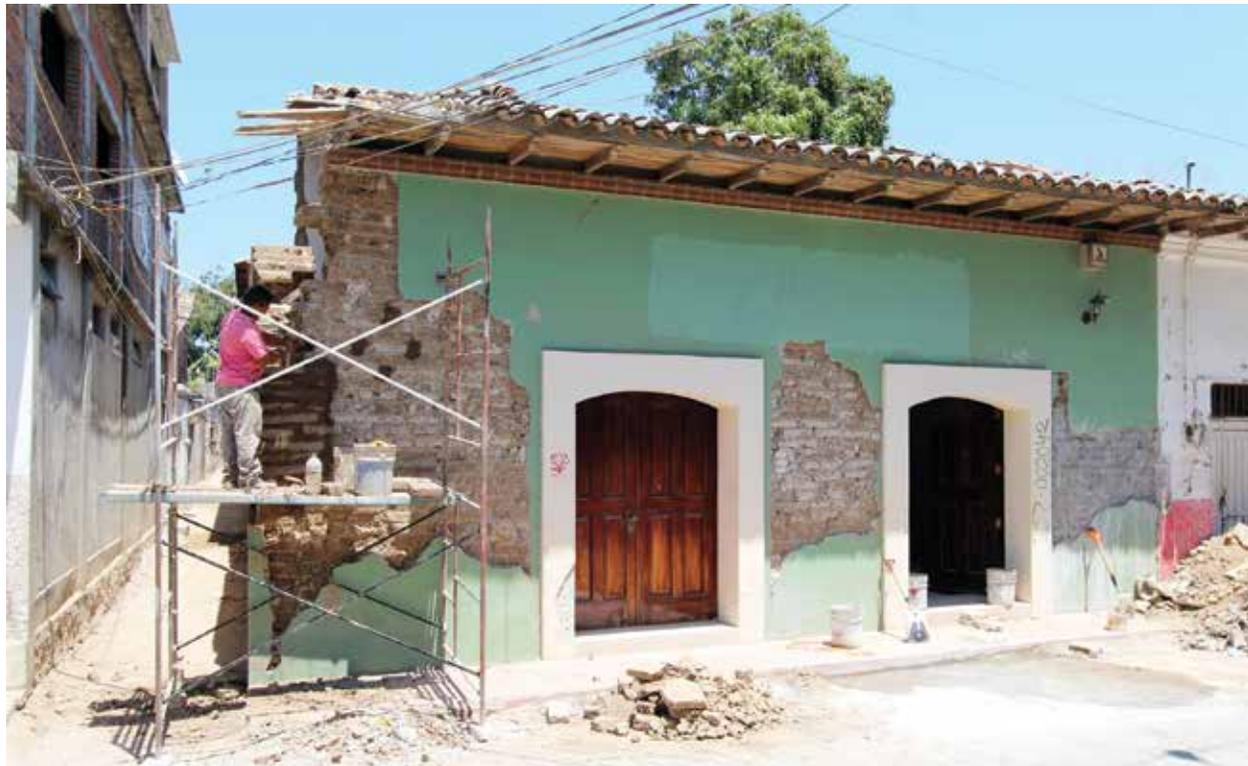
— Reforzamiento de esquina de muros mediante el muelo de piezas de adobe.
