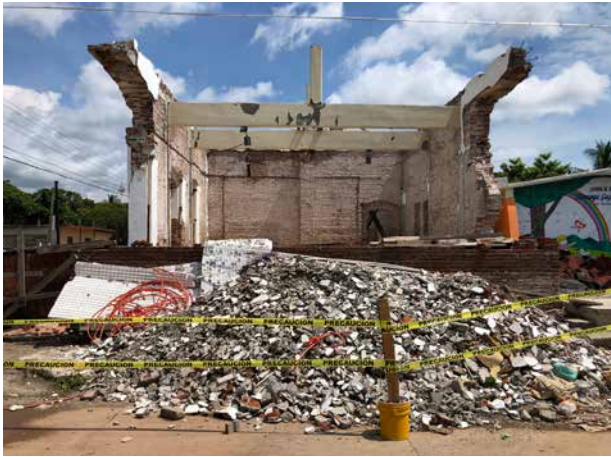
Debido a los daños, gran parte de los muros fue liberada para su posterior reconstrucción.
