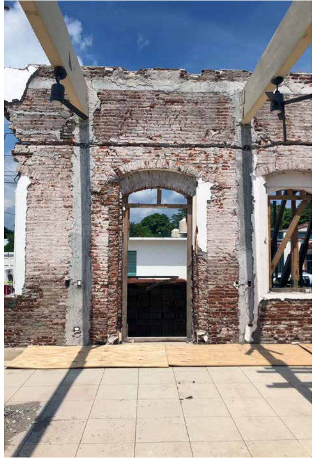
Exploración de grietas, agregados y daños en muros y cerramiento de vanos.
