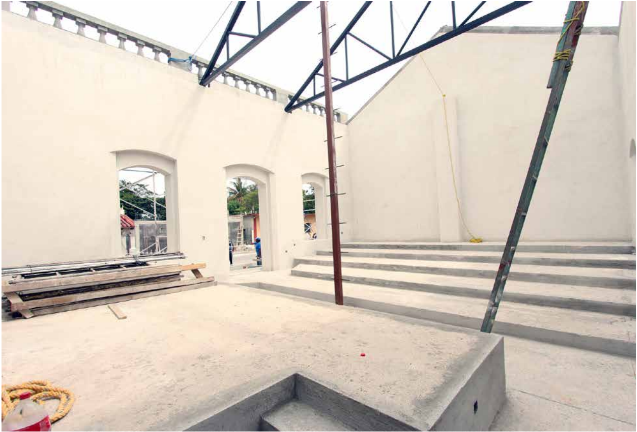
Colocación de armadura en el auditorio del edificio.
