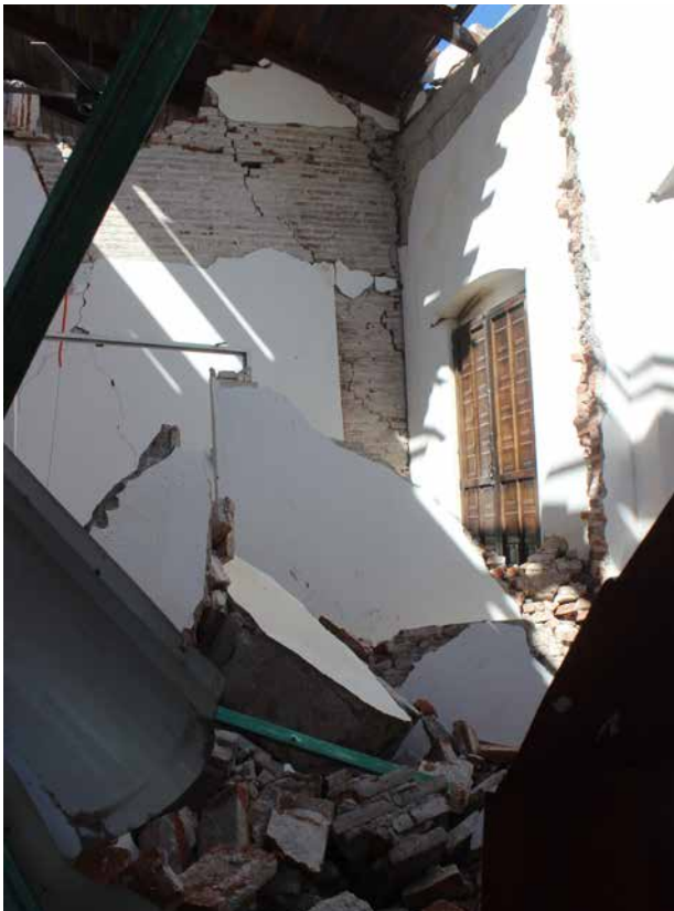
Cubierta y remate colapsados al interior del edificio.
