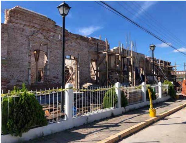
De la parte superior de la fachada, se retiró un pretil agregado.
