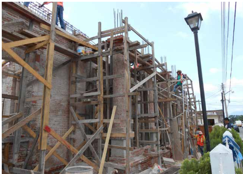
Cadena de cerramiento en muros perimetrales donde se apoya la cubierta de armaduras.
