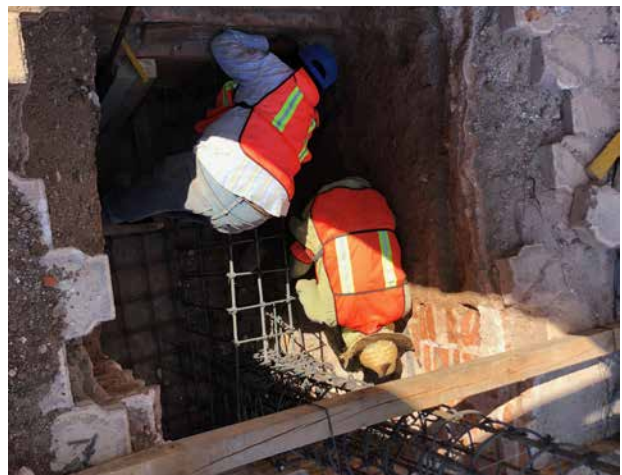
Armado de cimentación y estructura de la columnata del pórtico de acceso al edificio.
