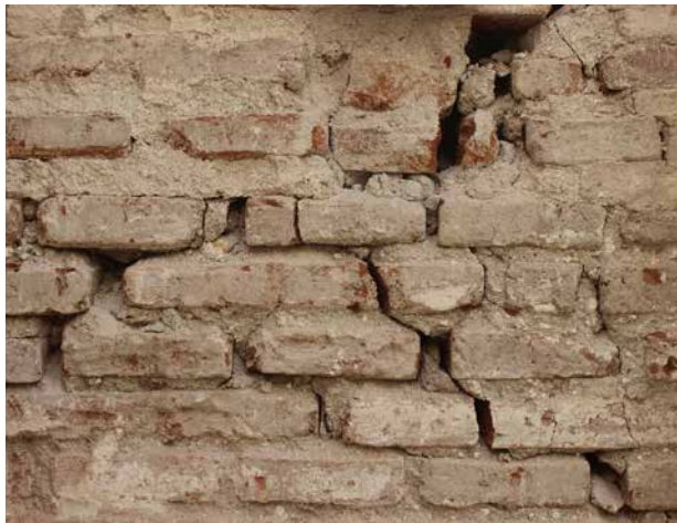
Piezas de ladrillo de barro fracturadas.
