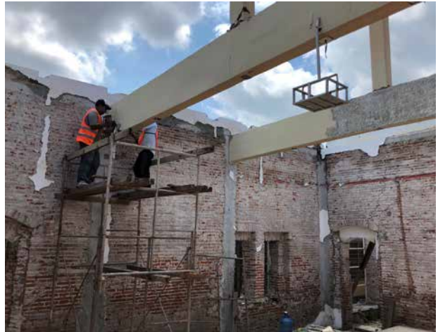
Liberación de aplanados en muros y trabes.
