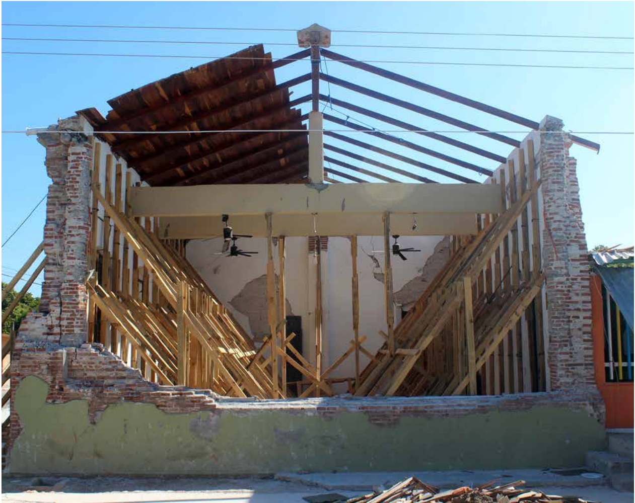
Apuntalamiento de retención y puntales al interior del edificio.
