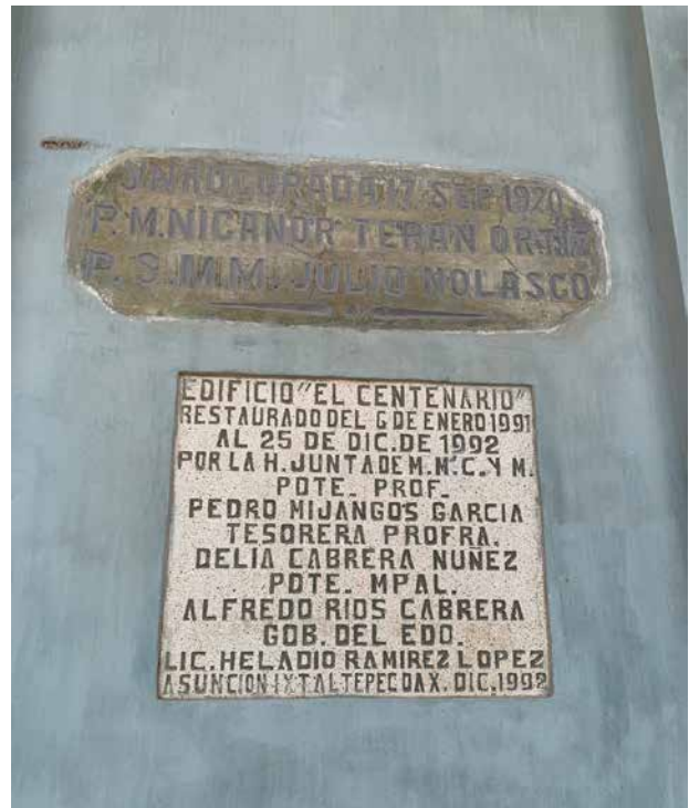
En el acceso al edificio, se pueden identificar las distintas placas de los momentos de la intervención.
