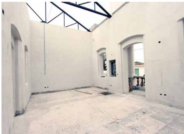
Vestíbulo de acceso al edificio.
