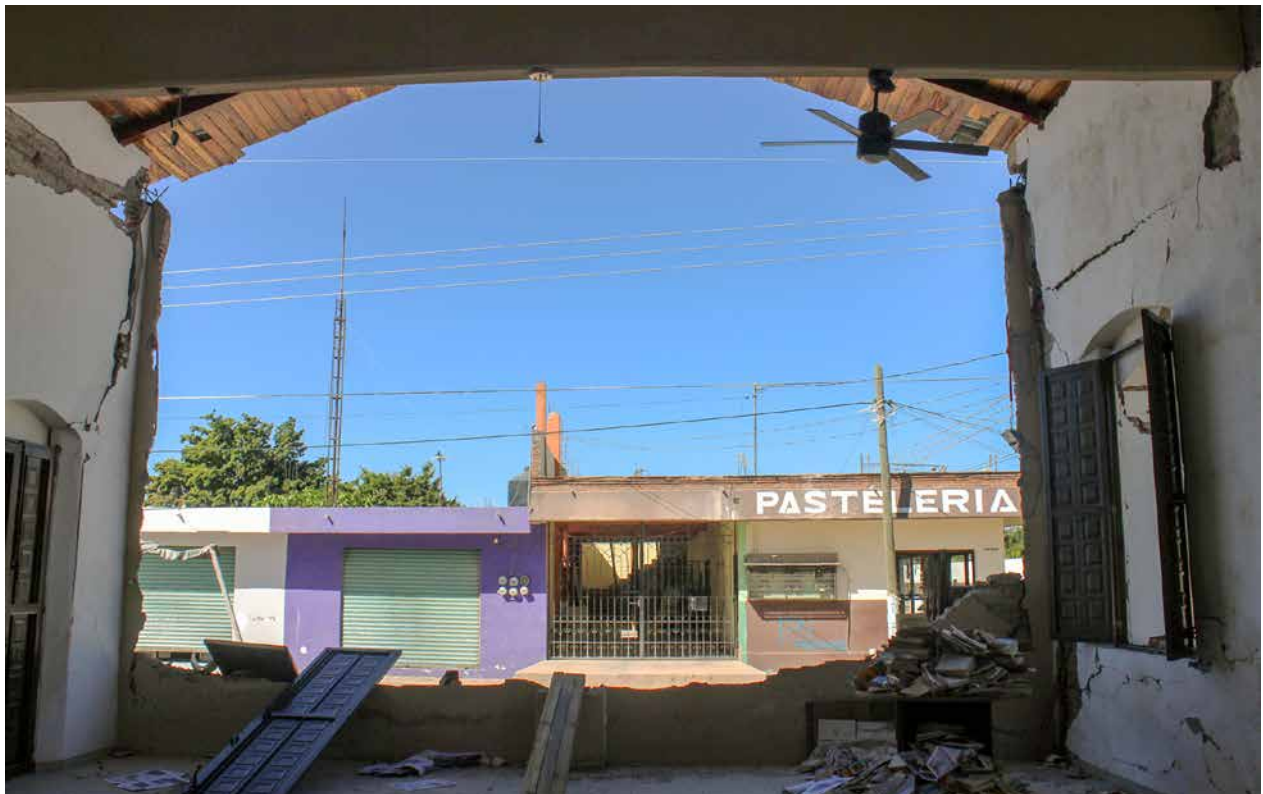
La fachada poniente colapsó en su totalidad, dejando a nivel de piso, 60 cm de muro, aproximadamente.
