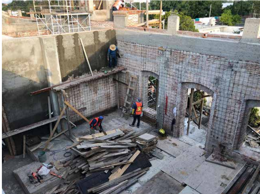
Confinamiento de muros usando malla electrosoldada.
