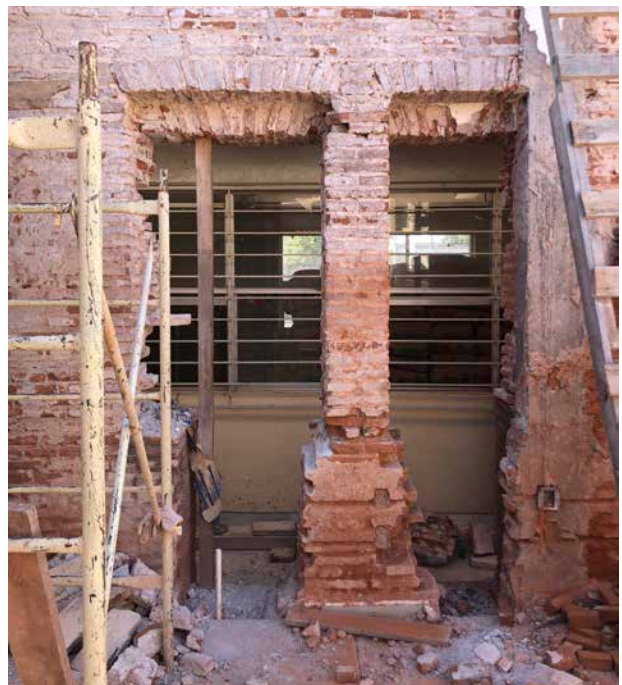
Liberación de aplanados en muros y trabes.
