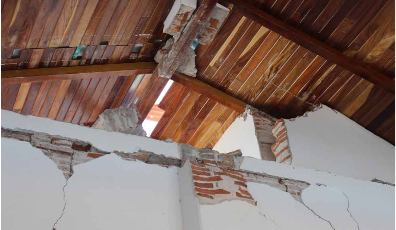
Remate de muros triangular y cumbrera colapsados. En la imagen se observan las fracturas y separación de elementos en muros.
