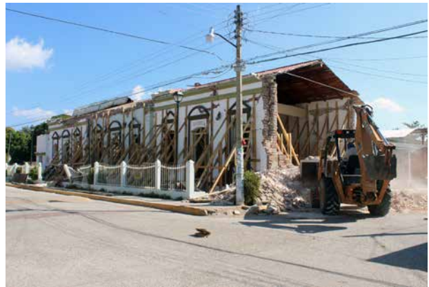
Extracción de escombros.
