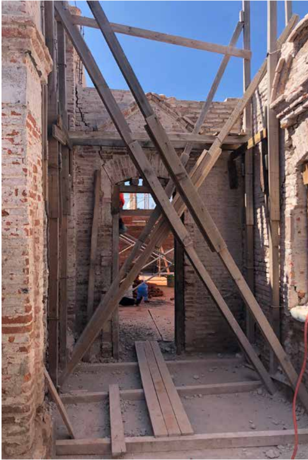
Grietas diagonales en muros y fracturas en enmarcamientos y cerramientos de vanos.
