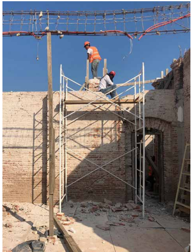
Liberación de elementos estructurales fracturados.
