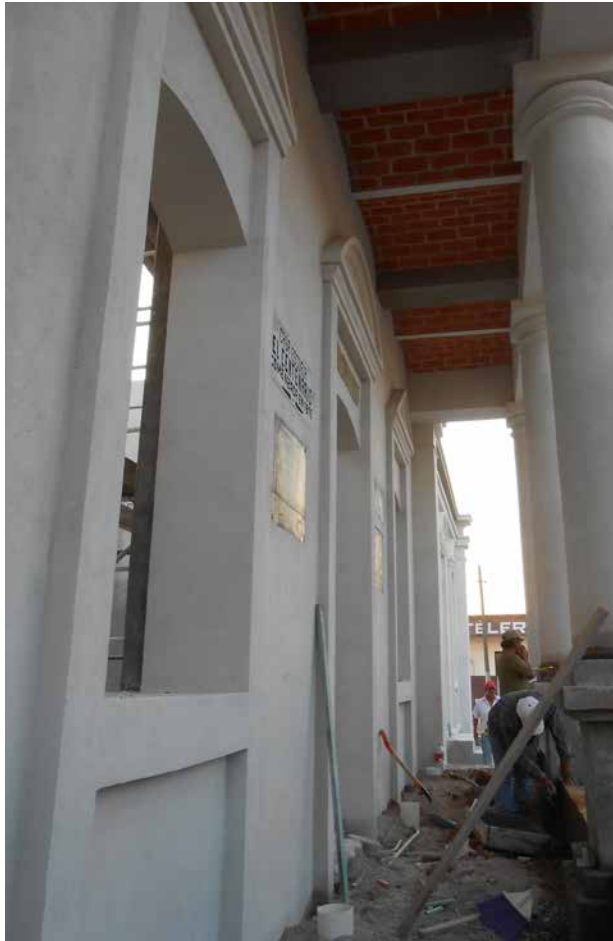
Cubierta de bóvedas catalanas en el pórtico de acceso.
