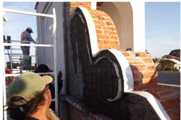
Reconstrucción de elementos ornamentales del remate.
