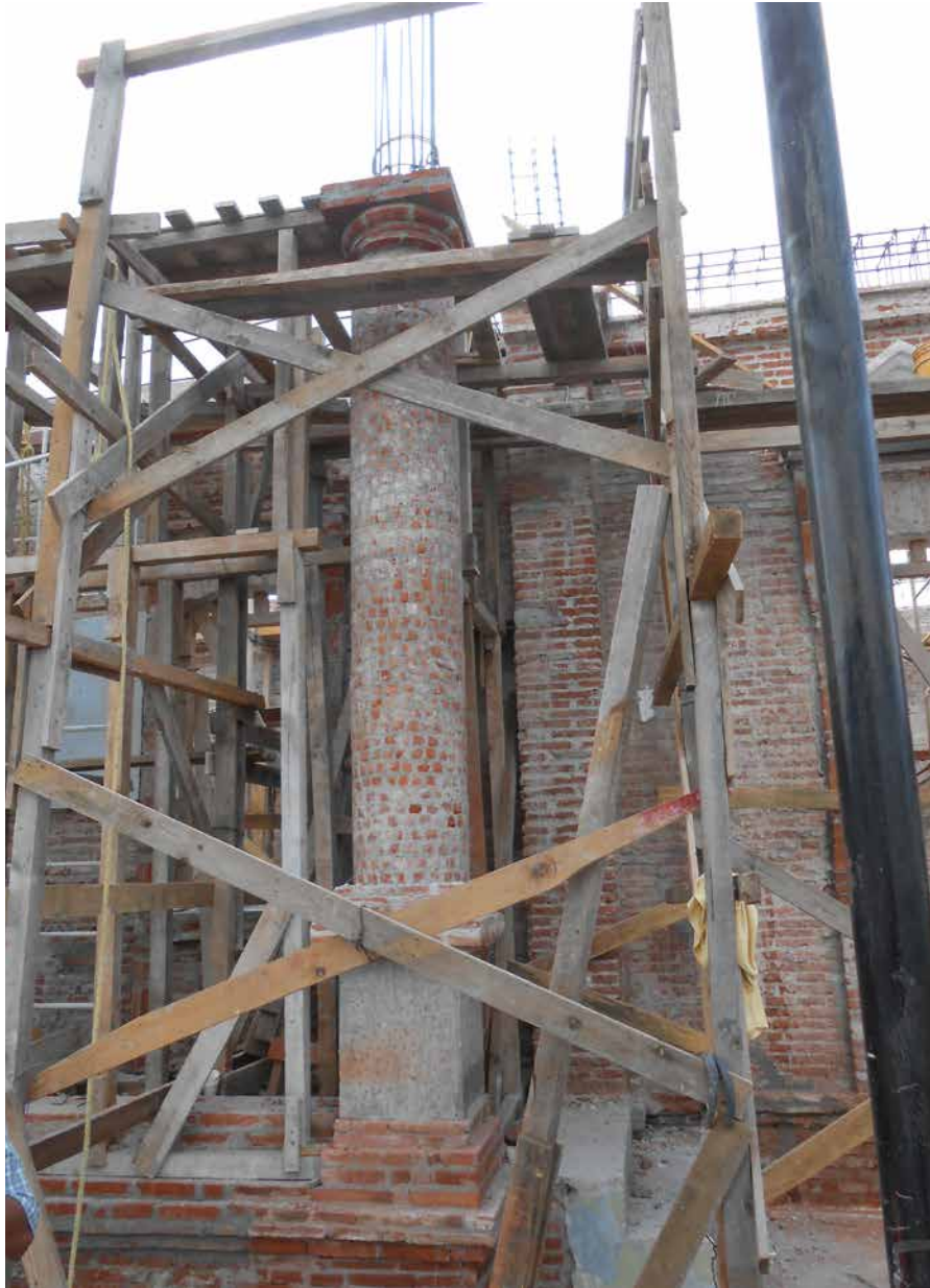
Reconstrucción de las columnas de ladrillo, realizada desde la cimentación.
