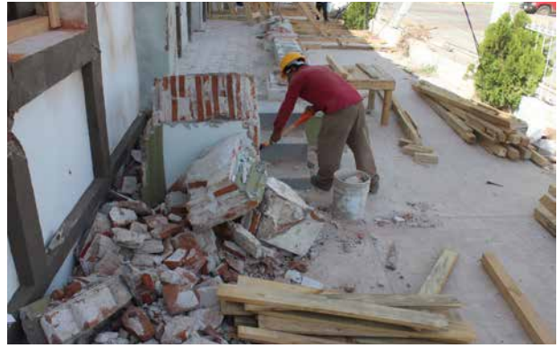
Restos del remate y columnata colapsados.
