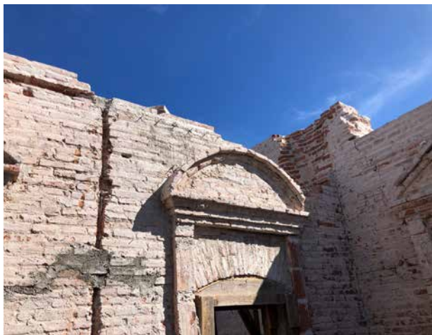
Los muros miden, en promedio, 60 cm de espesor.
