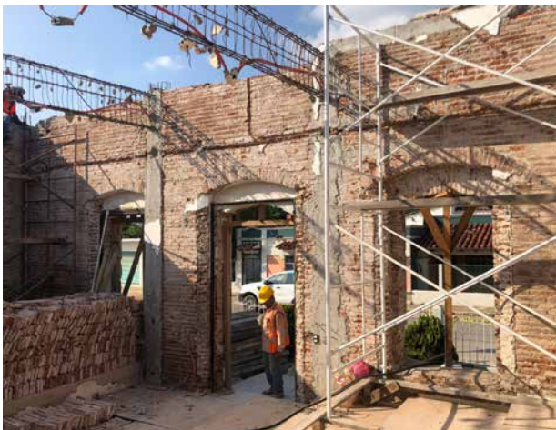
Liberación de trabes de concreto para reestructuración de muros y elementos de carga.
