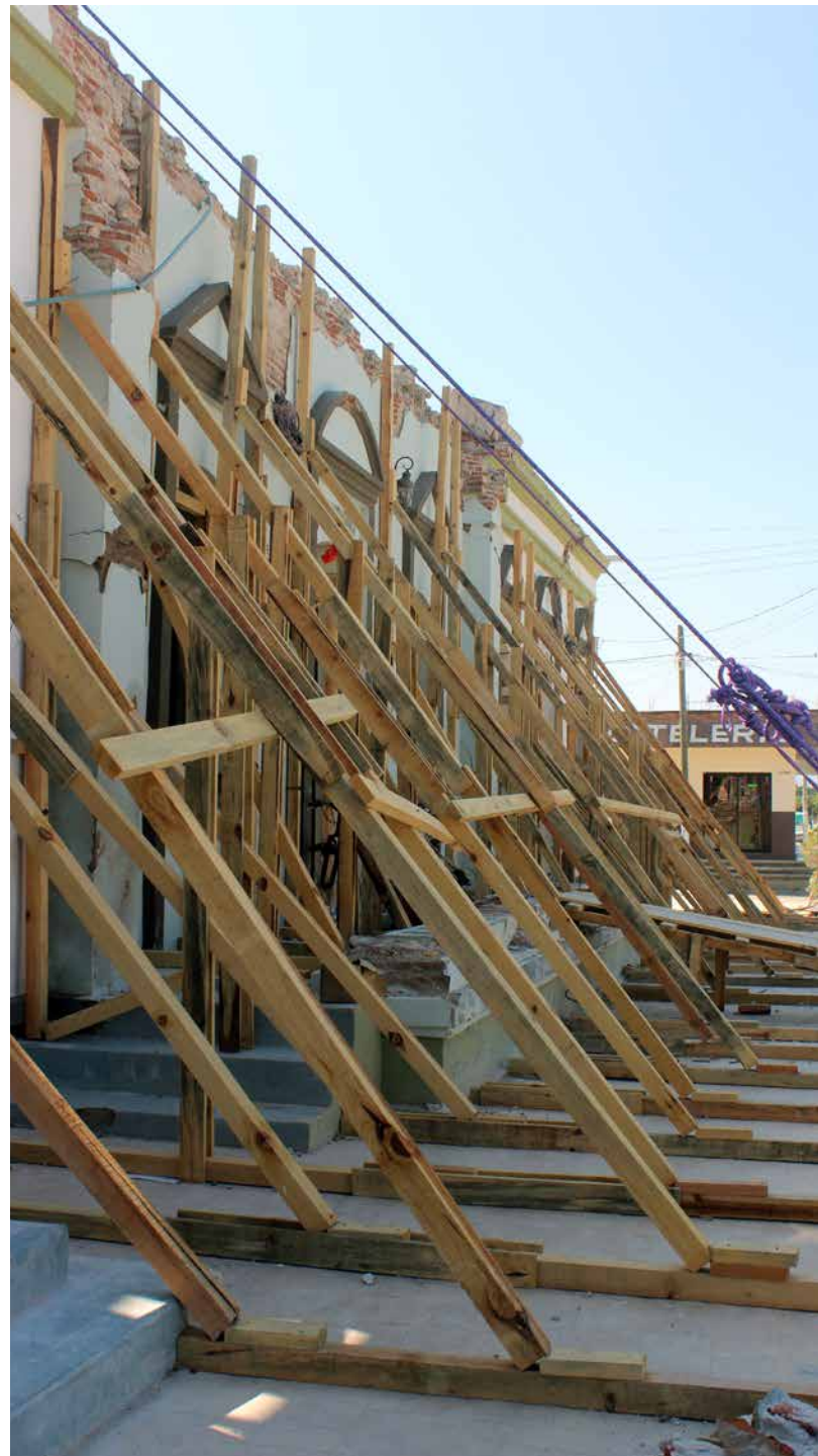
Apoyos verticales y diagonales al interior para soportar los muros.
