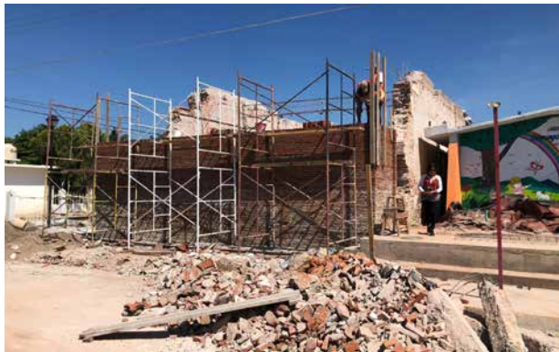
Integración de muros colapsados, a partir de 60 cm de desplante.
