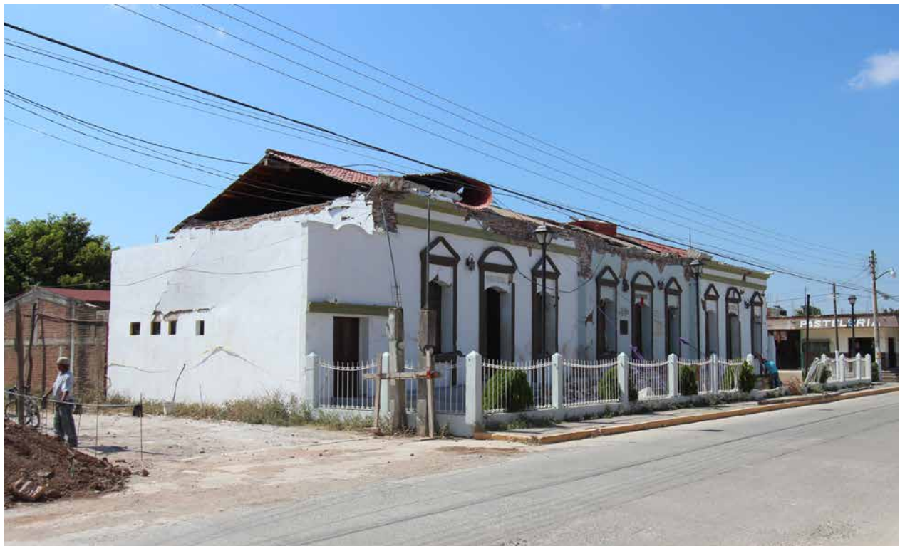
La construcción adosada en el lado oriente de la Casa del Pueblo, corresponde a un agregado posterior a la construcción y diseño original.
