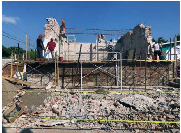
La liberación de aplanados permite explorar e identificar los daños en los elementos.
