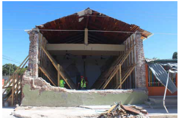
Con la colocación de apuntalamientos, se realizó la liberación controlada de materiales en riesgo de colapso.
