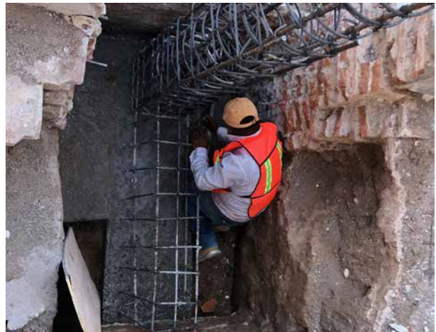
El cálculo estructural realizado al edificio, ayudó a determinar los puntos de mejoramiento de la cimentación existente.
