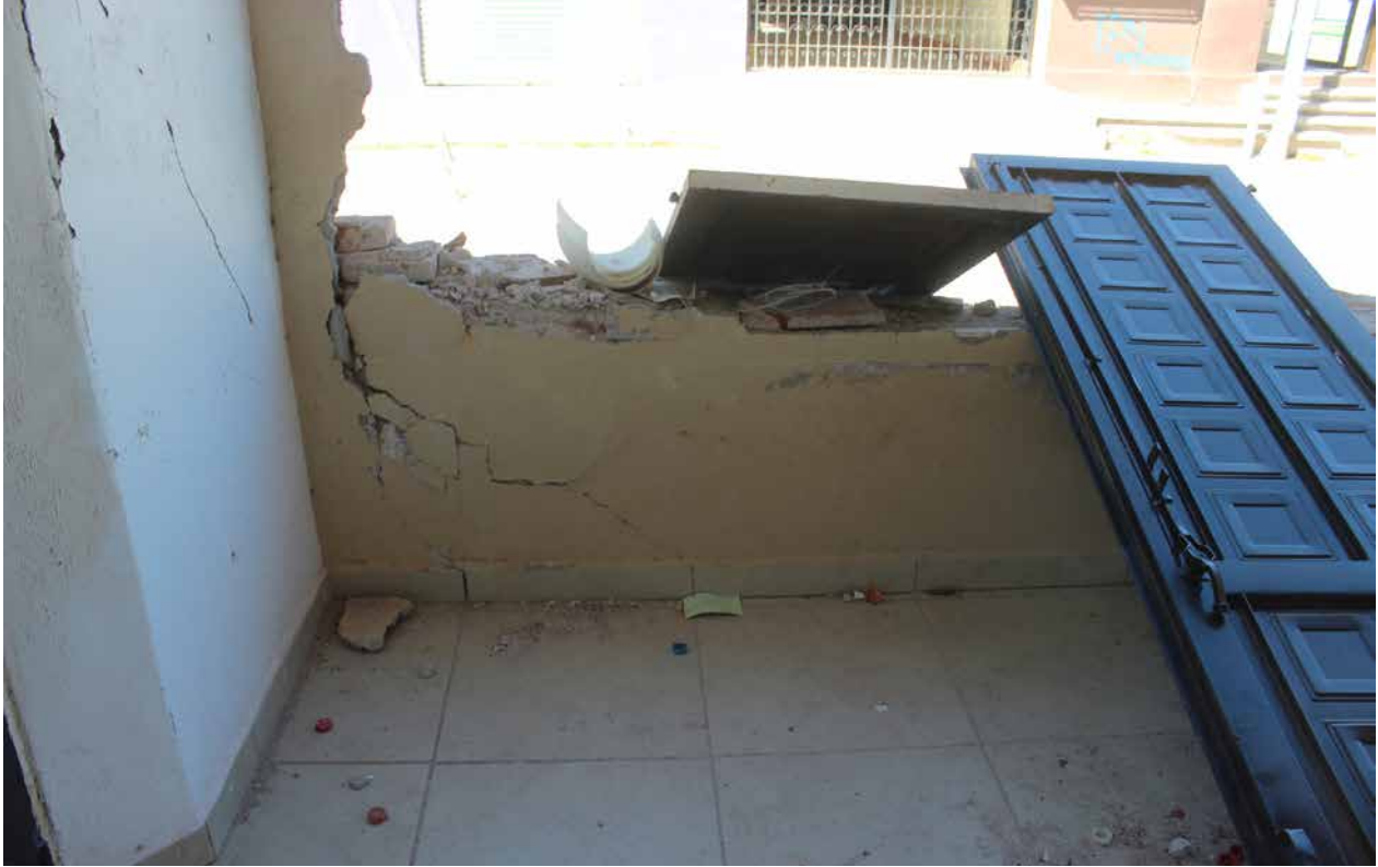
Sección de muro. Fachada poniente colapsada.
