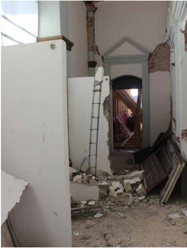
Vestíbulo. Área donde se encontraban los vestidores.
