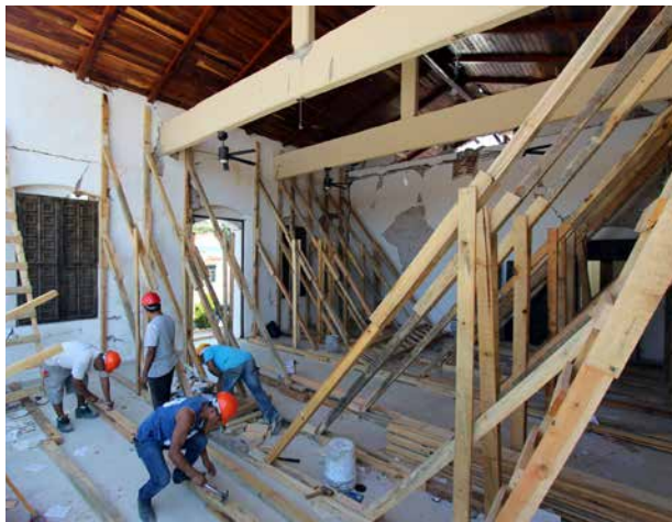
Apoyos verticales y diagonales al interior para soportar los muros.
