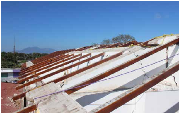
Estructura metálica de canal montén y PTR.
