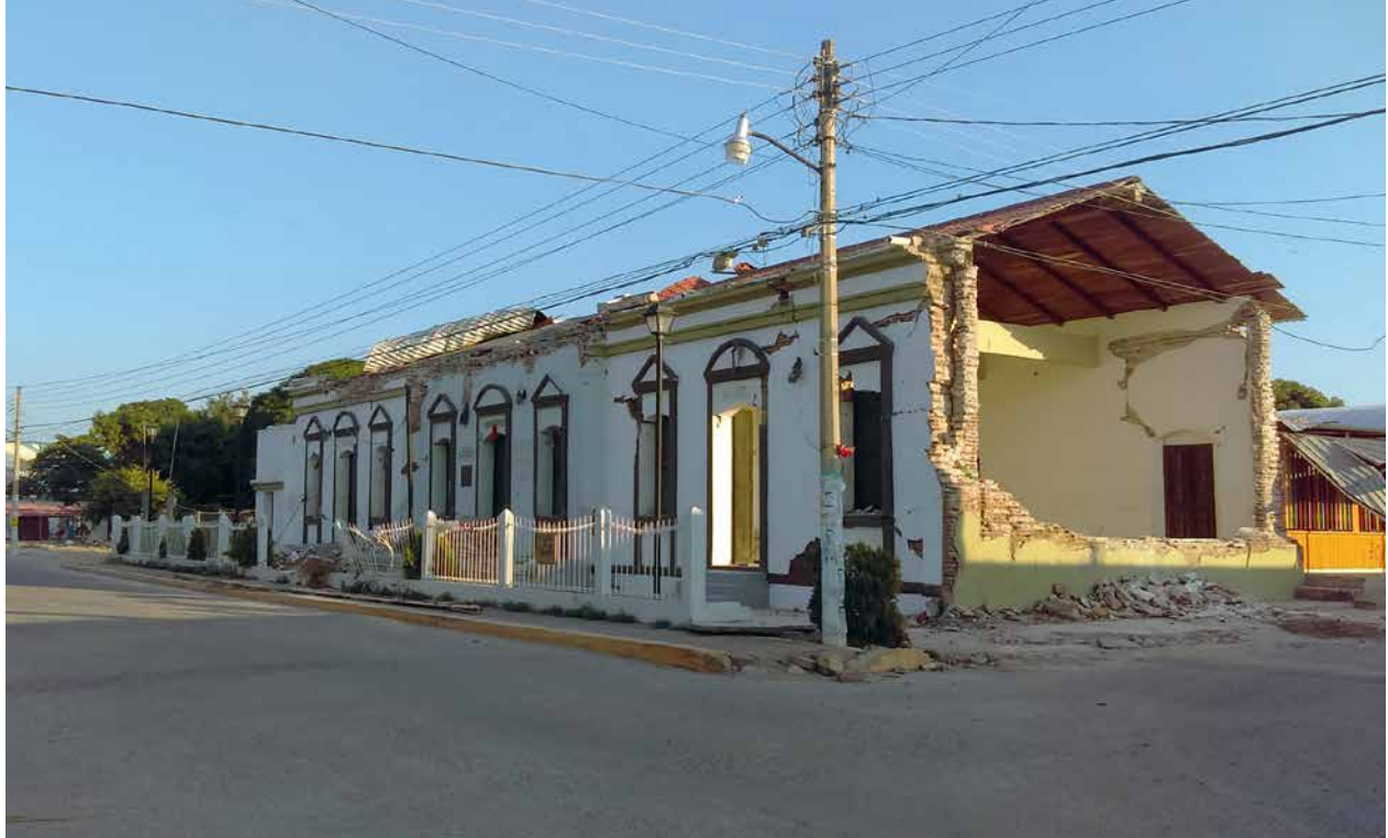
Entre las pérdidas más notables del edificio, se encuentra el colapso de la columnata, remtae y fachada poniente.
