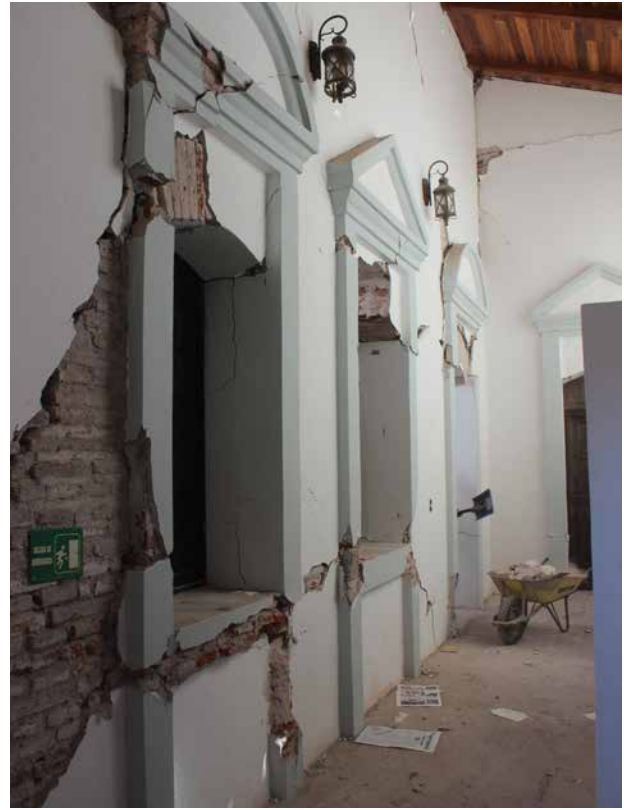
Desprendimiento y fracturas en vanos del vestíbulo.
