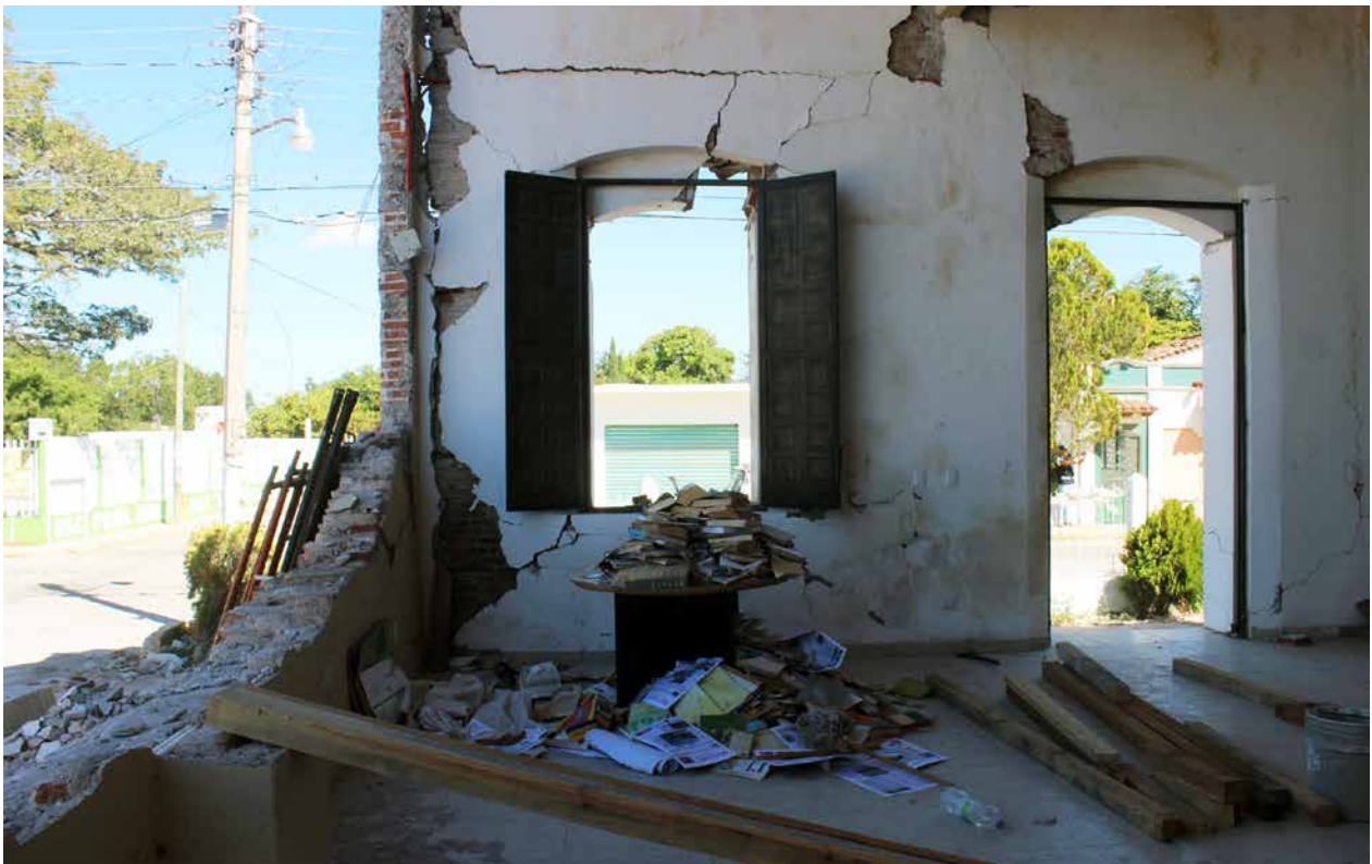
Separación de muros, grietas horizontales y diagonales en esquinas de vanos.
