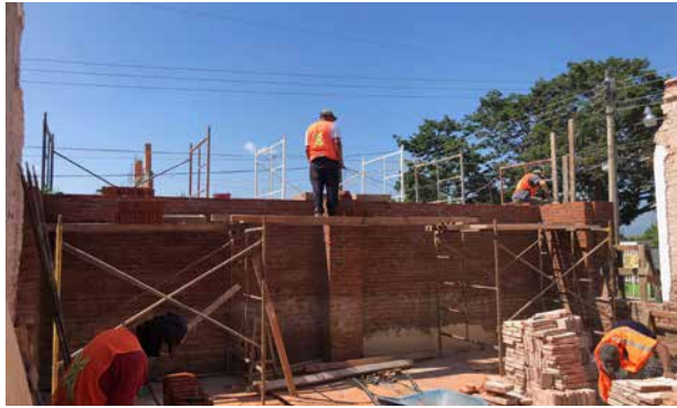
Recuperación de la fachada poniente, empleando ladrillo de barro rojo cocido. Al centro, elemento de reforzamiento.
