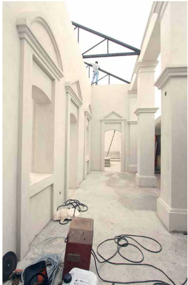
Una armadura y cubierta a dos aguas recorre todos los espacios del edificio inicial.
