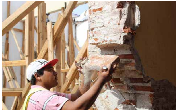
Liberación de material disgregado en muro fracturado.
