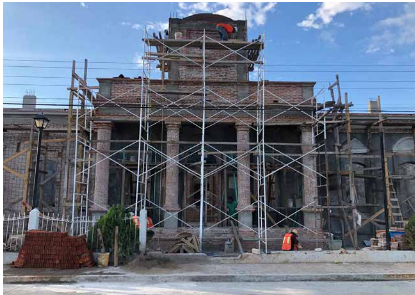
Pórtico recuperado, de acuerdo con material histórico.
