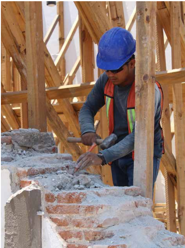
Liberación de tabiques sueltos y fracturados en muros.
