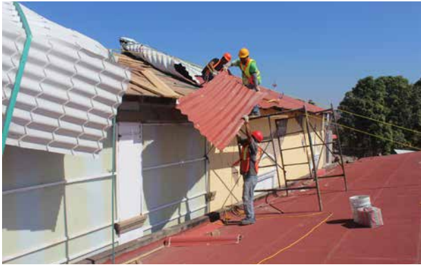
Liberación de lámina galvateja de la cubierta.
