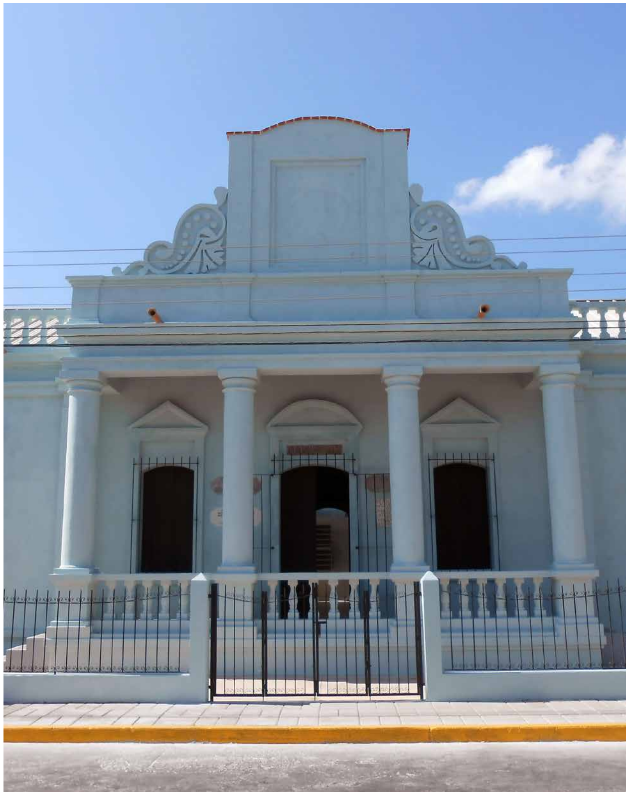
Sección de la fachada. Columnata, remate y balaustrada recuperados.
