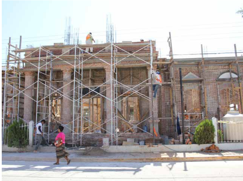
Recuperación y reforzamiento de la columnata y remate, colapsados durante el sismo 2017.
