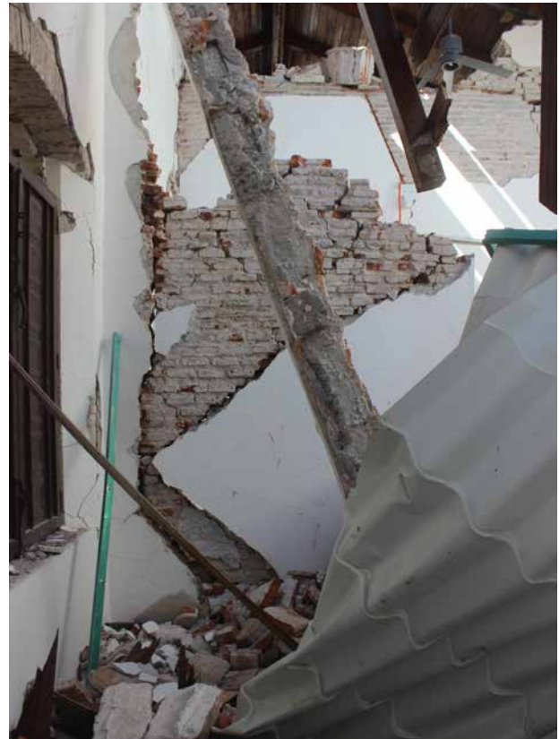
Colapso de cubierta y elementos estructurales.
