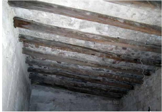
Sistema primitivo de cubiertas inclinadas de la casa de visitas, basado en morillos y terrado.
