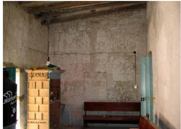
Crujía oriente de la casa de visitas, donde se puede apreciar el sistema de cubiertas inclinadas y morillos.
