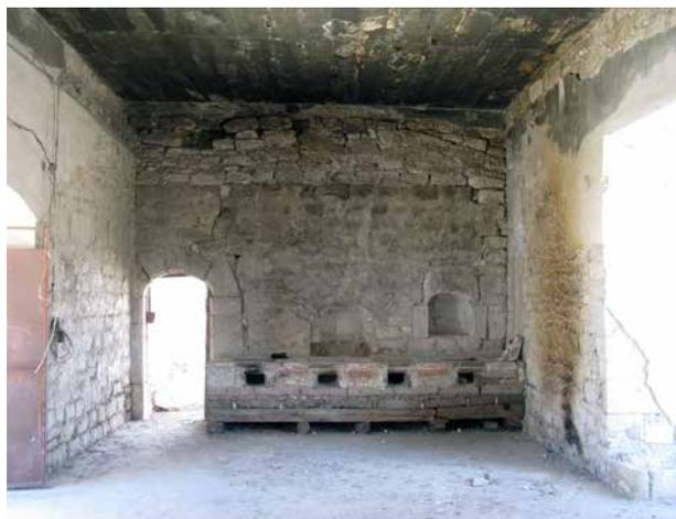
Agregado de hornillas, pérdida de piezas de piedra en muro, desprendimiento de aplanados y losa de concreto armado.
