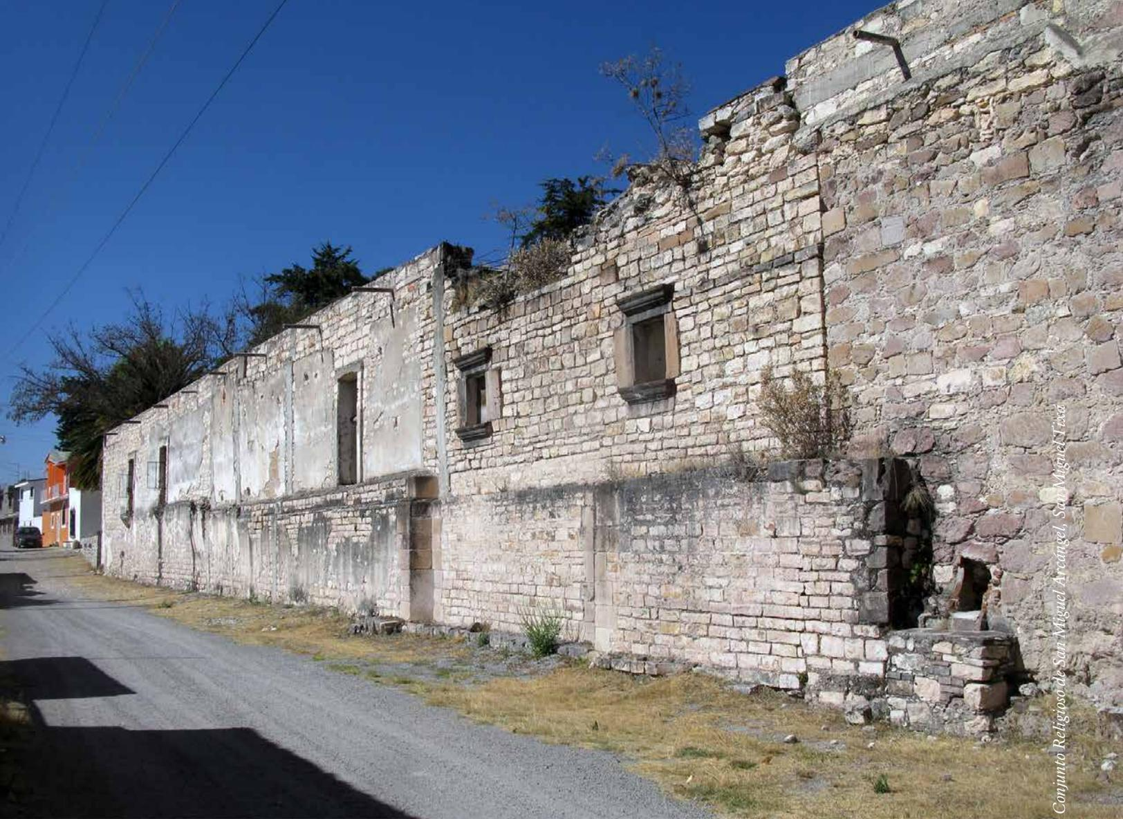
Muros de sillares de piedra de la región con agregados de concreto.
