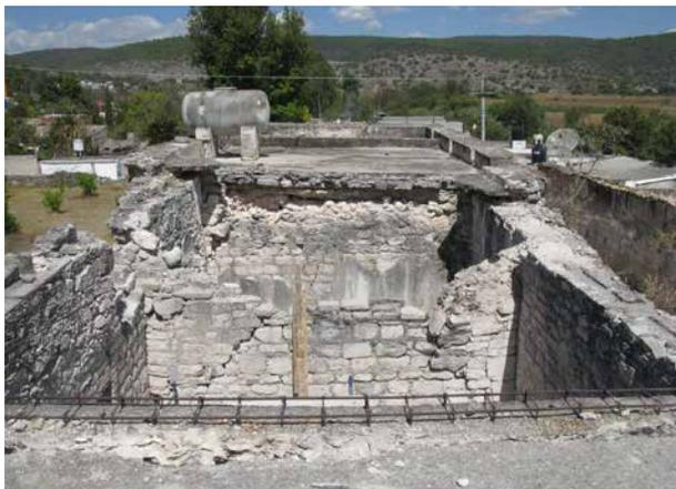
Cubierta trabajada, liberación de losa de concreto, faltante de losa y enladrillado de cubierta terminada.
