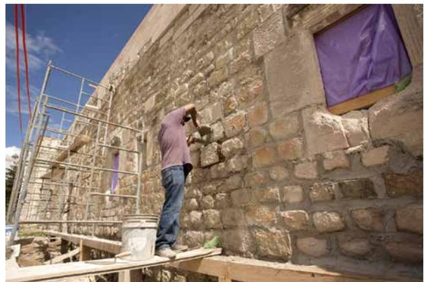
Integración de juntas en muros.
