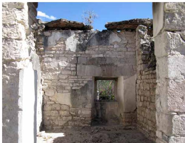
Pérdida total de cubierta, colapso parcial de muros y desprendimiento de aplanados.
