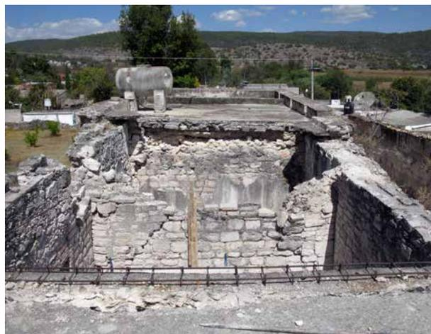
Colapso de cubierta en crujías, colapso parcial de muros y agregados de losa de concreto y tinacos de asbesto.
