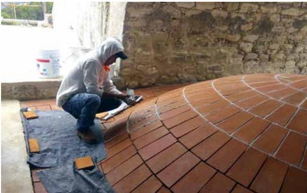
Integración de juntas a base de cal en enladrillado de cúpula.
