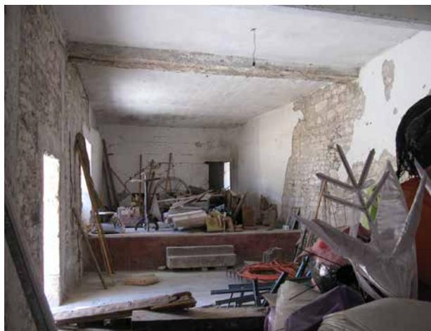
Vista interior de crujía, cubierta y cadenas de concreto armado, alteración de niveles de piso.
