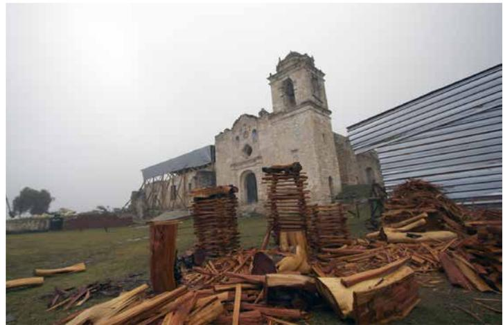
Las secciones de tejamanil se utilizaron para constituir la cubierta de la casa de visitas.
