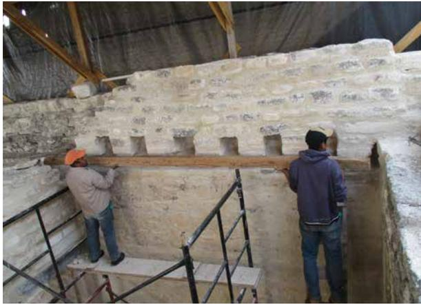
Integración de viga de arrastre en muros.
