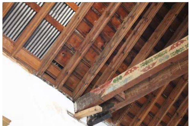
Vista de la cubierta, en donde se puede apreciar la viga tirante, vigas pares, entablado y lámina galvanizada.
