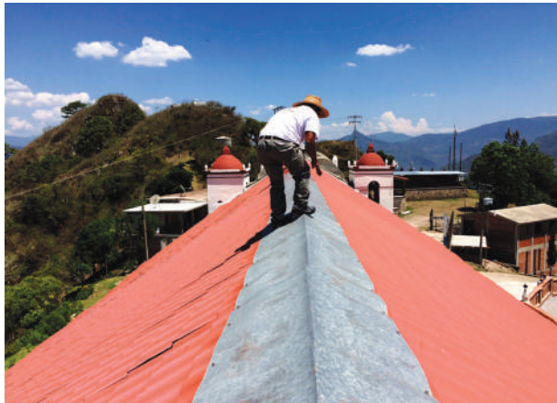
Vista exterior de cubierta del templo.
