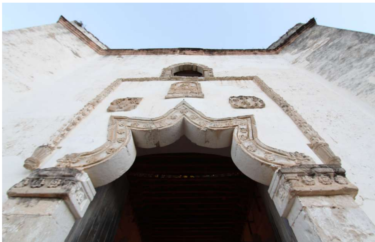
Arco festonado y atributos franciscanos presentes en la fachada principal del templo.
