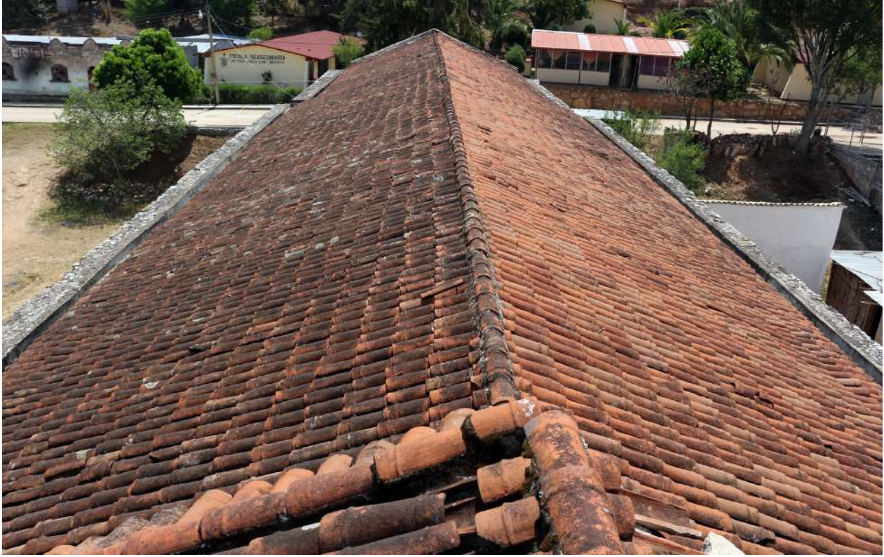
Vista de la cubierta hacia el presbiterio.
