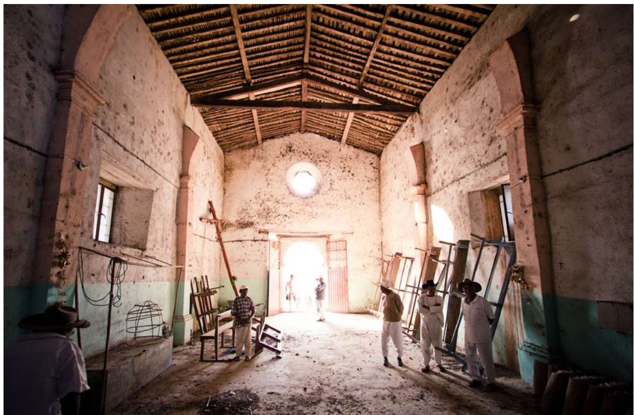
Vista interior del templo vista hacia el acceso, se pueden apreciar pilastras con arranques de arcos, aplanados de muros y cubierta de armadura mixta a base de vigas de madera y otate.
