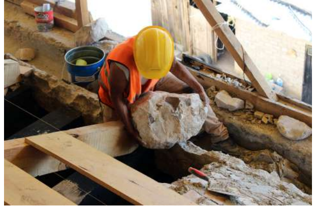
Consolidación de muro.
