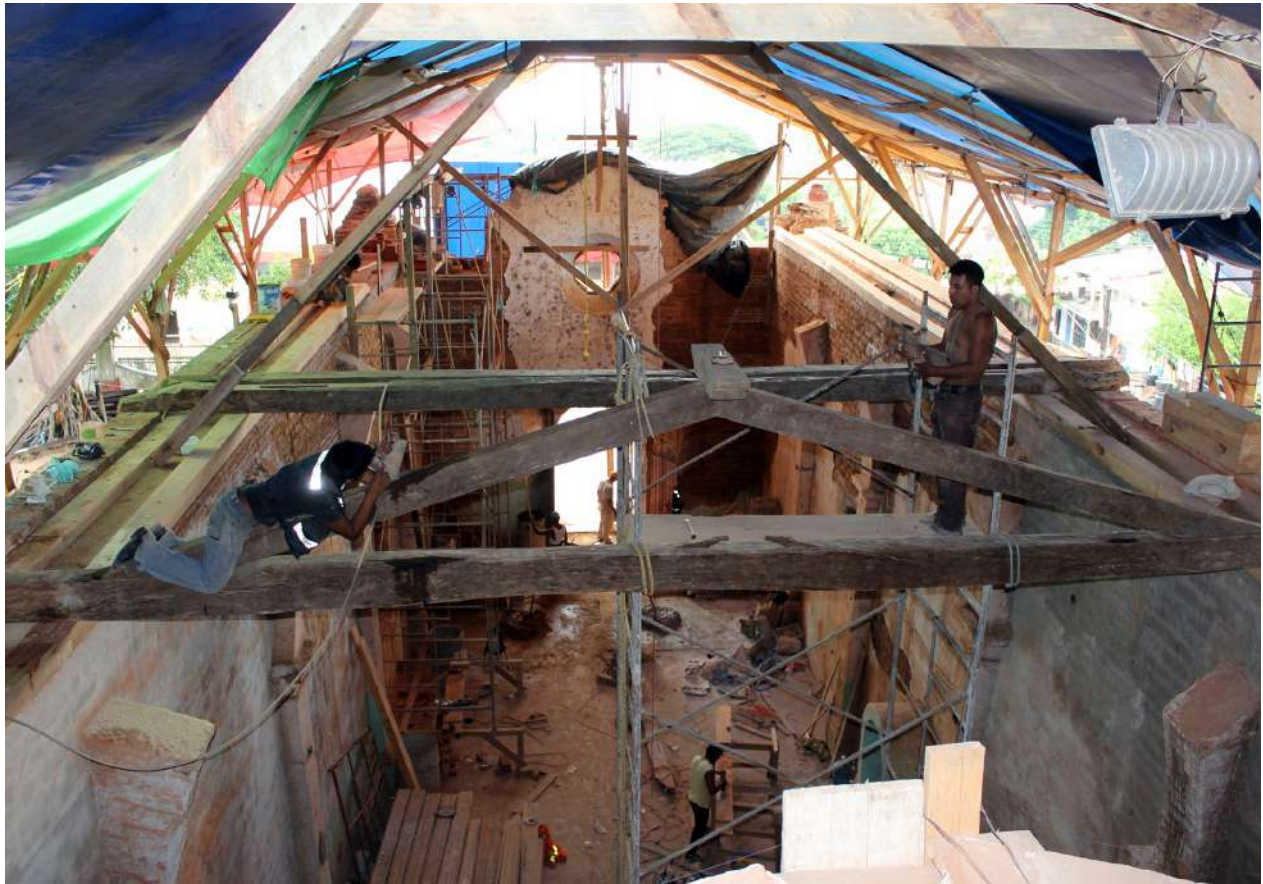
Integración de armaduras de madera.
