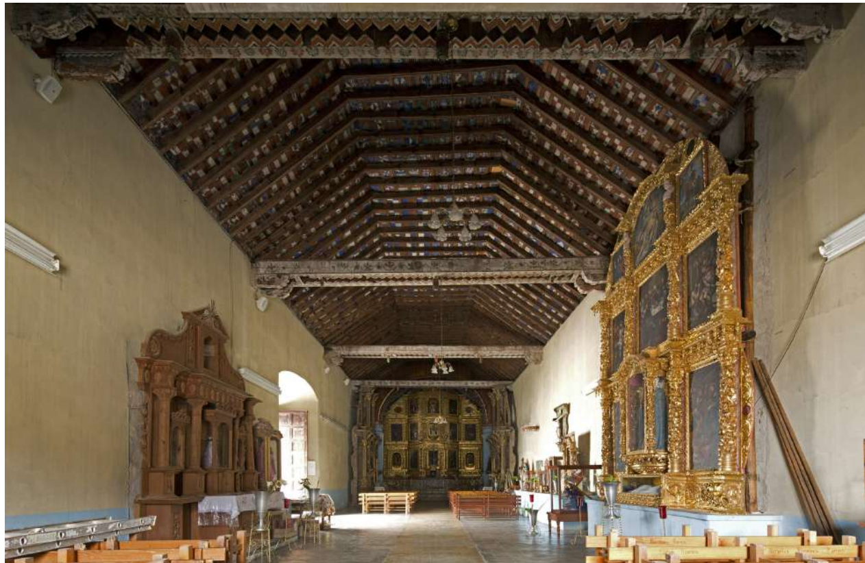
Vista interior del templo, donde se aprecian la cubierta de par y nudillo, los retablos y, al fondo, el presbiterio.
