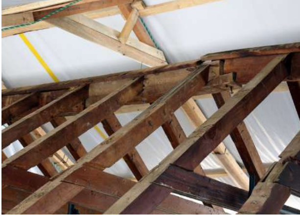
Armadura de madera, vigas par, nudillos y viga cumbrera.
