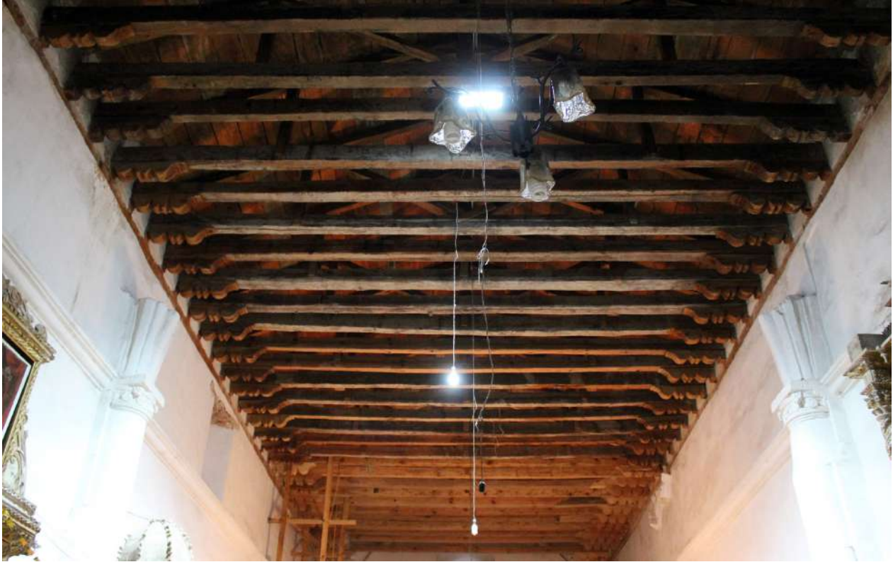
Cubierta de armaduras de madera recuperada en el área de la nave.
