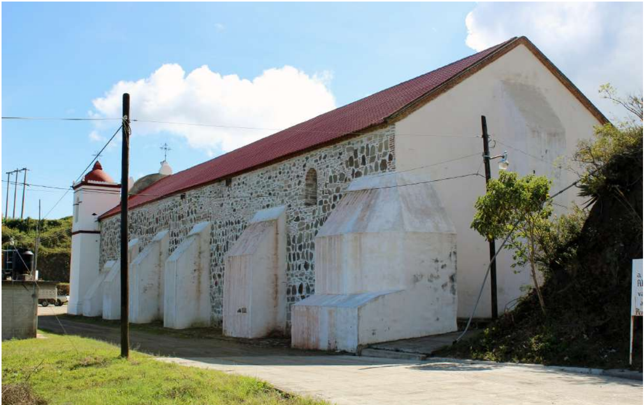
Vista de fachada lateral y posterior.
