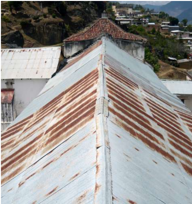
Vista exterior de la cubierta.
