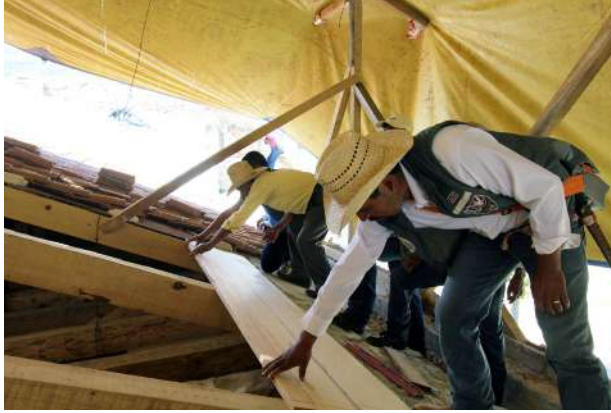
Integración de entablado sobre vigas par.
