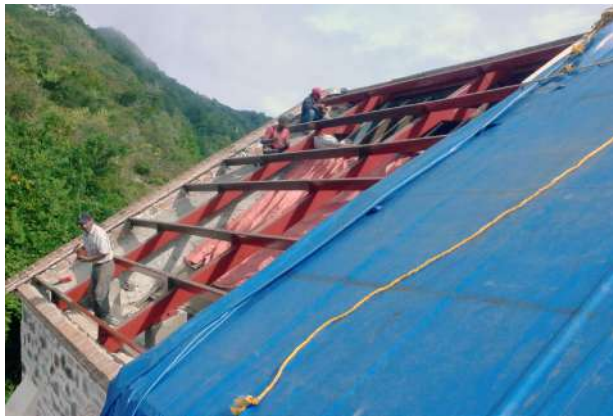
Limpieza de estructura metálica de la cubierta del templo.
