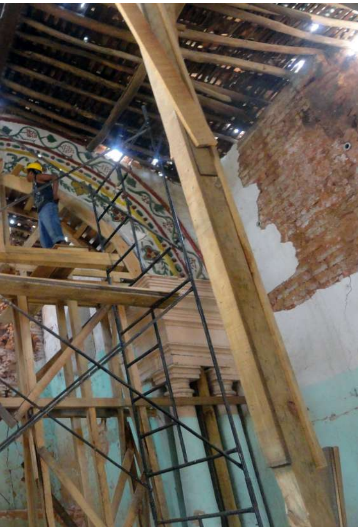
Abajo: apuntalamiento de arco triunfal.
