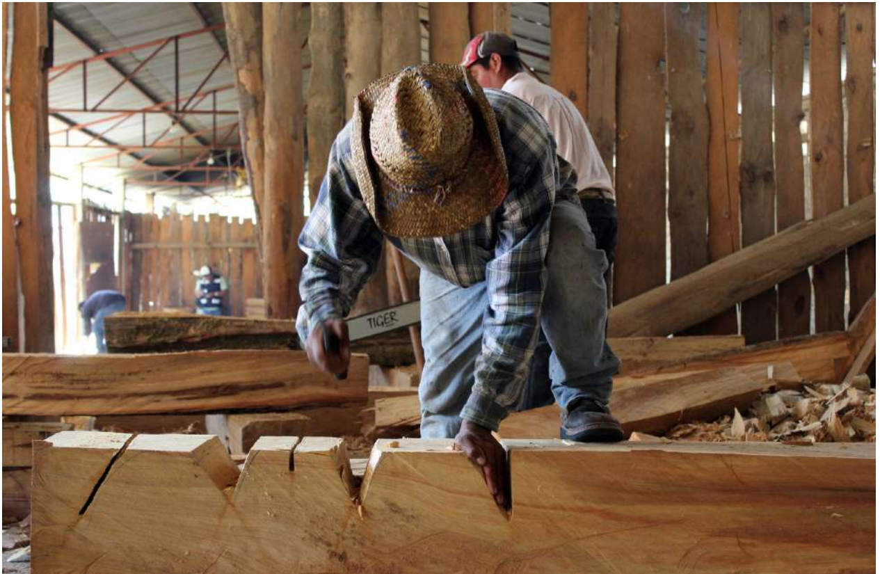
Elaboración de zapatas de madera.
