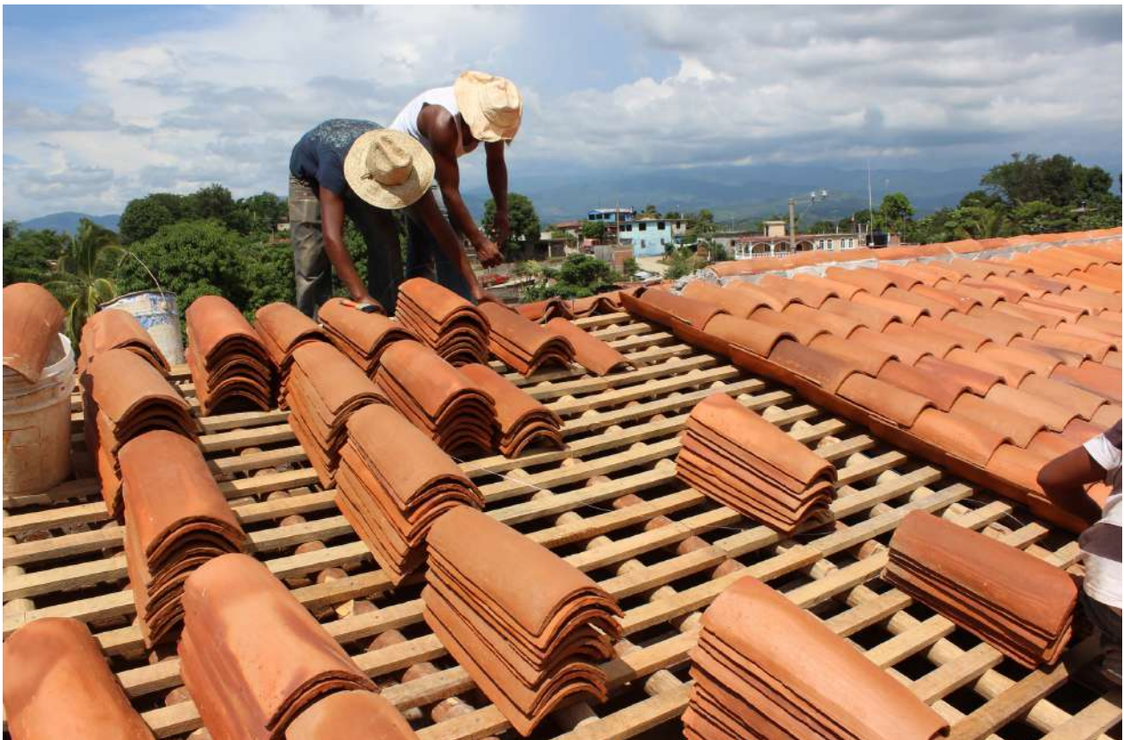
Abajo: integración de teja nueva en la cubierta de la nave.
