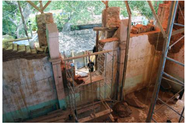
Reconstrucción del muro lateral de la nave.
