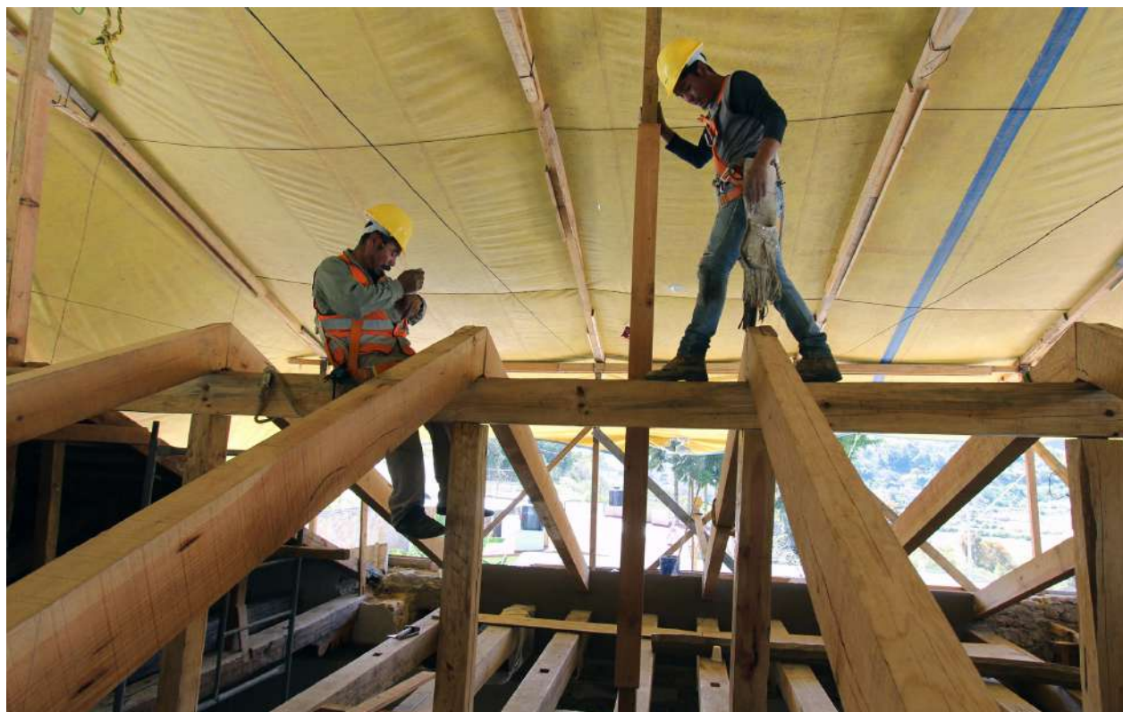
Integración de estructura, pendolones, cumblera y vigas par sobre vigas de carga.
