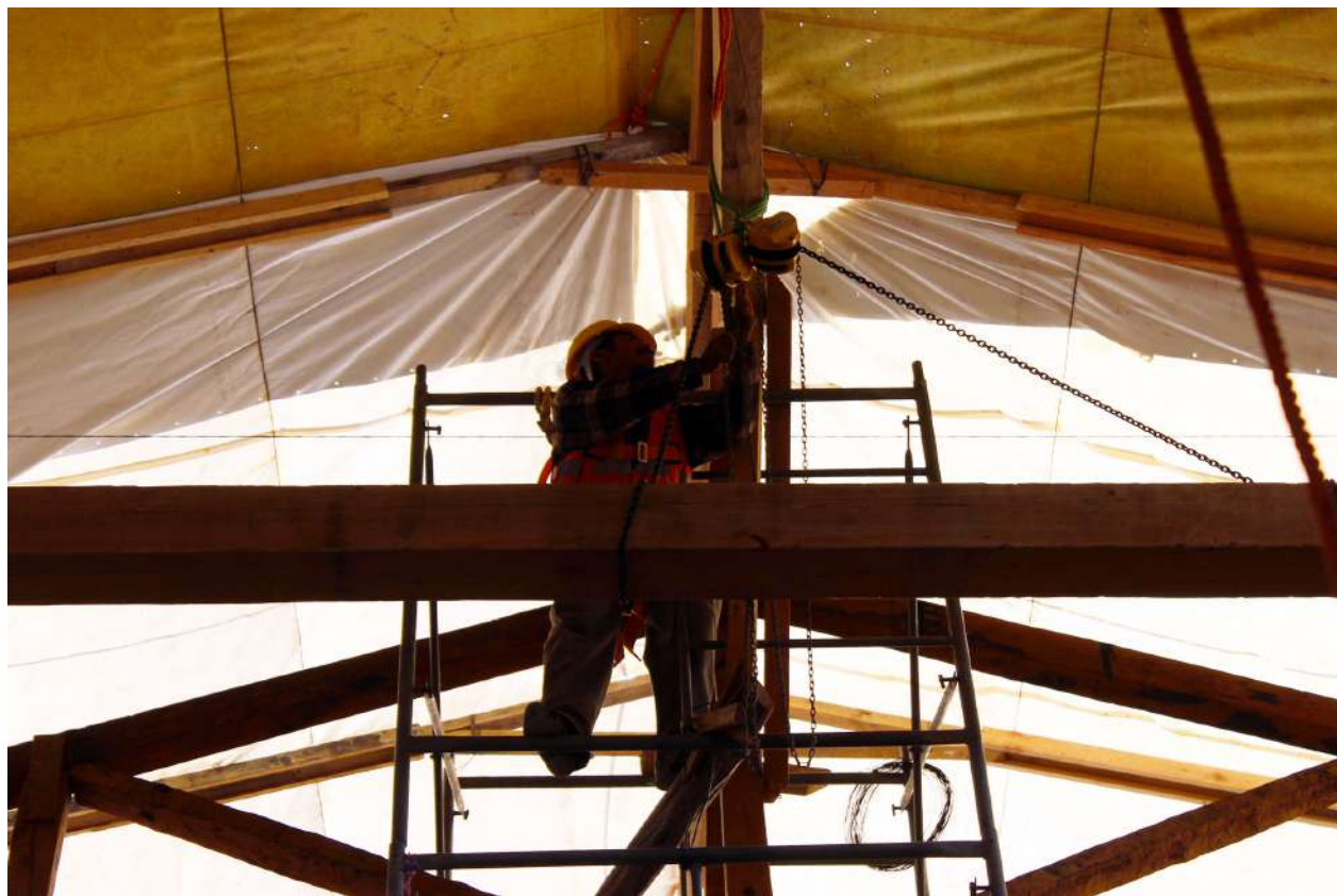
Colocación de vigas.
