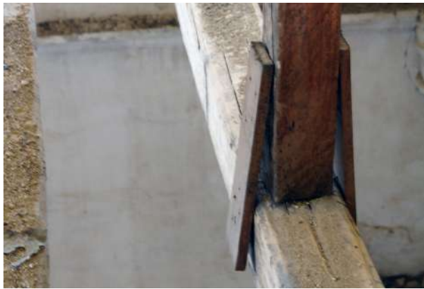
Refuerzos de madera agregados a la armadura.
