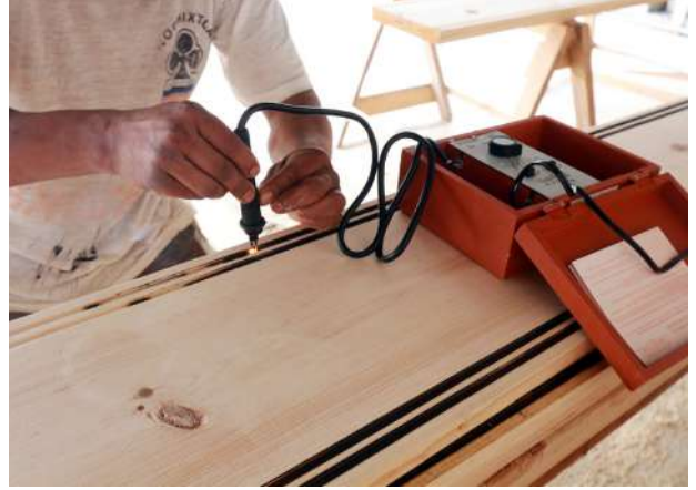
Recuperación de elementos ornamentales de la armadura.
