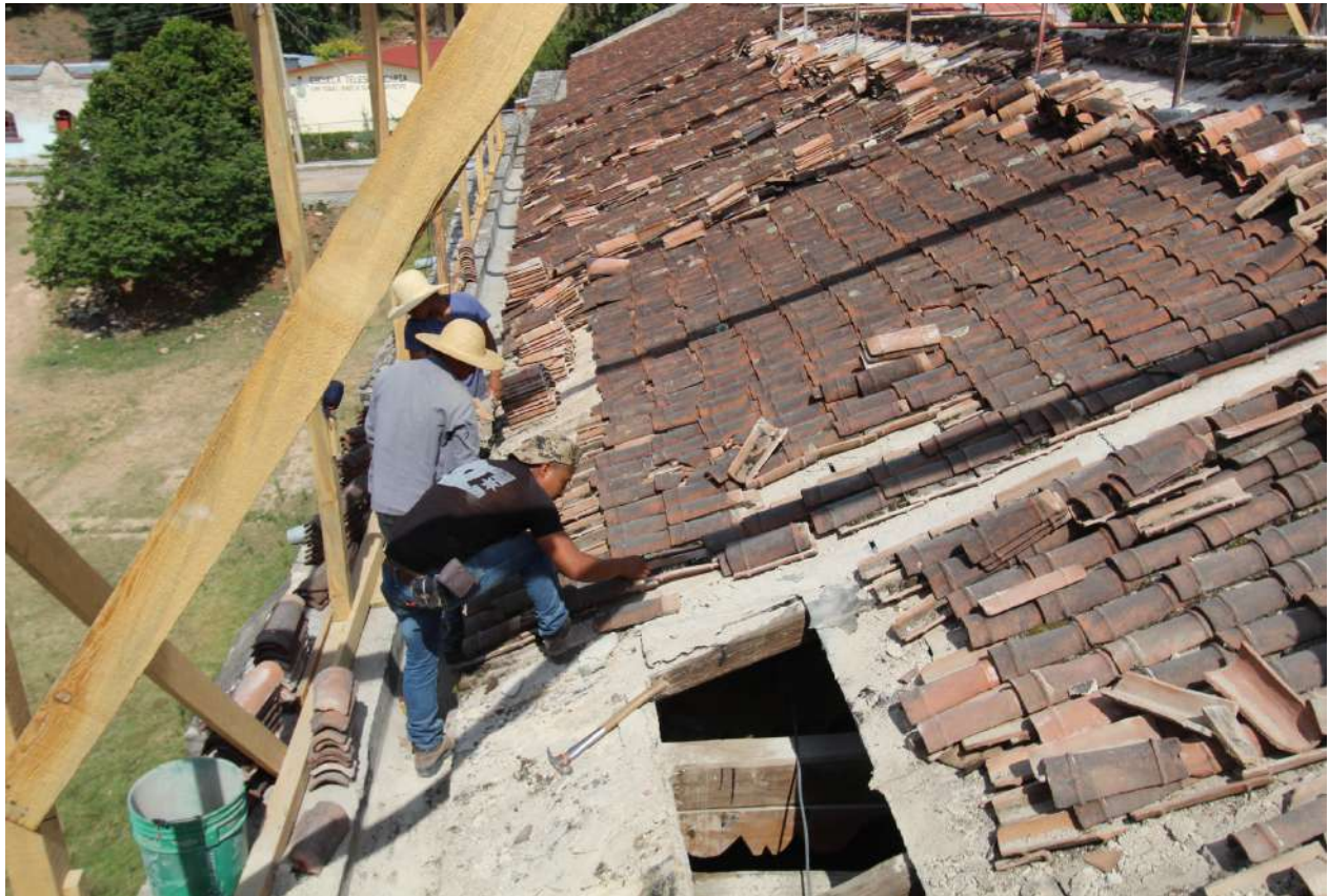
Liberación controlada de tejas para su recuperación.
