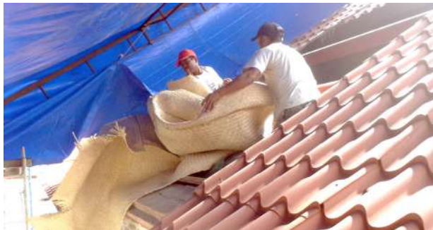
Liberación de petate de palma dentro de la armadura de la cubierta.
