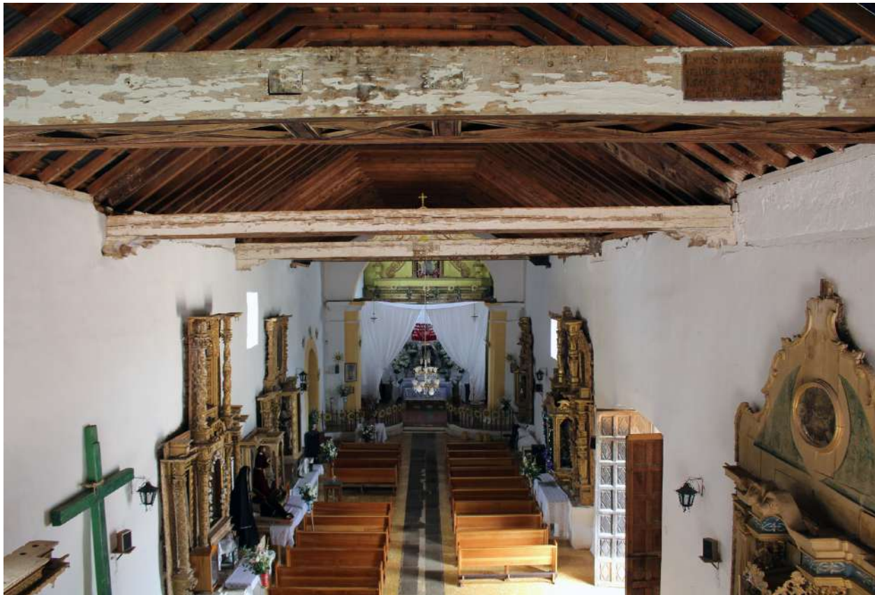
Vista tomada desde el coro, se puede apreciar estructura de la cubierta, en primer plano viga tirante fechada con el año de 1682.
