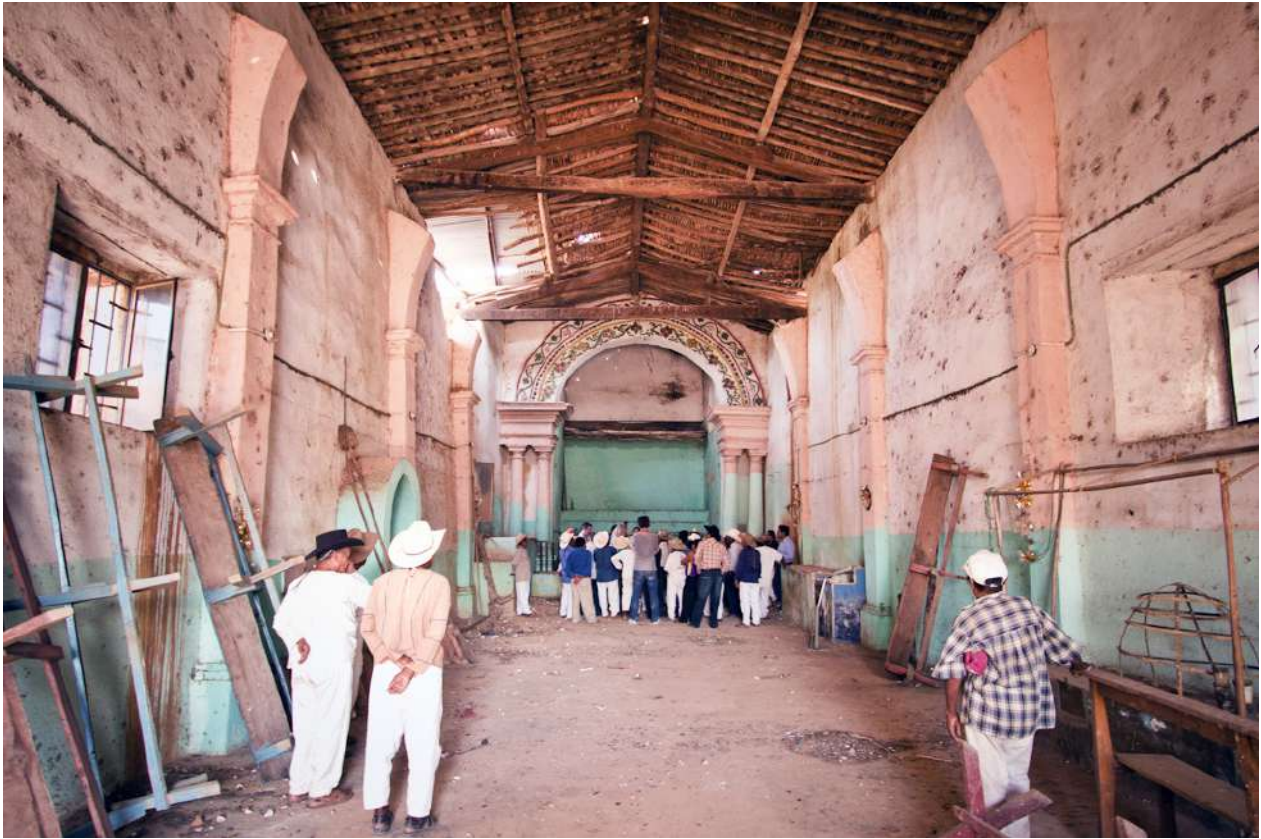
Vista general de la nave donde puede apreciarse arranque de arcos fajones, cubierta de sistema constructivo tradicional y al fondo arco triunfal con columnas pareadas para acceso a presbiterio.
