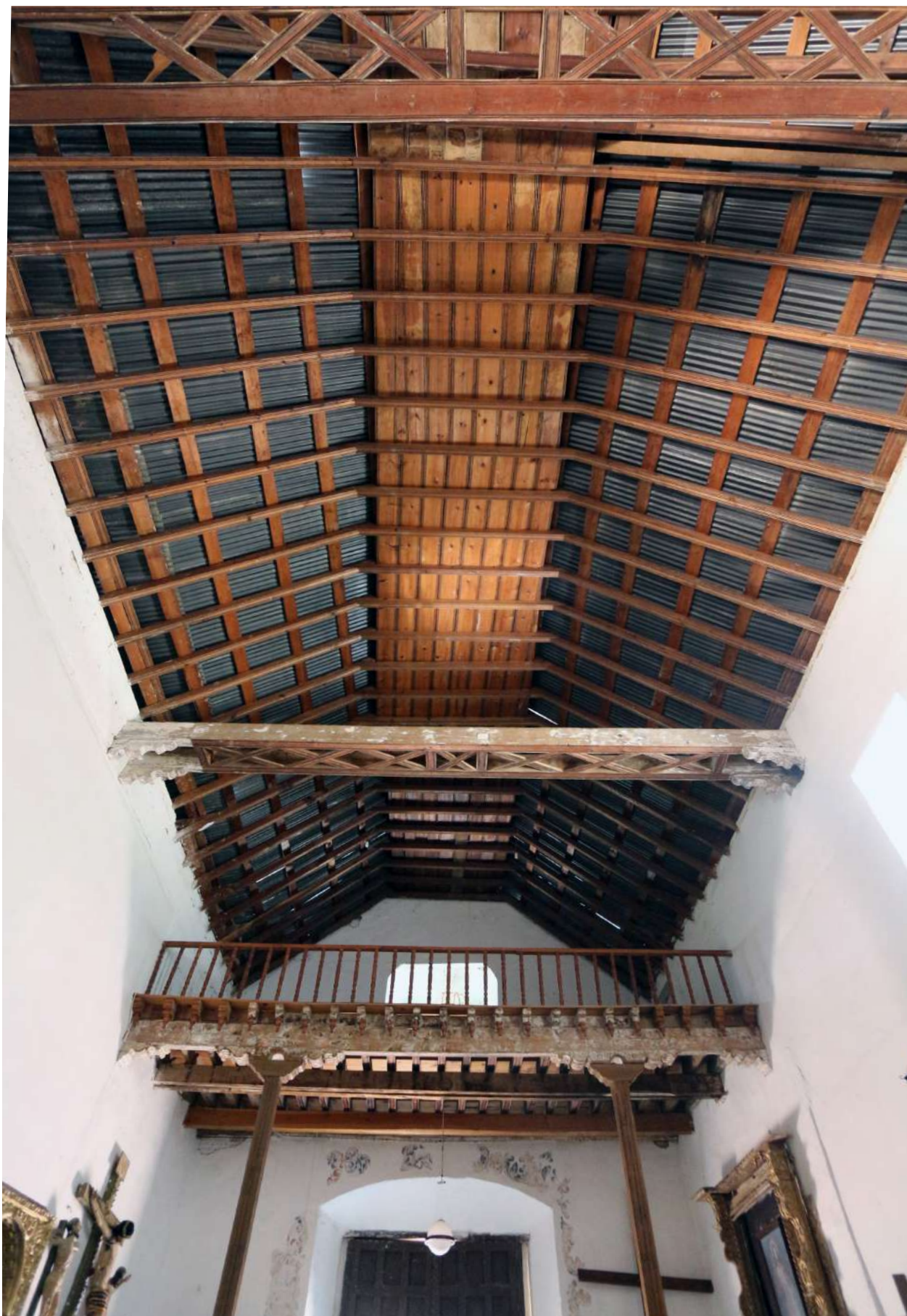
Vista de los trabajos realizados en la cubierta.
