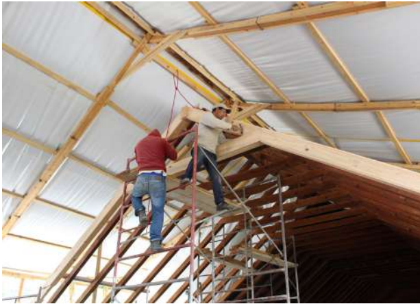
Ensamblaje de la armadura.
