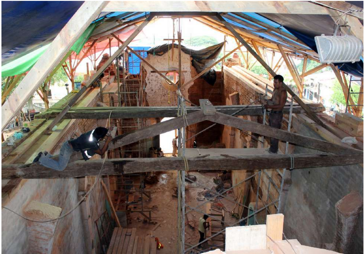
Integración de armaduras de madera.
