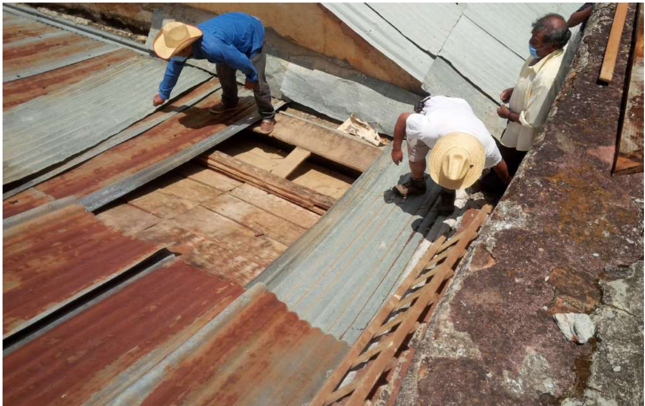
Liberación de lámina galvanizada.
