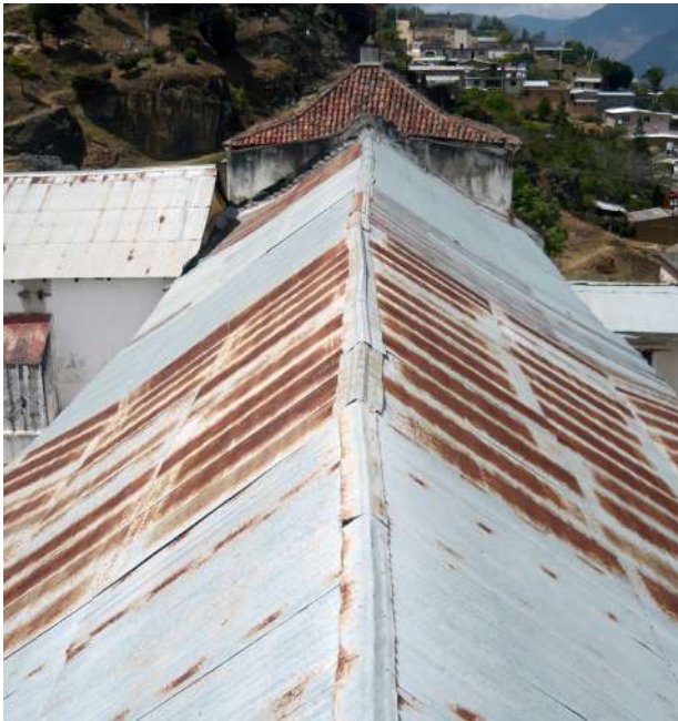
Vista exterior de la cubierta.
