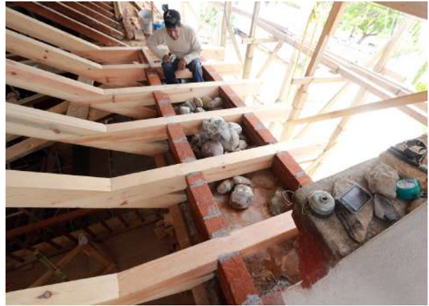
Relleno de piedra de la región en muros.
