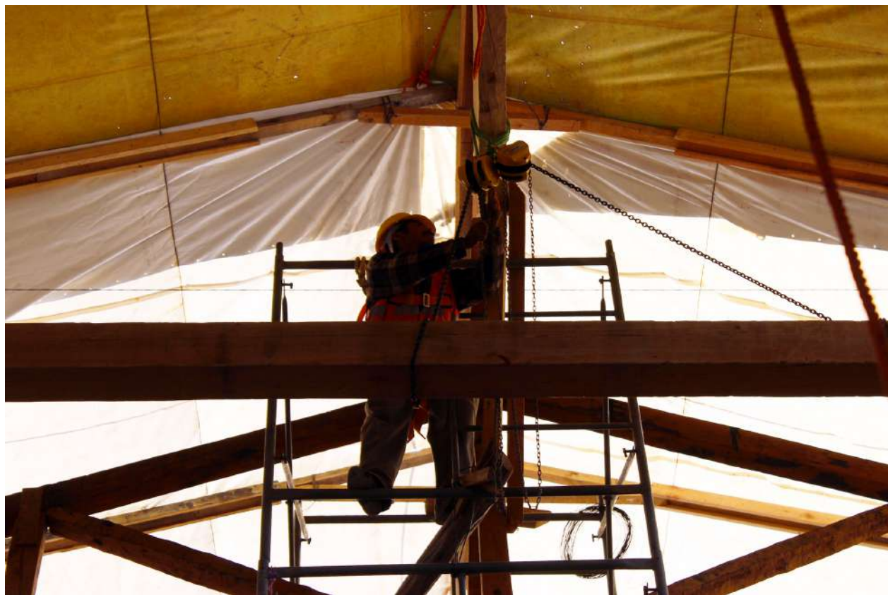
Colocación de vigas.
