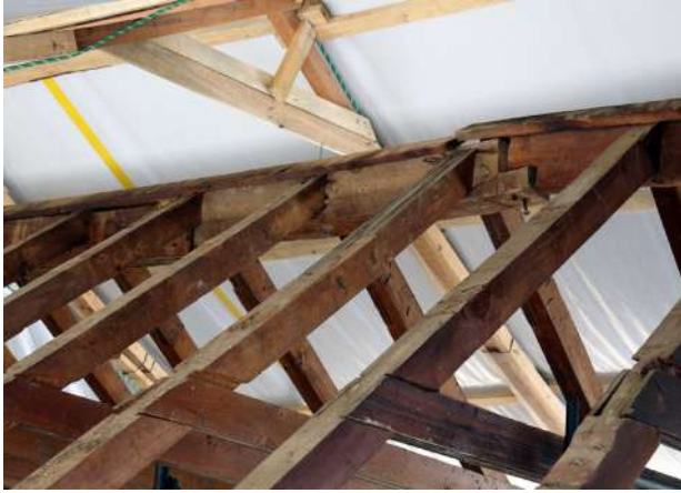
Armadura de madera, vigas par, nudillos y viga cumbrera.
