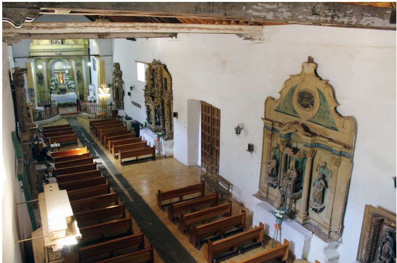
Vista desde el coro hacia la nave principal del templo, al fondo se aprecia el presbiterio.
