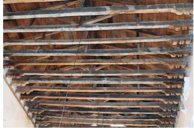
Sistema de cubierta del templo.
