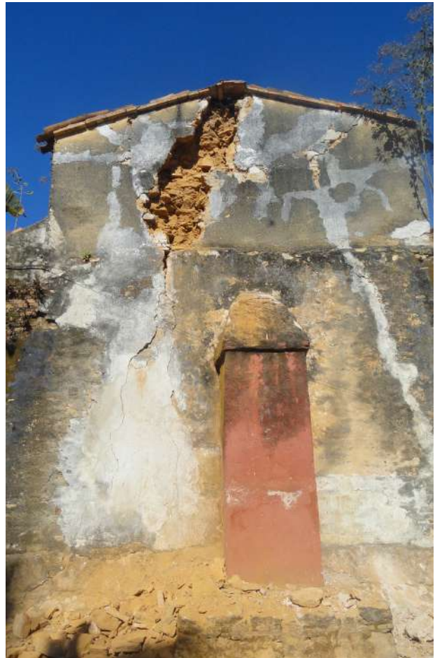
Muro testero del templo.
