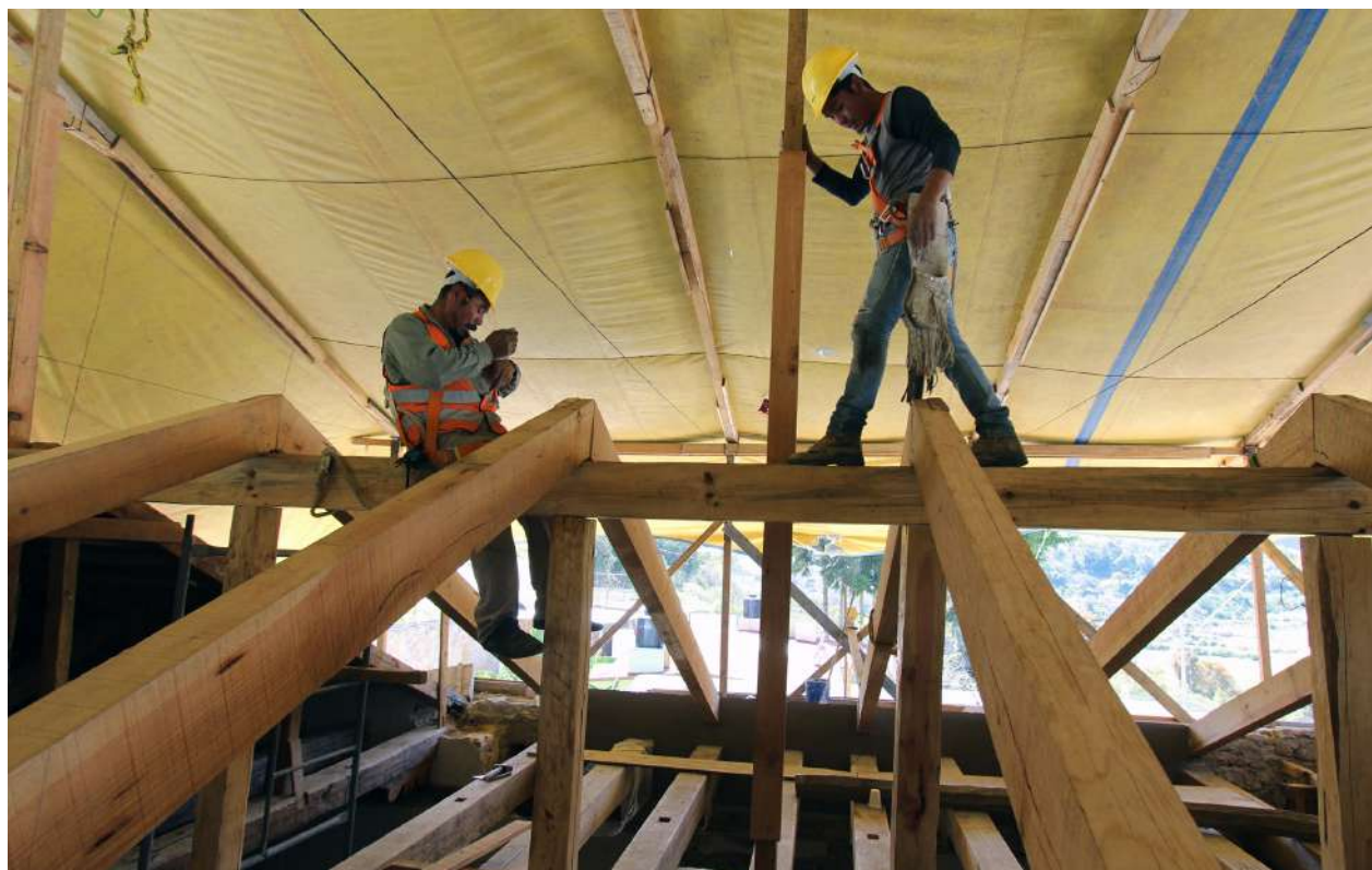
Integración de estructura, pendolones, cumbra y vigas par sobre vigas de carga.
