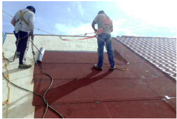
Integración de impermeabilizante de membrana en los paneles de madera, ubicado sobre la estructura de montenes.
