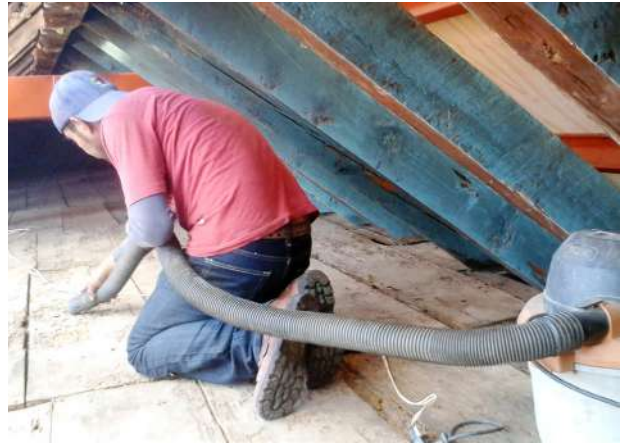
Uso controlado de aspiradora para la limpieza de la estructura de madera.
