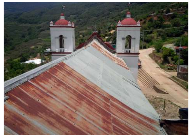
Abajo: Cubierta de dos aguas que protege la nave y el coro del templo.
