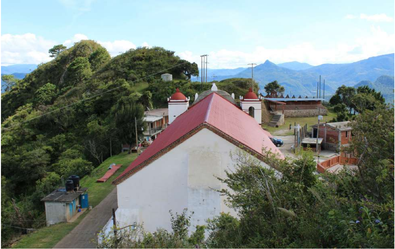
Intervención de la cubierta del templo.
