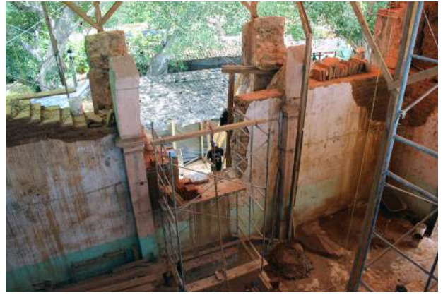
Reconstrucción del muro lateral de la nave.
