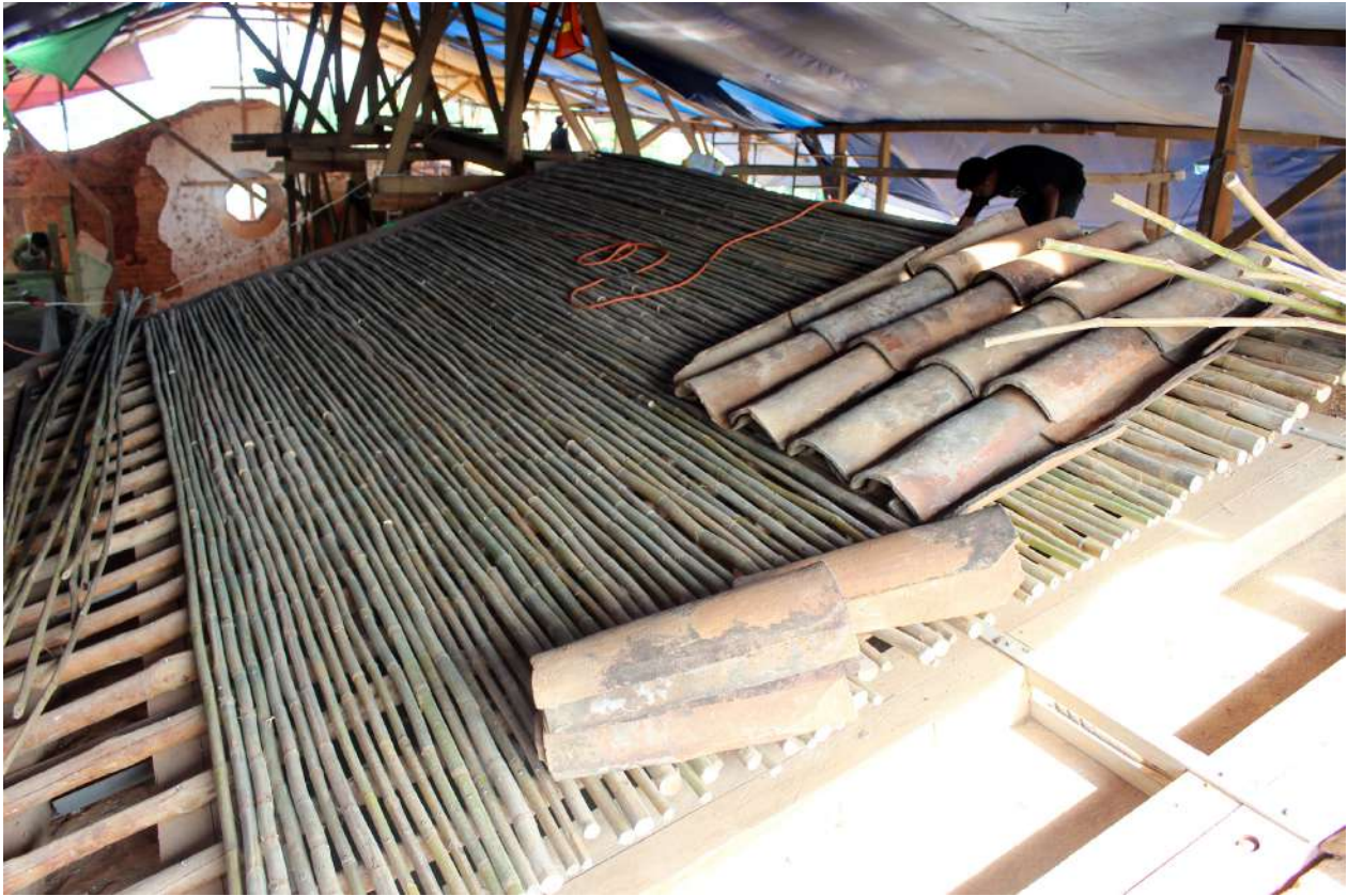
Integración de teja reutilizada en cubierta del presbiterio.
