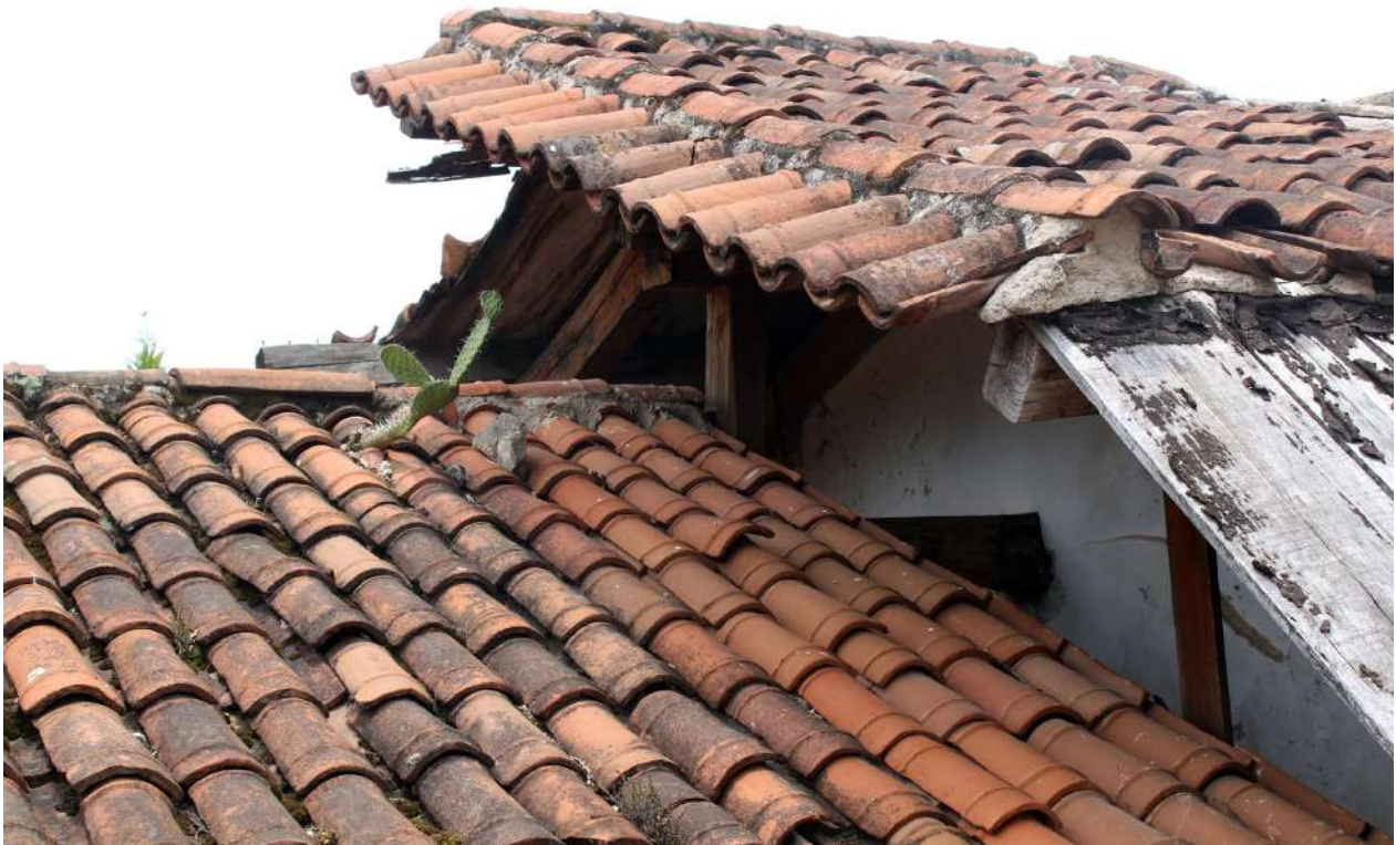
Detalle de cubierta que protege el área del coro.
