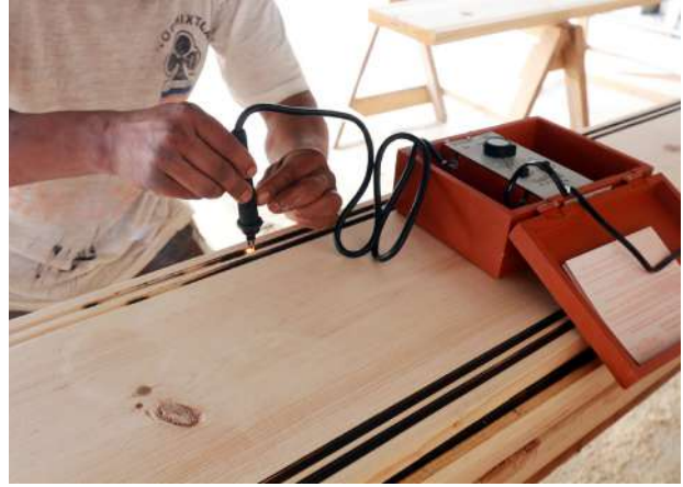
Recuperación de elementos ornamentales de la armadura.
